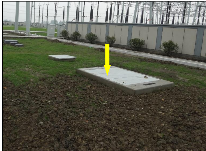
图 9-1 500kV 高邮变电站站区内化粪池
