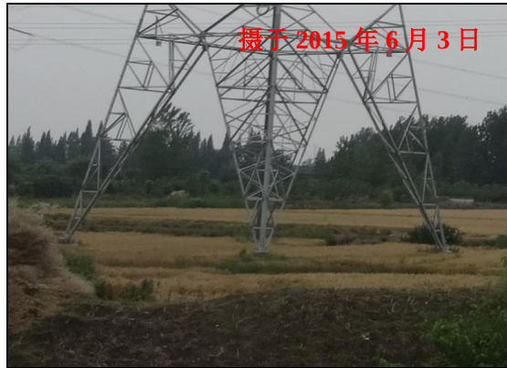
图 6-2 500kV 上邮 5684 线新建#152 塔基恢复示例
