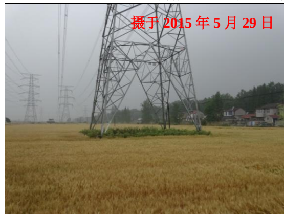
图 6-3 500kV 上邮 5684/上高 5683 线牵张场恢复示例
