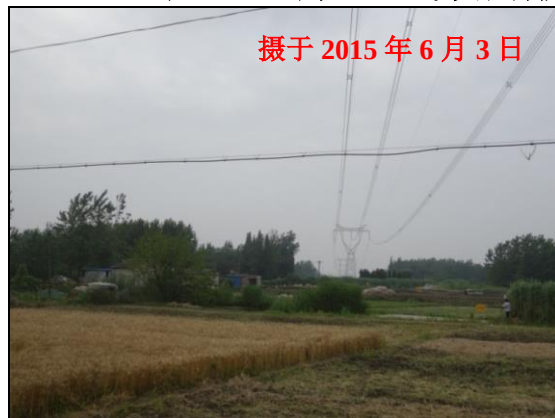
图 6-4 开断点处原线路拆除后塔基恢复农田种植示例
