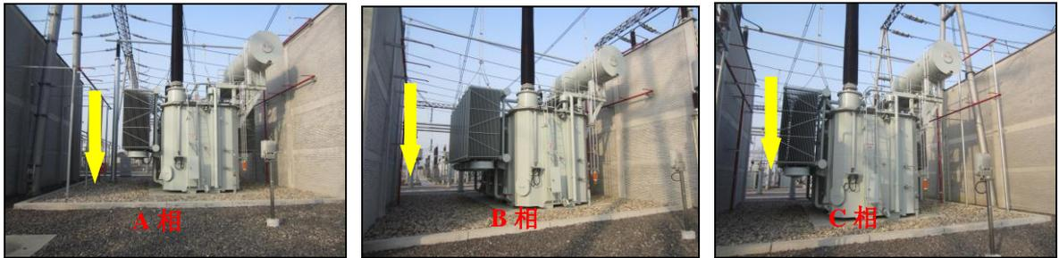
图 12-3 500kV 陆桥变原有#4 主变下方事故油坑
