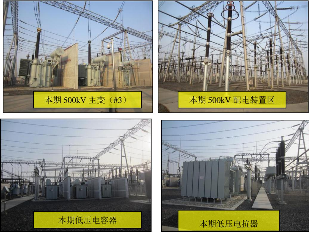
图 3-2 500kV 陆桥变电站本期建设工程
