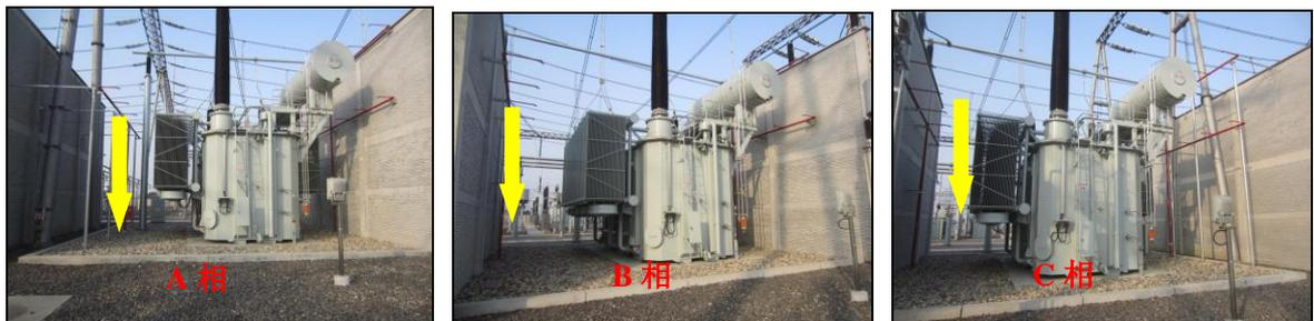
图 12-1 500kV 陆桥变本期扩建#3 主变下方事故油坑
