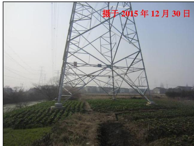
图 6-3 500kV 陆常 5620 线新建#23 塔（山桥 5268 线#23 塔）塔基恢复示例
