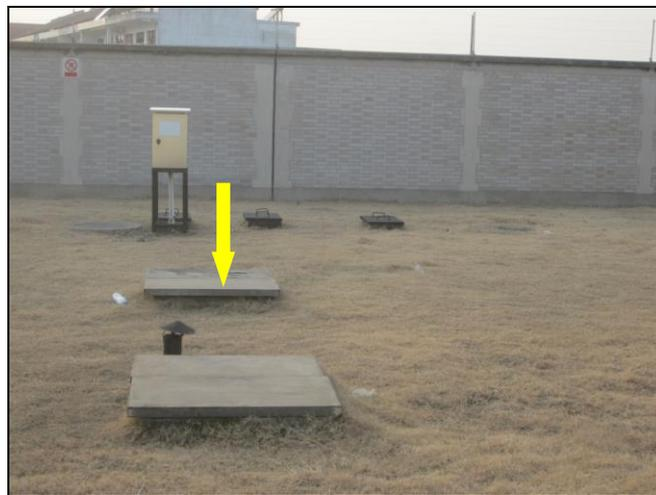
图 9-1 500kV 陆桥变电站内地埋式生活污水处理装置
