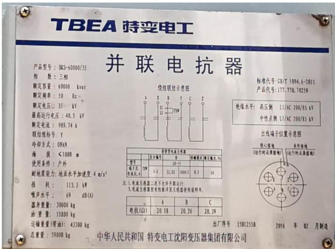
TBEA 特变电工并联电抗器，设备噪声水平 69dB (A)
