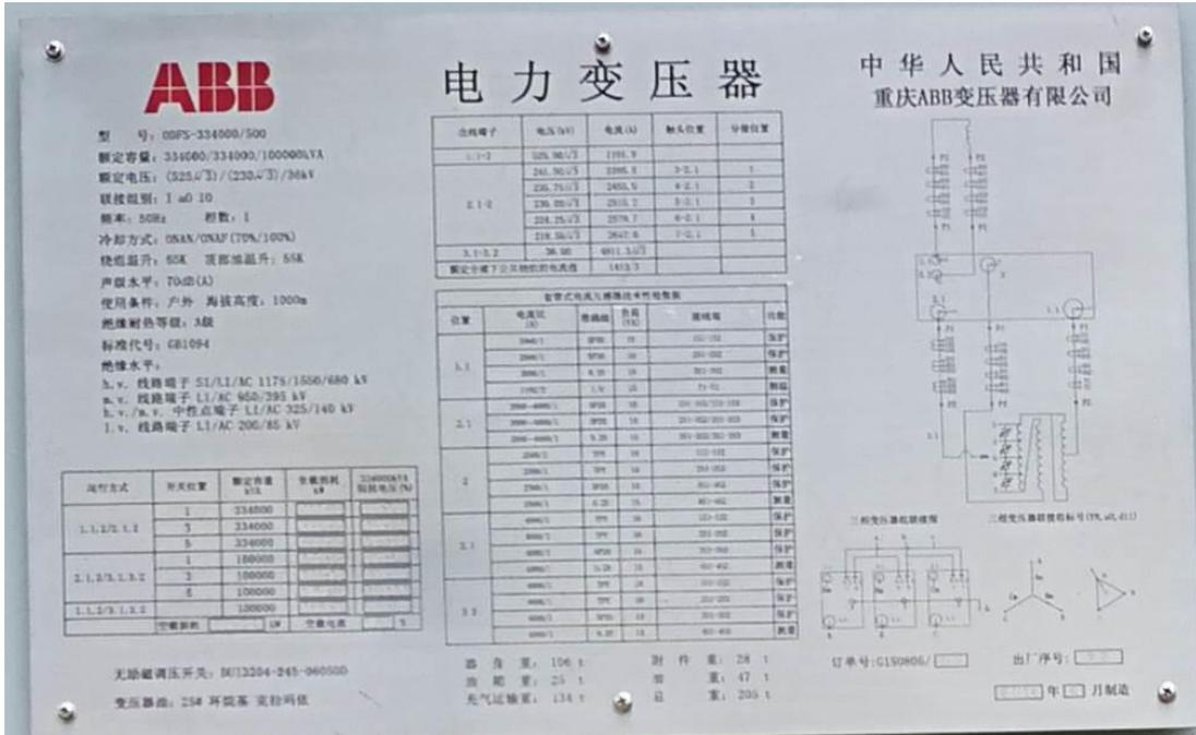
ABB 公司电力变压器，设备噪声水平 70dB (A)
