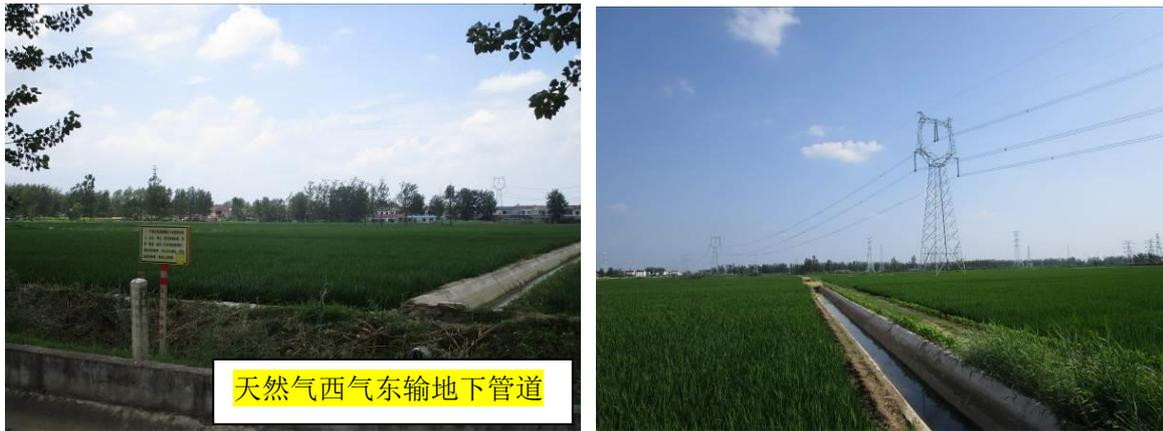
单回线路 2 次跨越西气东输管线（岱山侧） 建成 500kV 单回线路段  $\pi$  接点情况
