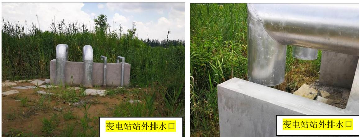
变电站站外排水口（均为雨水排口，根据节能需要设置 4 个排水口）
