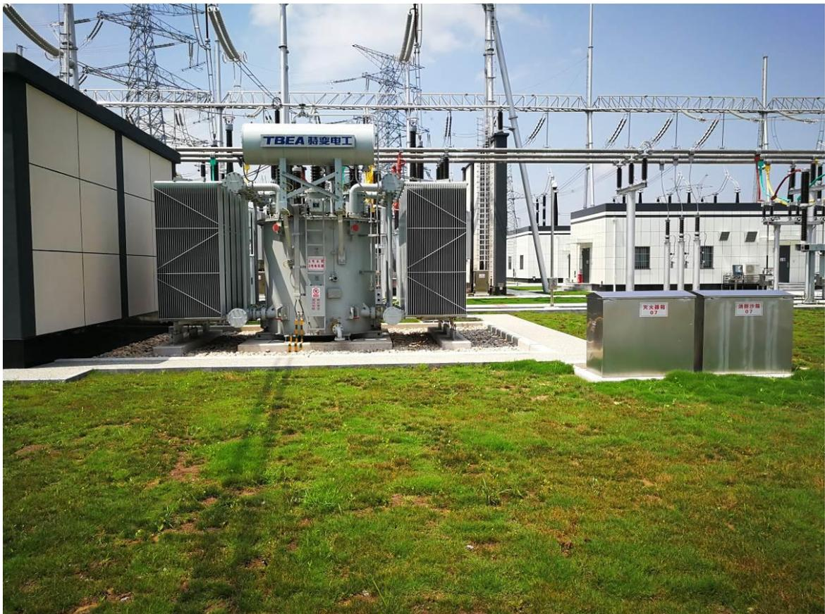
图 5.4 并联电抗器设置防火防爆墙
