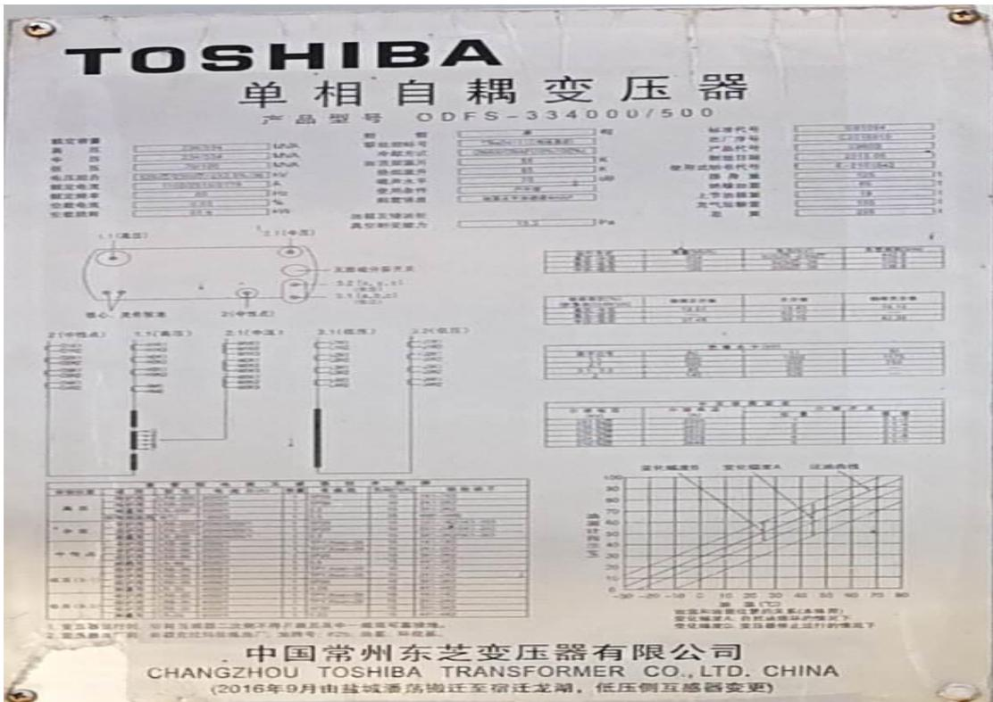
TOSHIBA 公司单相自耦变压器，设备噪声水平 70dB (A)
