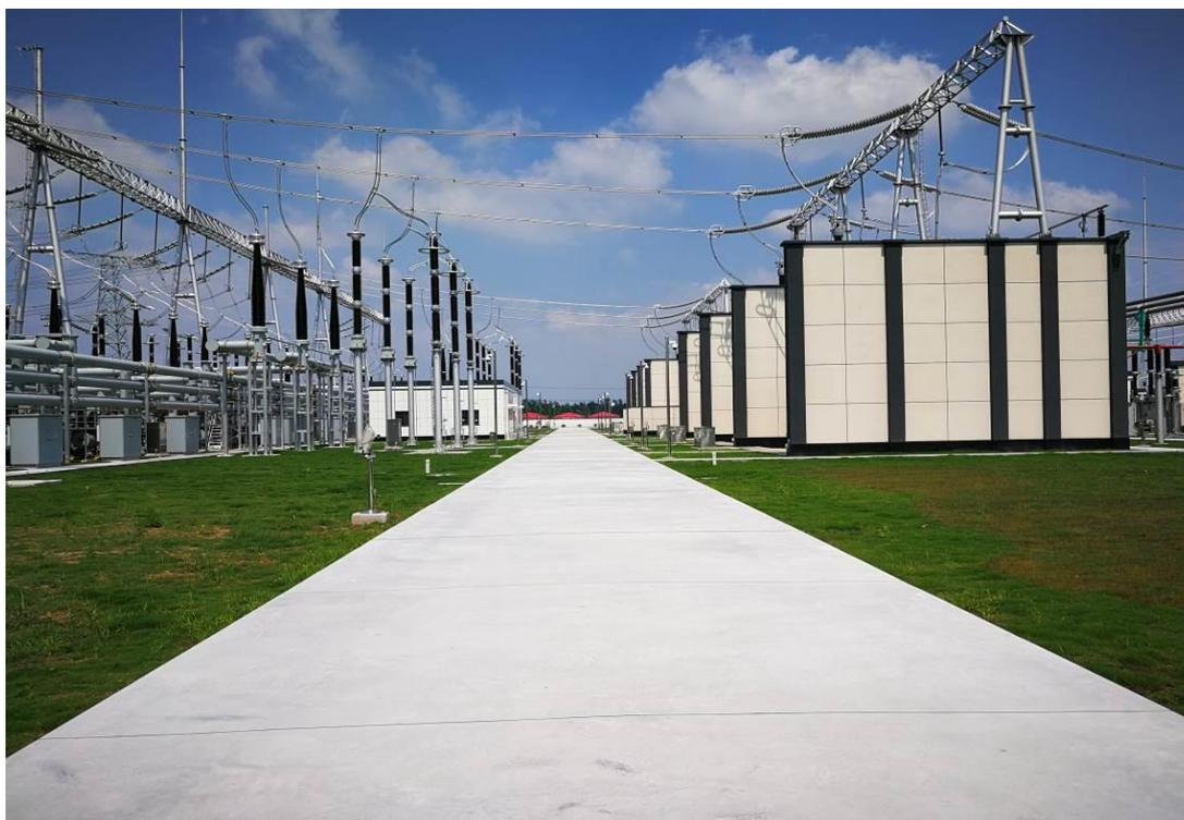
图 5.3 主变压器之间防火防爆墙
