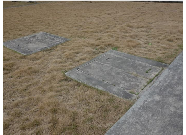
图 12.1-1 双草变电站本期建设的电抗器事故油坑及站内事故油池
