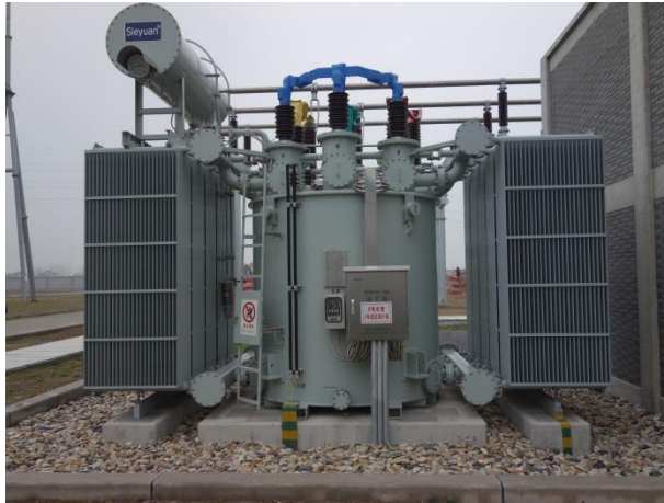
图 12.1-1 双草变电站本期建设的电抗器事故油坑及站内事故油池
