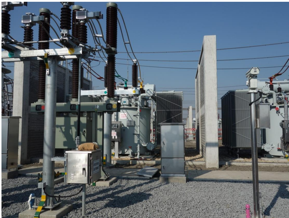
图 3.1-4 500kV 凤城变本期扩建低压电抗器
