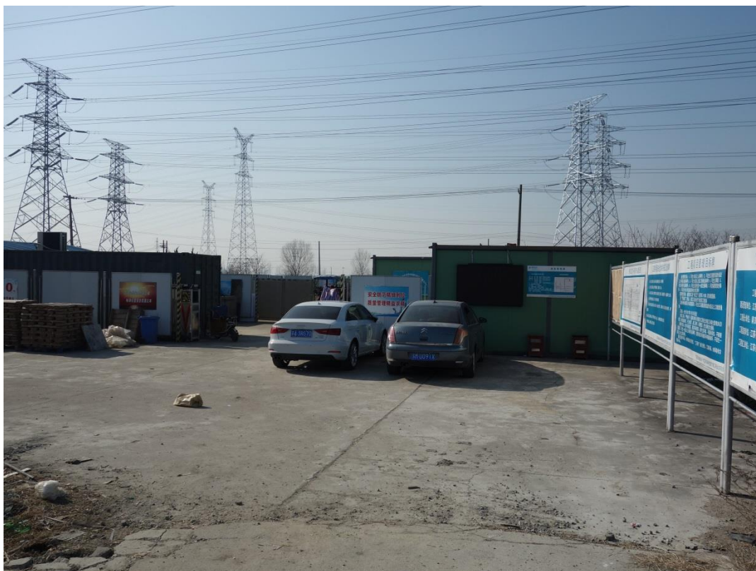
图 2.6-5 500kV 凤城变电站环境敏感目标照片
