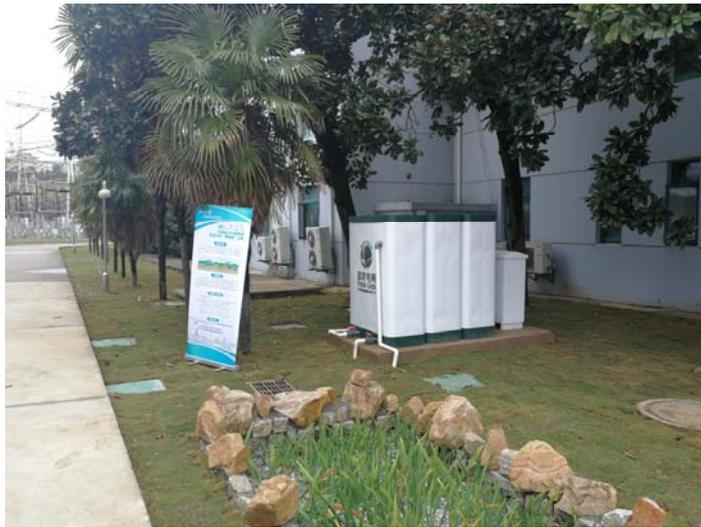
图 3.13 变电站设置的污水处理装置
