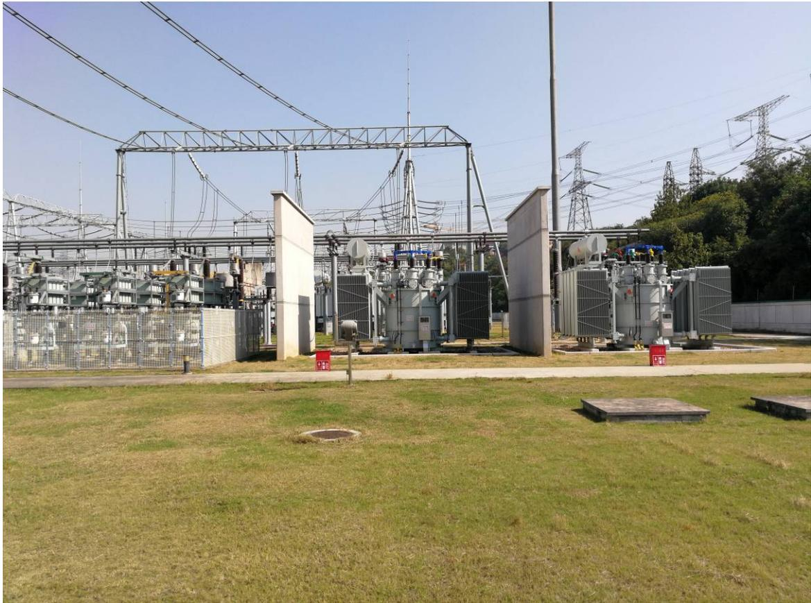
在原#3 主变新建的低压电抗器，靠近东侧围墙没有设置防火防爆墙
