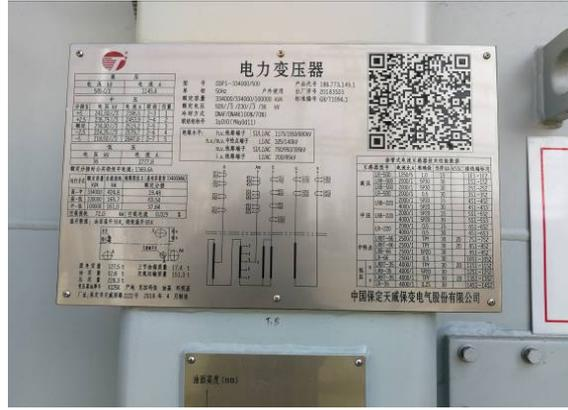
图 5.1 本期扩建主变压器、低压电抗器的设备铭牌
