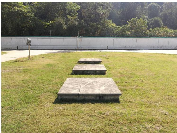
图 3.10 变电站前期工程设置事故油池
