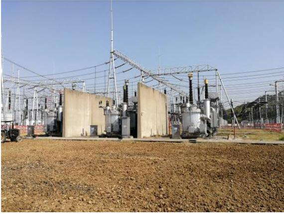
2#主变压器已拆除待运出
