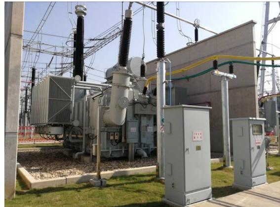
图 5.2 本期扩建主变压器（三相分体布置）、低压电抗器两侧的防火墙
