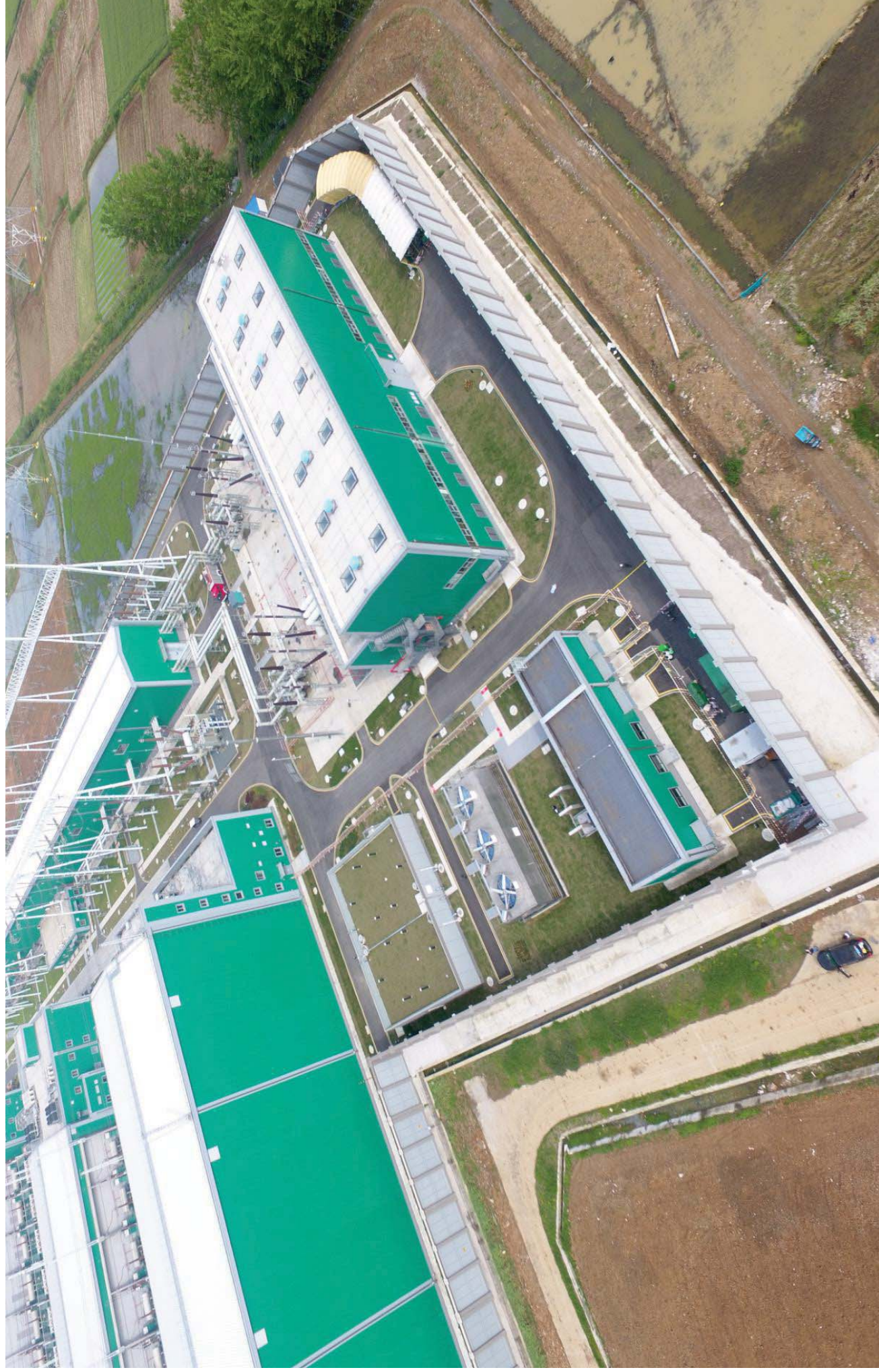
2019 年 3 月 9 日（建设后） 调相机站区
