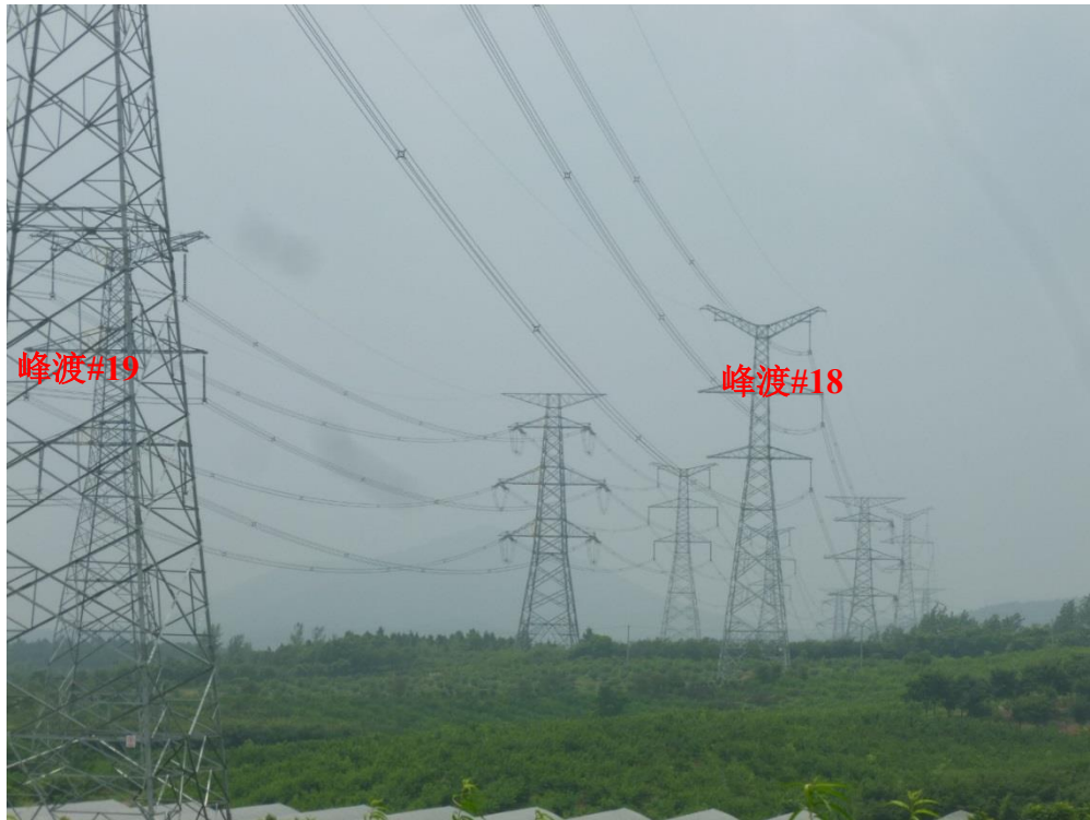
图 6-1-3-2 本工程线路穿越溧阳瓦屋山森林公园二级管控区照片
