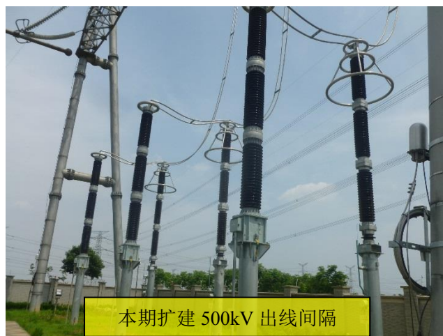
图 3-3 500kV 西津渡变电站本期建设工程
