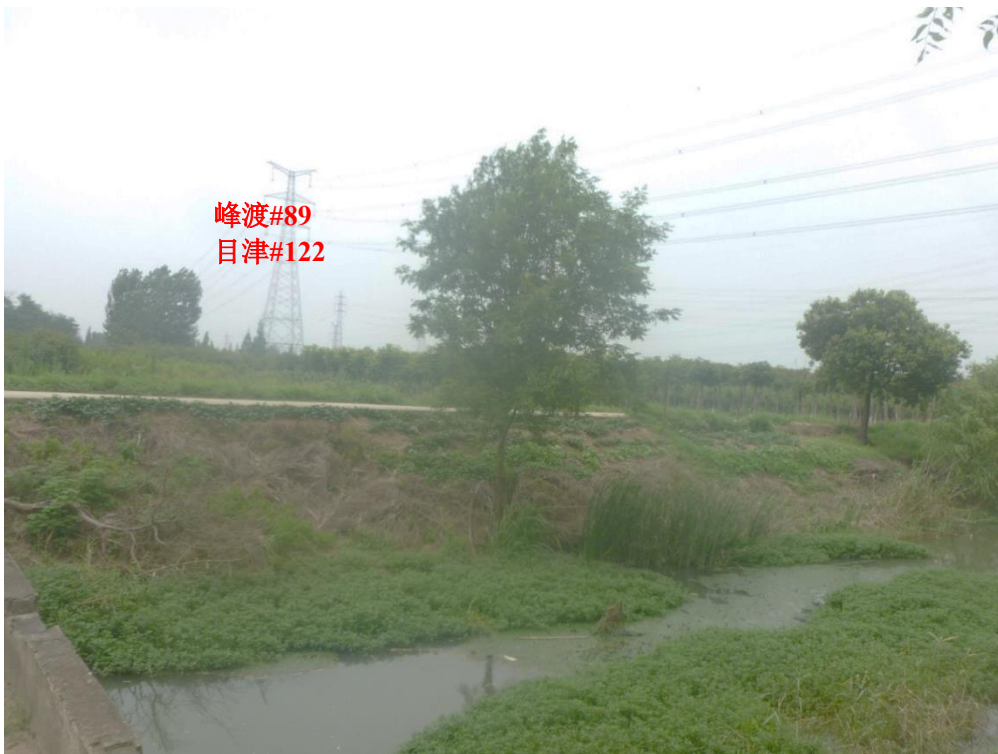
图 6-1-1-2 本工程线路穿越句容中河洪水调蓄区照片
