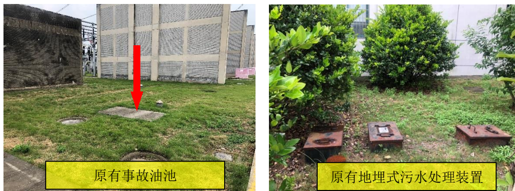
图 3-6 500kV 廻峰山变电站原有工程环保措施
