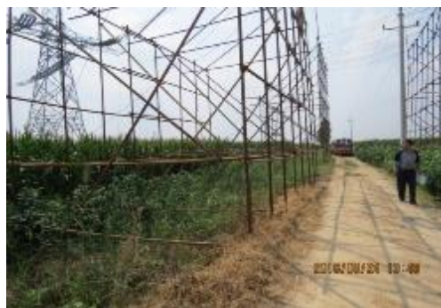
跨越场地激光测距仪实地测量
