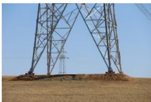
塔基区土地整治
