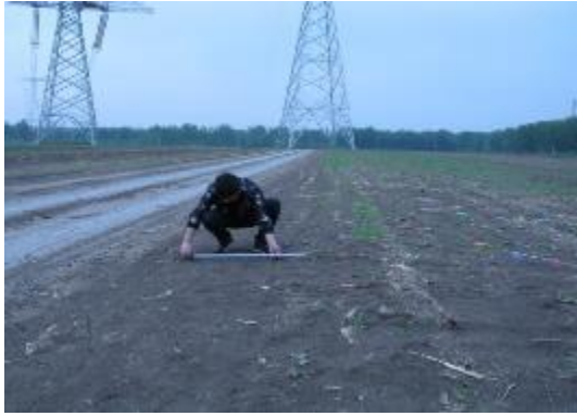
施工道路监测点
