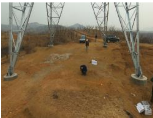
巡查点（冀北线路工程）
