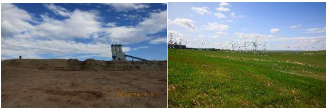
施工生产区土地整治
