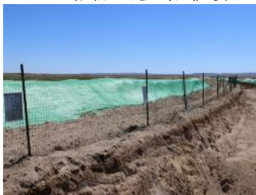
巡查点 (电极电缆区-开挖断面)
