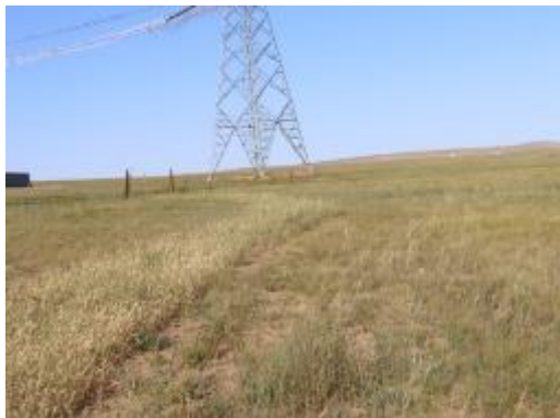
施工与人抬道路植物措施
