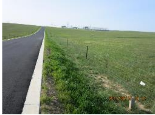
进站道路两侧植物措施
