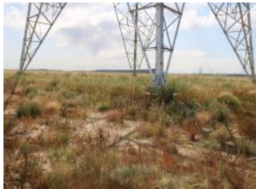
塔基区植物措施
