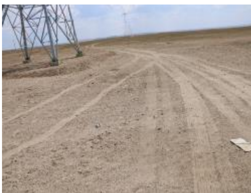
巡查点（线路工程施工与人抬道路）
