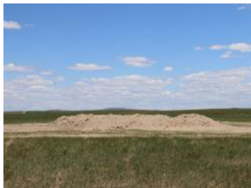
巡查点 1 (塔基区基础施工)
