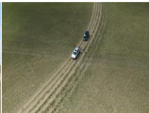
巡查点 2 (施工与人抬道路)
