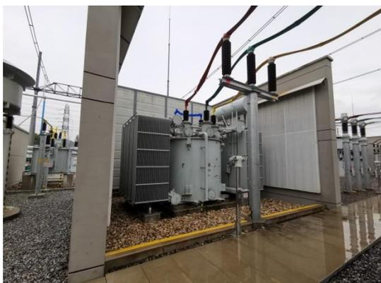
3#低压电抗器南侧、北侧、东侧隔声屏障
