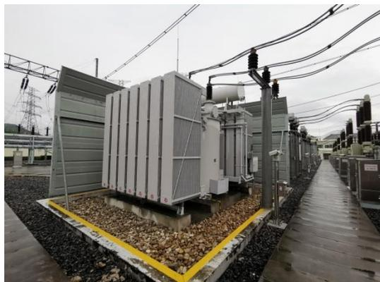
2#低压电抗器南侧、东侧隔声屏障
