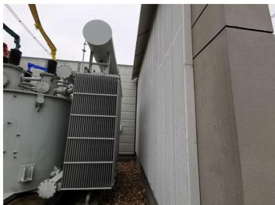
低压电抗器隔声屏内侧吸声材料
