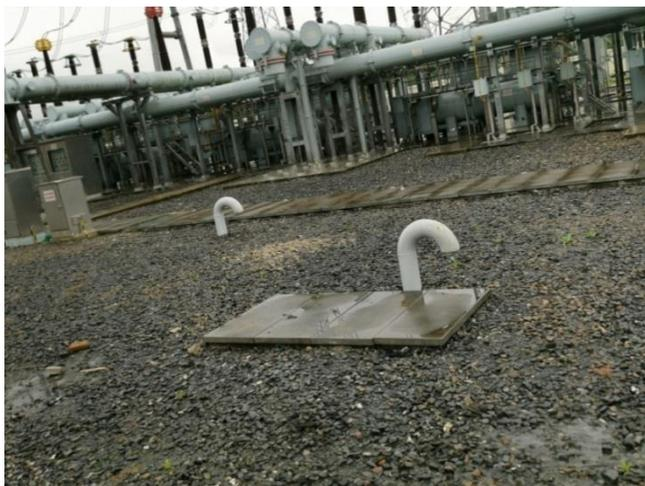
图 3-5 木渎 500kV 变电站事故油池
