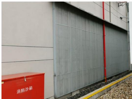
主变防火墙内侧吸声材料
