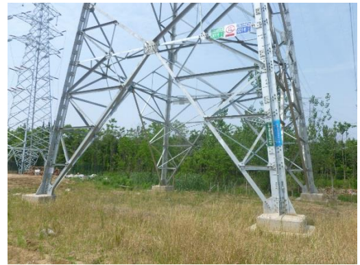
220kV 永周 4M76/永方 4M75 线#1 塔基周围生态恢复示例
