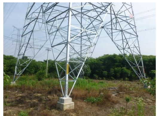
220kV 廻永 2Y09/ 2Y10 线#63 塔基周围恢复示例
