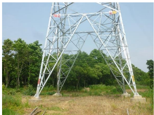
220kV 永旧 4M77/4M78 线#1 塔基周围恢复示例
