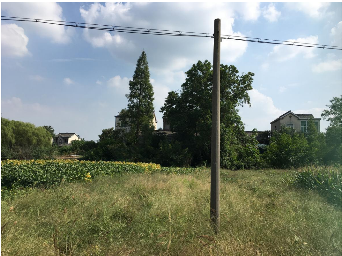
架空线路沿线现状
