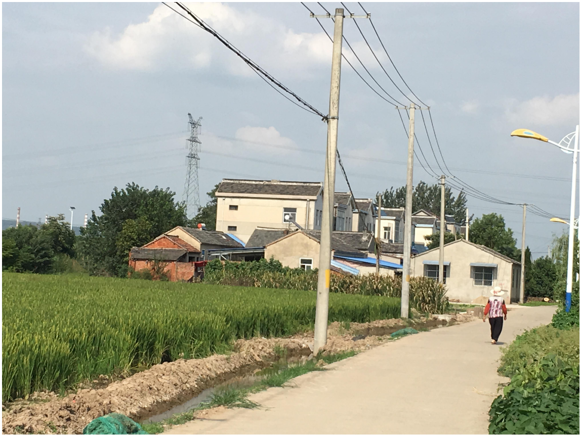
电缆沿线现状
