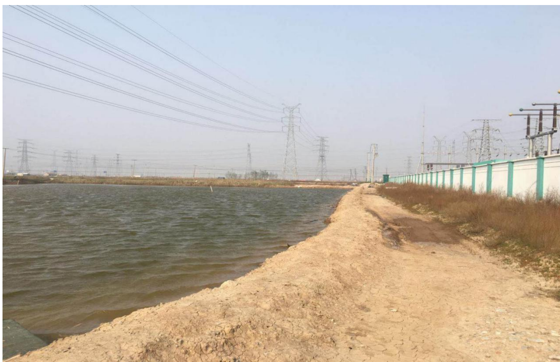
站址现状图 2：站区南侧扩建区域
