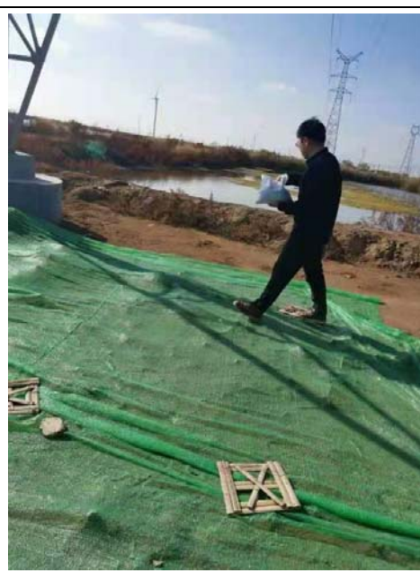
塔基区撒播草籽 T4 (2020.11)
