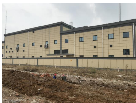
图 4 土地移交后变电站西侧现状照片（摄于 2020 年 10 月）
