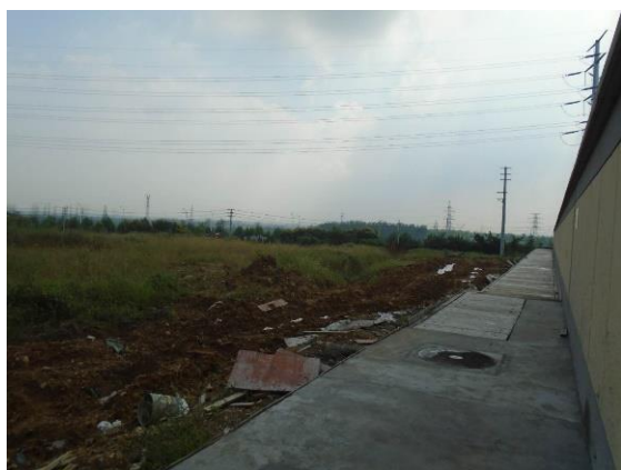
图 1 竣工后变电站北侧土地整治与植被恢复情况（摄于 2020 年 9 月）
