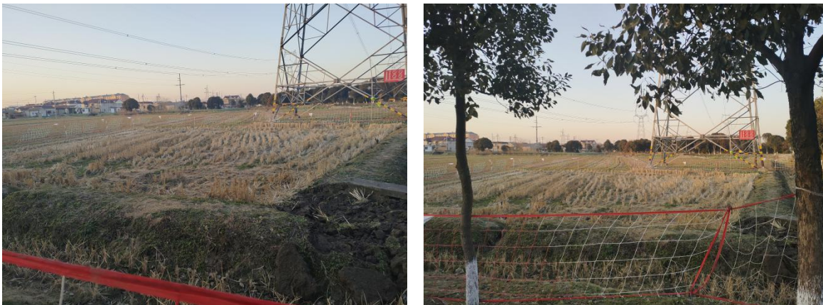
图 1.1 塔基区施工前占地
