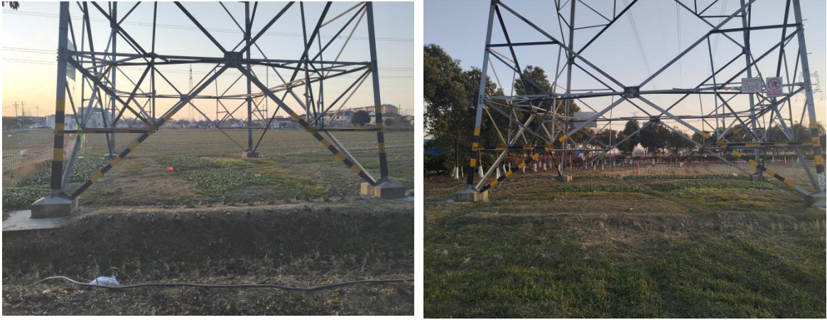
图 1.2 拆除区施工前占地
