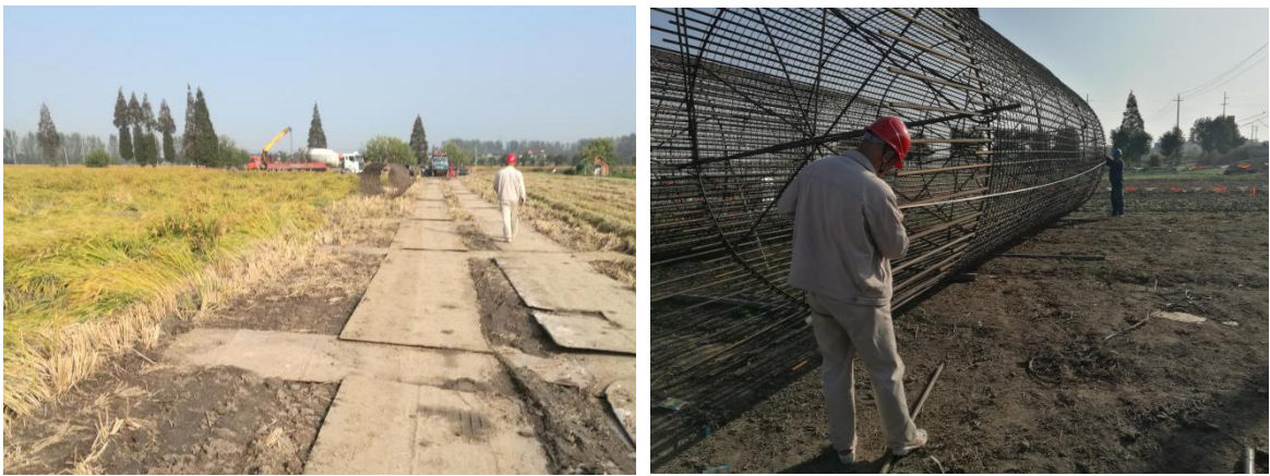
图 1.3 施工临时道路区和塔基区施工现场
