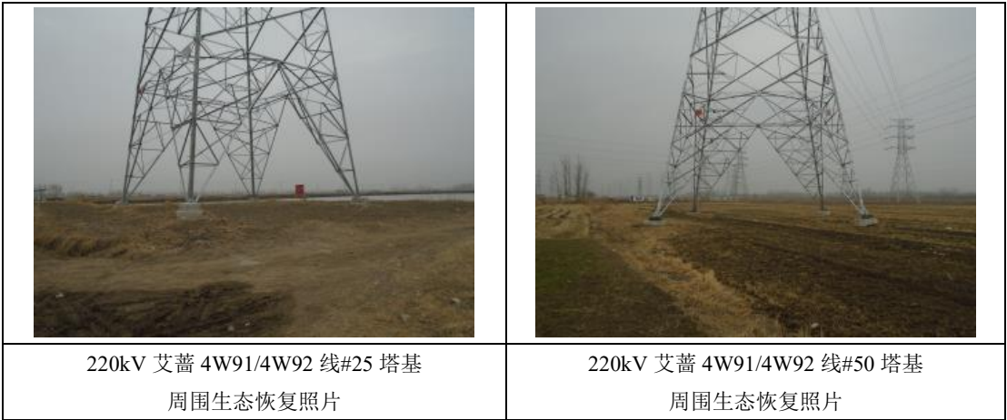
图 8-2 本工程生态恢复示例照片
