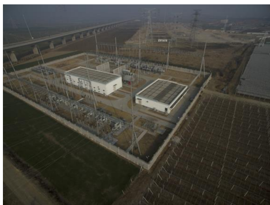
站区扩建区铺设草皮
