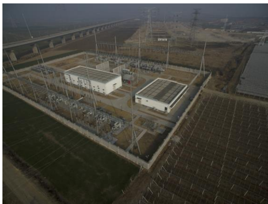
站区扩建区铺设草皮
