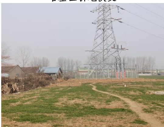
电缆施工区耕地恢复
