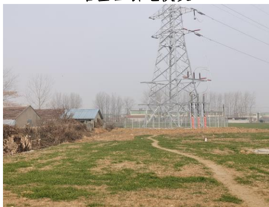
电缆施工区耕地恢复
