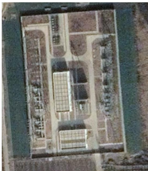
施工前遥感影像 2020 年 5 月
