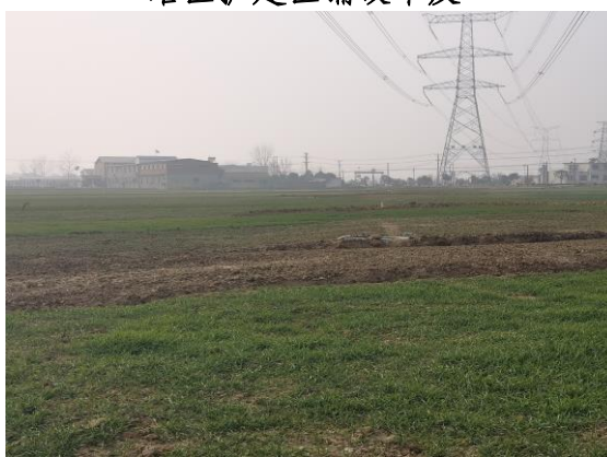
电缆施工区耕地恢复
