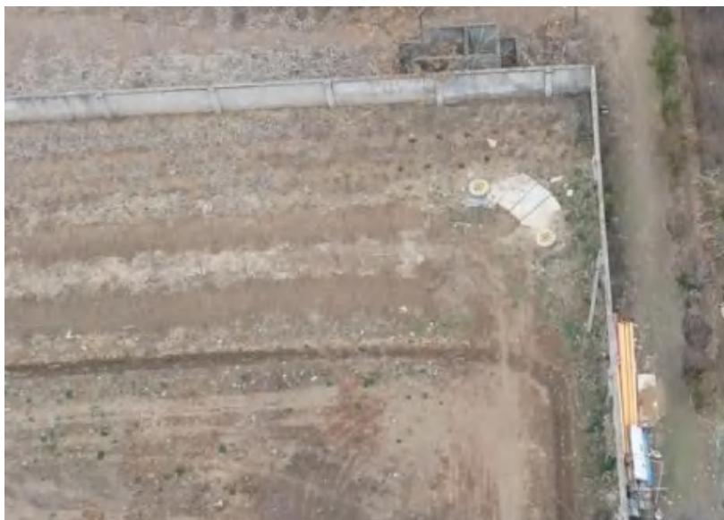
2021.2.21 地下电缆区复耕
