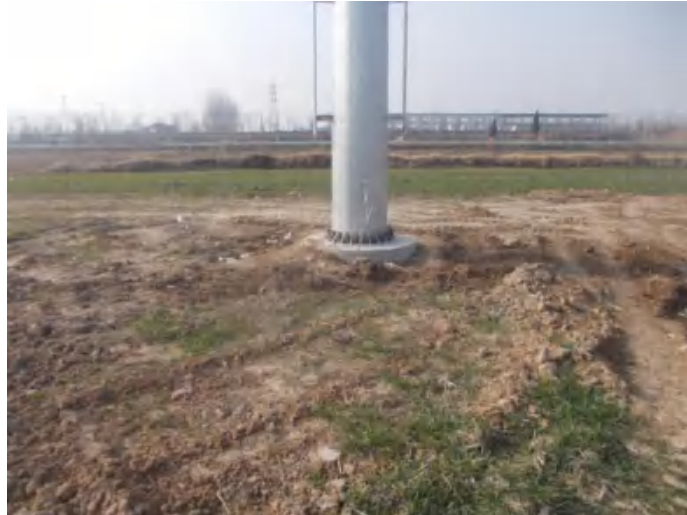
2021.2.06 18#塔 塔基区土地整治（复耕）
