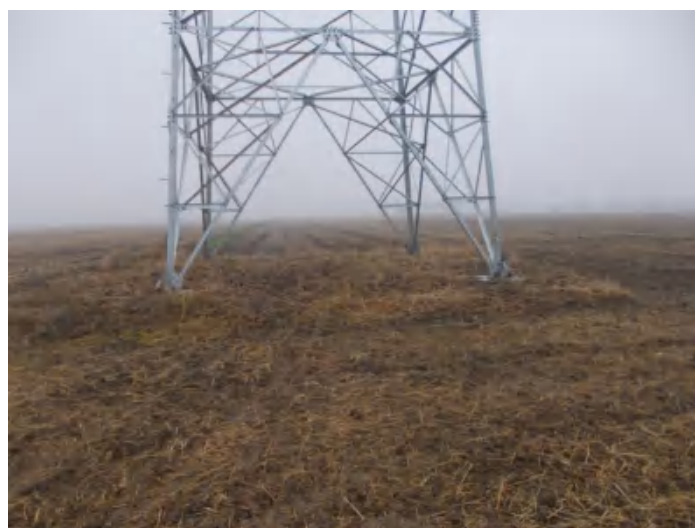
2021.2.06 11#塔 塔基区土地整治（复耕）
