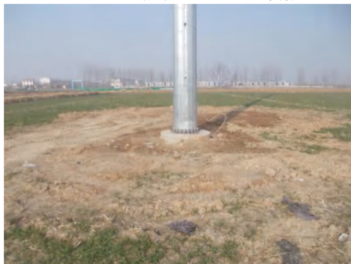
2021.2.06 8#塔 塔基区土地整治（复耕）
