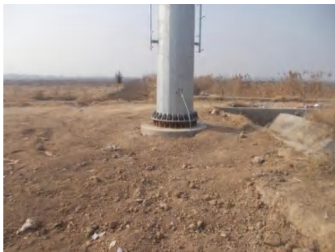
2021.2.06 6#塔 塔基区土地整治（撒播草籽）
