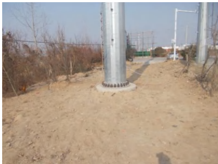
2021.2.06 4#塔 塔基区土地整治
