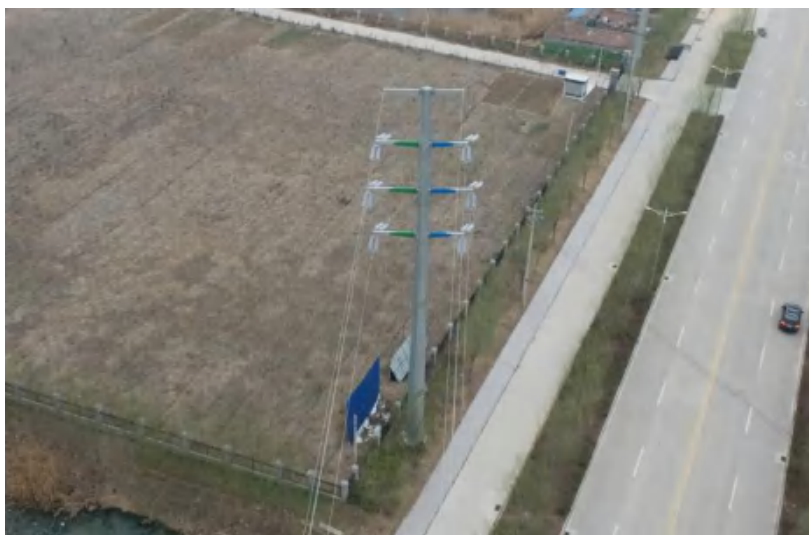
2021.2.21 塔基区撒播草籽
