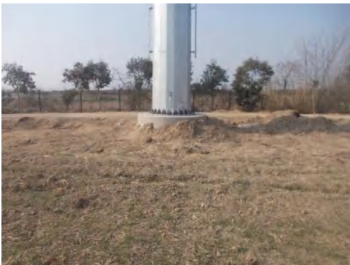
2021.2.06 5#塔 塔基区土地整治（复耕）
