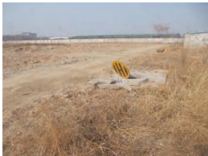
2021.2.06 地下电缆区土地整治（撒播草籽）
