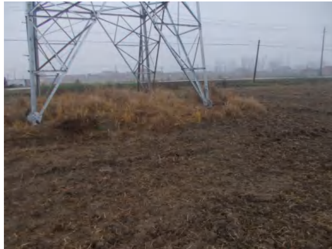
2021.2.06 10#塔 塔基区撒播草籽+复耕
