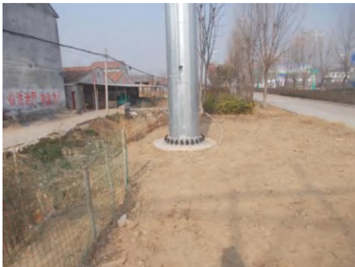
2021.2.06 2#塔 塔基区土地整治（撒播草籽）恢复
