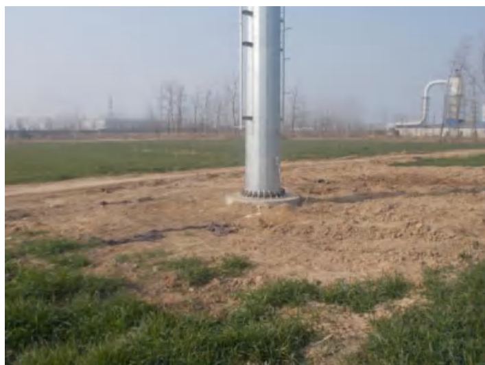
2021.2.06 15#塔 塔基区土地整治（复耕）
