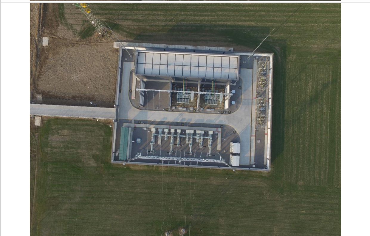
110kV 仙桃变、#1 塔基建设后航拍影像图
