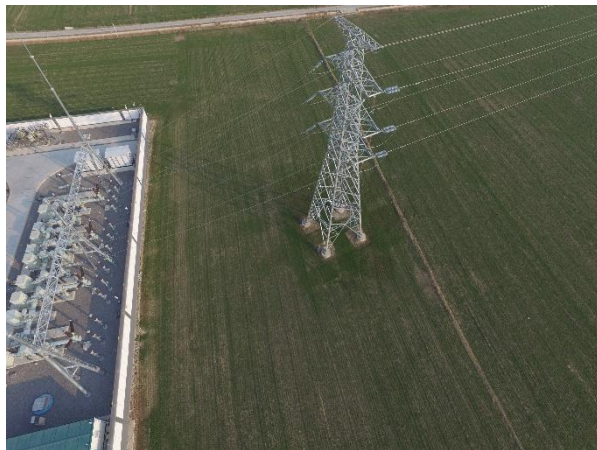
措施名称：施工临时道路区及塔基区复耕
