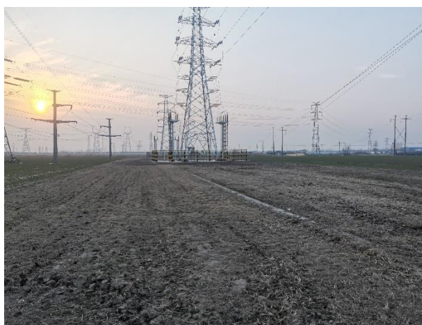
措施名称：电缆施工区撒播草籽
