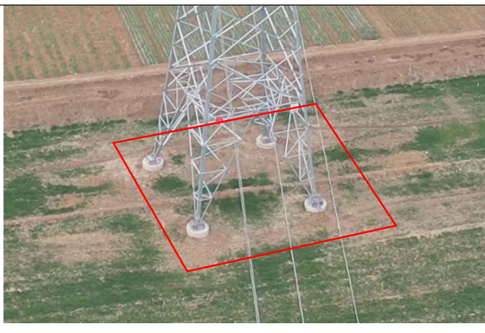
御窑-纪集 110kV 线路 T4 塔土地整治 (2021.02)
