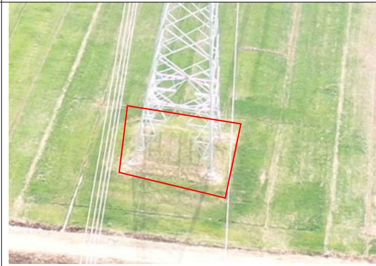
御窑-柳沟新建 110kV 线路 T5 塔土地整治 (2021.02)
