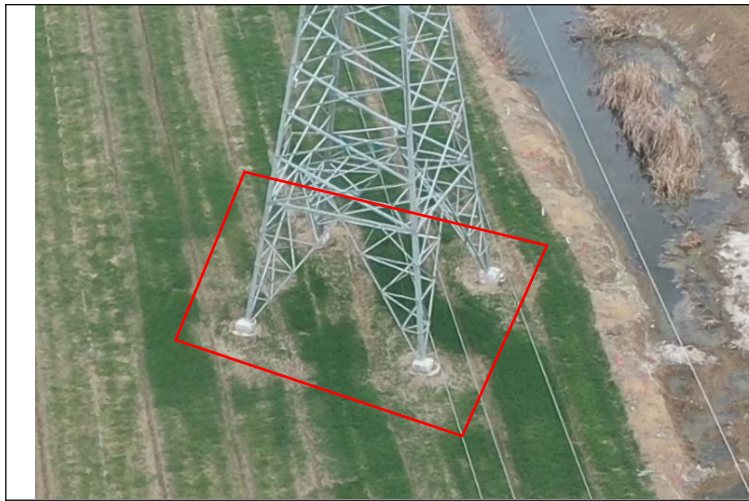
御窑-平墩 110kV 线路 T3 塔土地整治 (2021.02)
