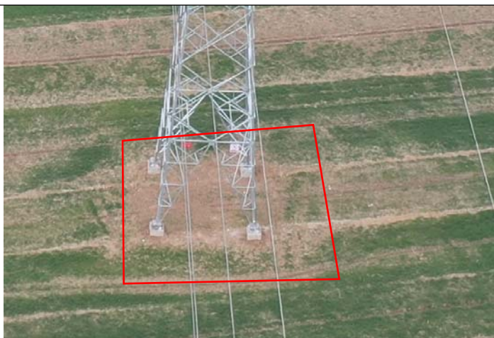
御窑-纪集 110kV 线路 T3 塔土地整治 (2021.02)
