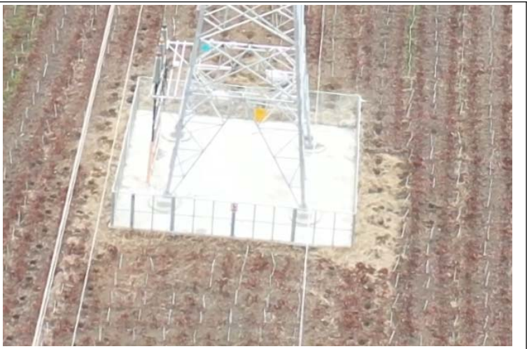
御窑-柳沟新建 110kV 线路 T9 电缆终端塔硬化+土地整治（2021.02）
