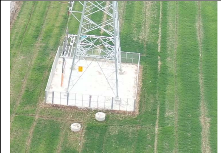
御窑-柳沟新建 110kV 线路 T10 电缆终端塔硬化+土地整治（2021.02）
