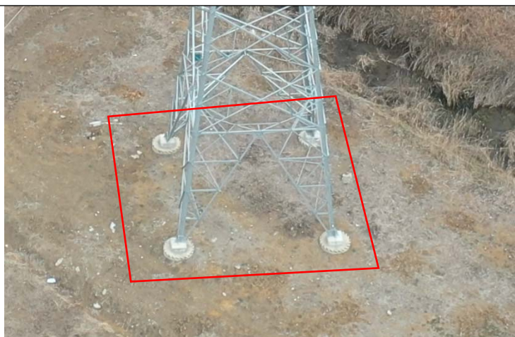
御窑-平墩 110kV 线路 T1 塔土地整治 (2021.02)
