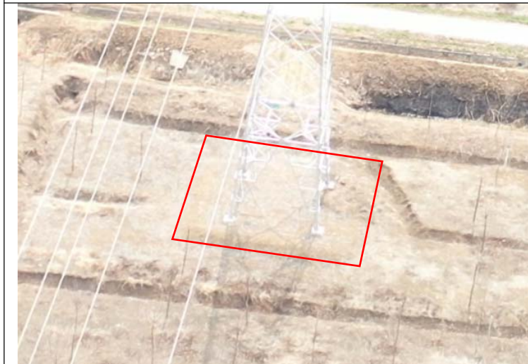
御窑-柳沟新建 110kV 线路 T4 塔土地整治 (2021.02)
