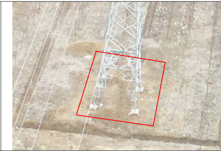
御窑-柳沟新建 110kV 线路 T3 塔土地整治 (2021.02)
