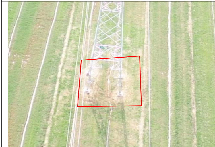
御窑-柳沟新建 110kV 线路 T6 塔土地整治 (2021.02)
