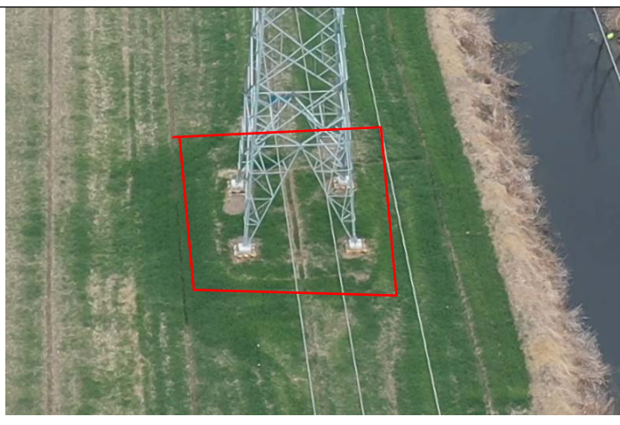
御窑-平墩 110kV 线路 T2 塔土地整治 (2021.02)
