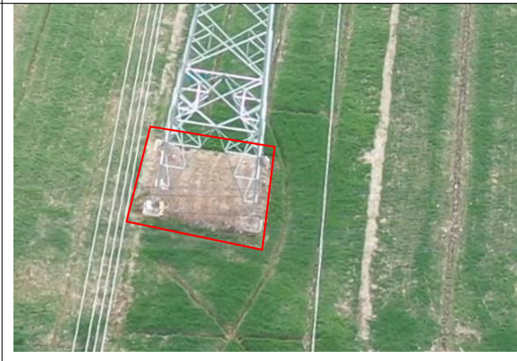
御窑-柳沟新建 110kV 线路 T7 塔土地整治 (2021.02)
