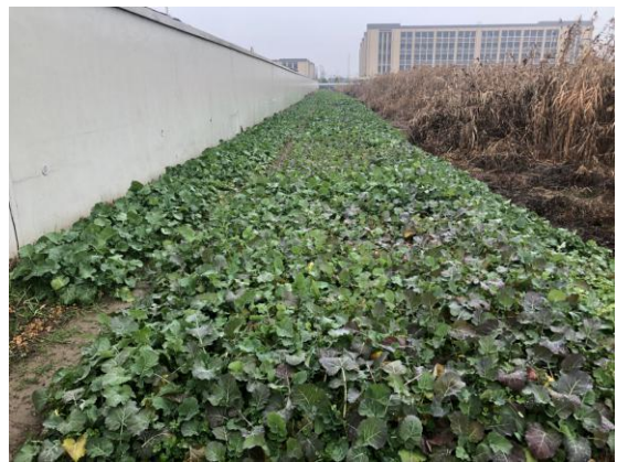
电缆施工区复耕 2020.12.14
