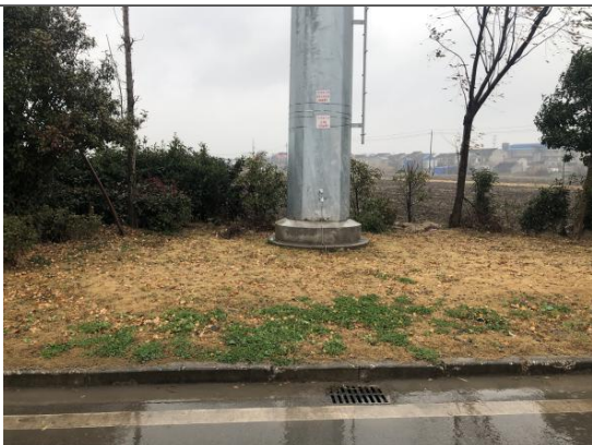
塔基及塔基施工区 31 号塔 植被恢复 2020.12.14
