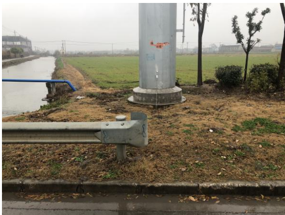
塔基及塔基施工区 34 号塔 植被恢复 2020.12.14
