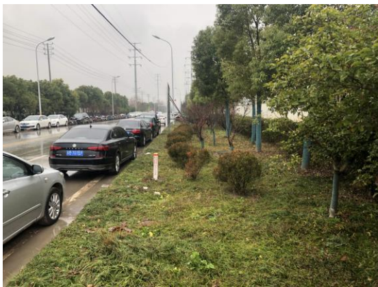
电缆施工区植被恢复 2020.12.14
