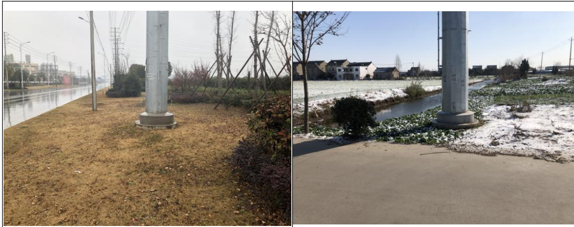
塔基及塔基施工区植被恢复、复耕（2020.12）
