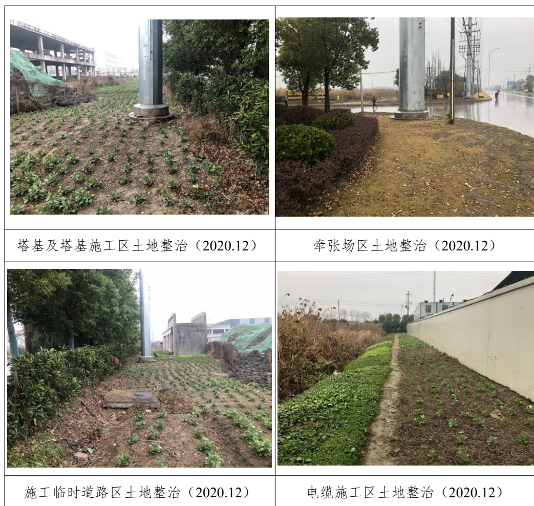
图 4-1 工程措施实施情况
