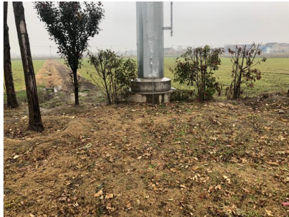
塔基及塔基施工区 33 号塔 植被恢复 2020.12.14
