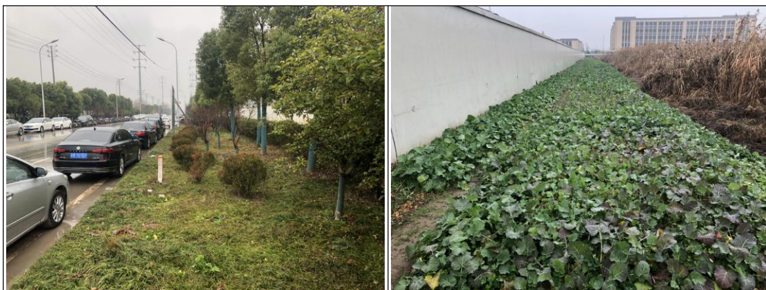
电缆施工区植被恢复、复耕（2020.12）
