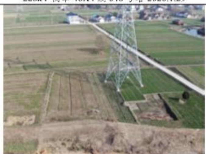
220kV 衡牵 46X4 线 048 号塔 2020.1.29
