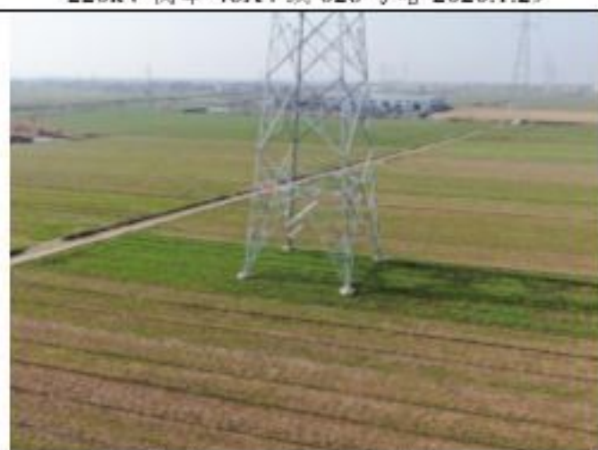
220kV 衡牵 46X4 线 028 号塔 2020.1.29
