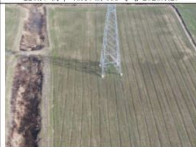
220kV 衡牵 46X4 线 037 号塔 2020.1.29
