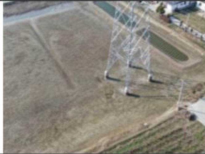
220kV 衡牵 46X4 线 051 号塔 2020.1.29
