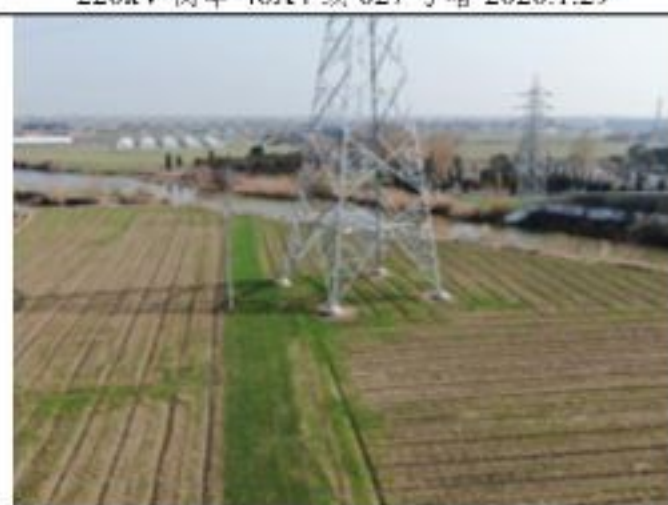
220kV 衡牵 46X4 线 029 号塔 2020.1.29
