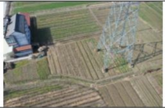
220kV 金牵 46X3 线 049 号塔 2020.1.28
