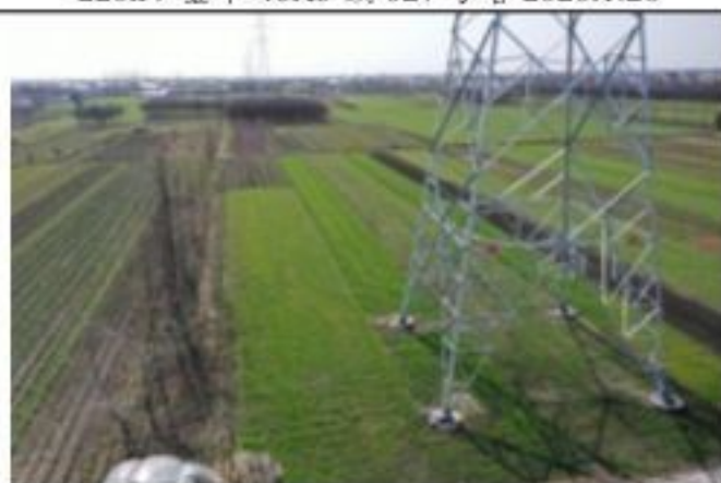
220kV 金牵 46X3 线 029 号塔 2020.1.28
