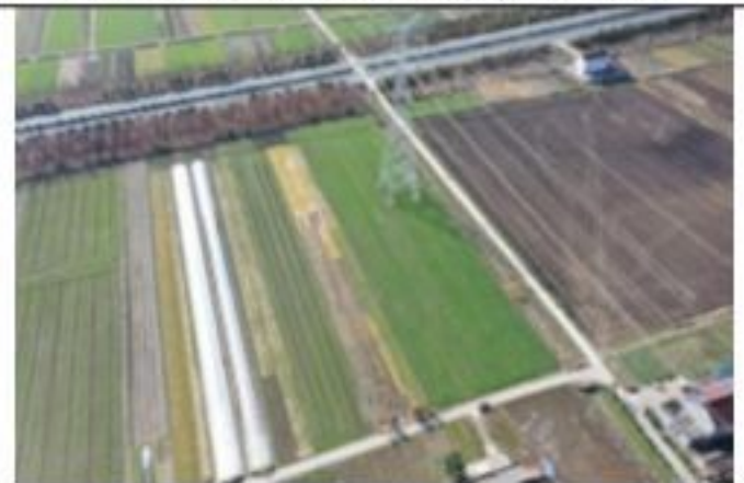
220kV 金牵 46X3 线 021 号塔 2020.1.28
