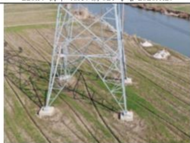
220kV 衡牵 46X4 线 023 号塔 2020.1.29
