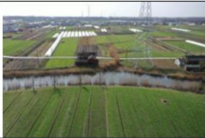
220kV 金牵 46X3 线 016 号塔 2020.1.28
