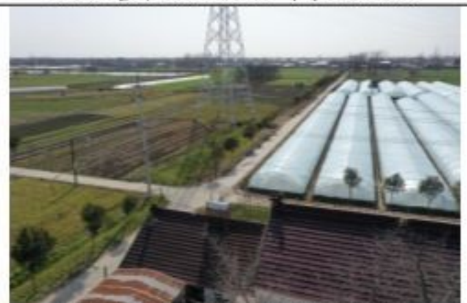
220kV 金牵 46X3 线 023 号塔 2020.1.28
