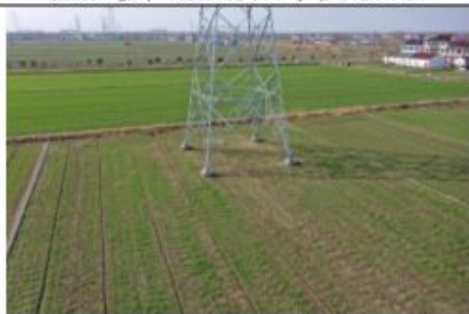
220kV 金牵 46X3 线 066 号塔 2020.1.28
