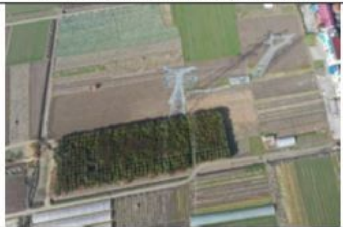
220kV 金牵 46X3 线 005 号塔 2020.1.28
