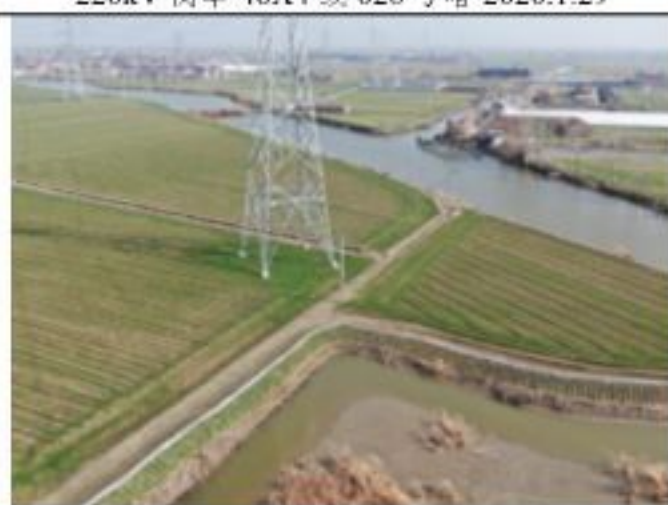
220kV 衡牵 46X4 线 030 号塔 2020.1.29
