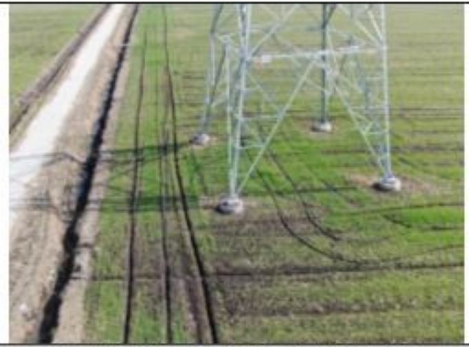
220kV 衡牵 46X4 线 010 号塔 2020.1.29
