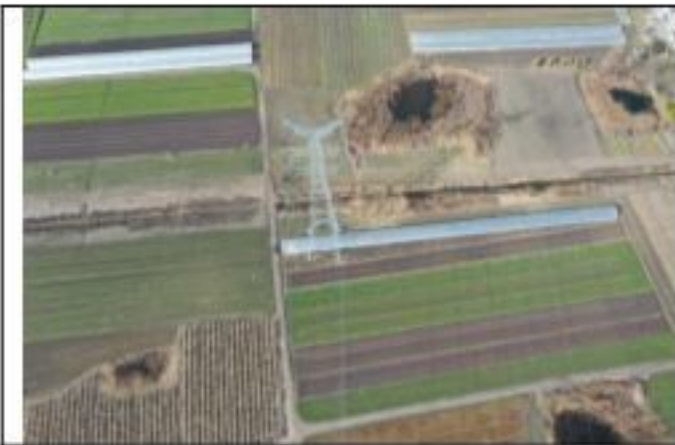
220kV 金牵 46X3 线 008 号塔 2020.1.28
