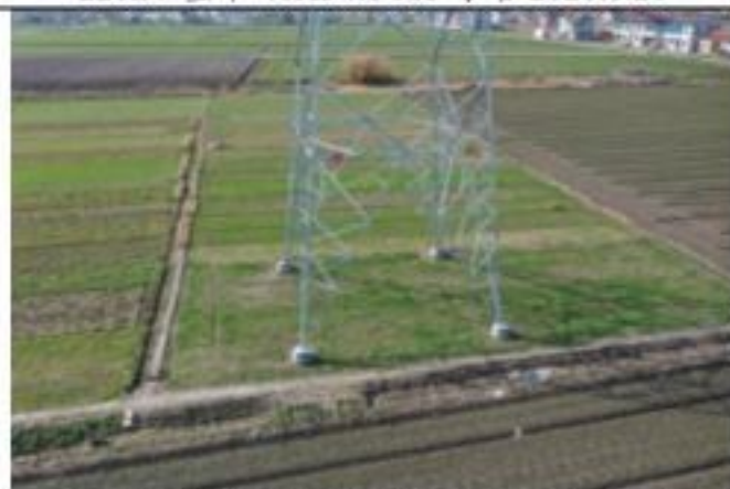
220kV 金牵 46X3 线 067 号塔 2020.1.28
