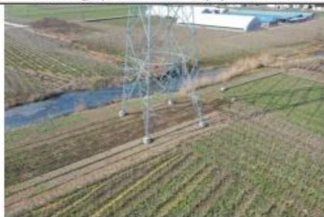
220kV 金牵 46X3 线 062 号塔 2020.1.28
