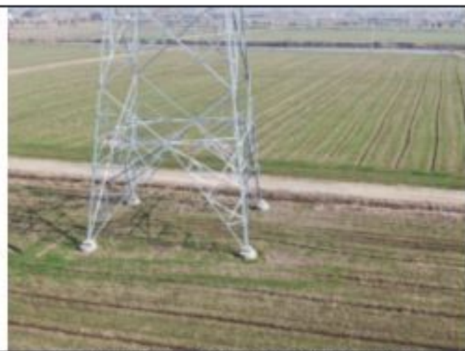
220kV 衡牵 46X4 线 018 号塔 2020.1.29
