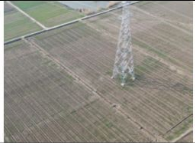
220kV 衡牵 46X4 线 052 号塔 2020.1.29
