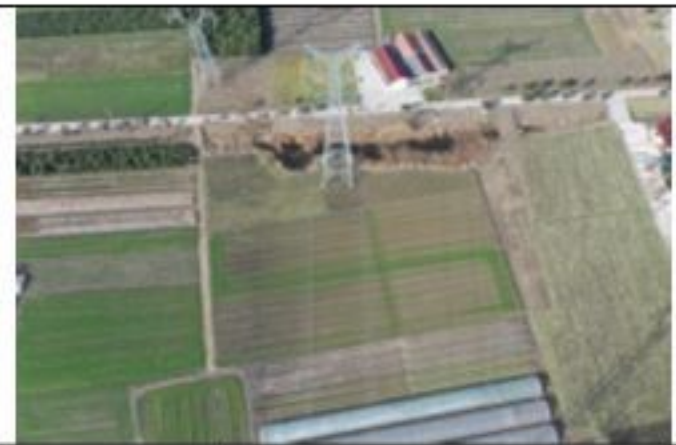
220kV 金牵 46X3 线 009 号塔 2020.1.28
