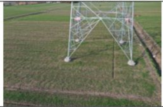
220kV 衡牵 46X4 线 084 号塔 2020.1.29
