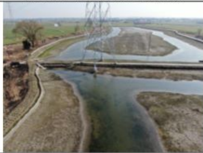
220kV 衡牵 46X4 线 013 号塔 2020.1.29
