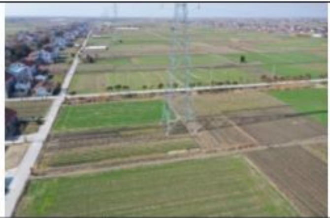
220kV 金牵 46X3 线 041 号塔 2020.1.28
