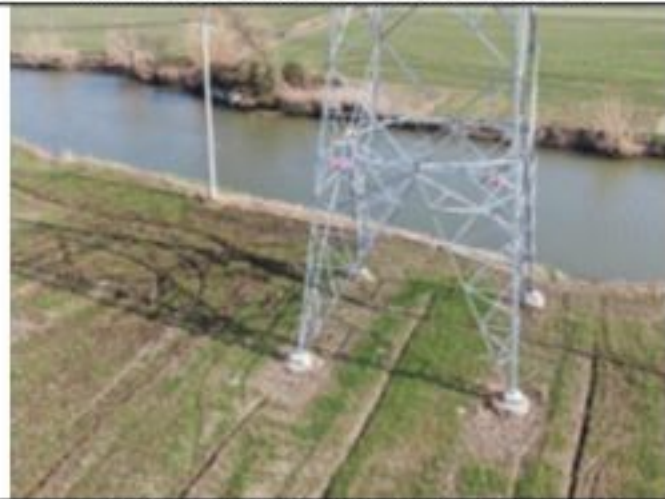
220kV 衡牵 46X4 线 015 号塔 2020.1.29
