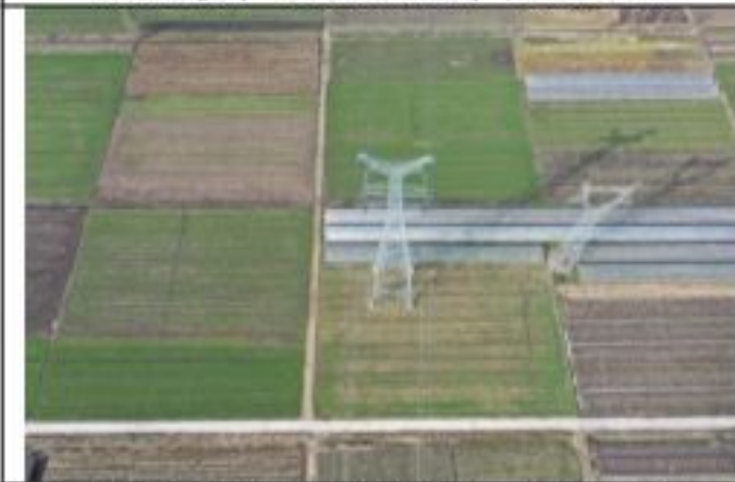
220kV 金牵 46X3 线 010 号塔 2020.1.28
