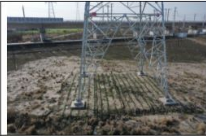
220kV 衡牵 46X4 线 089 号塔 2020.1.29
