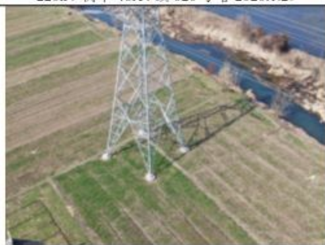
220kV 衡牵 46X4 线 022 号塔 2020.1.29
