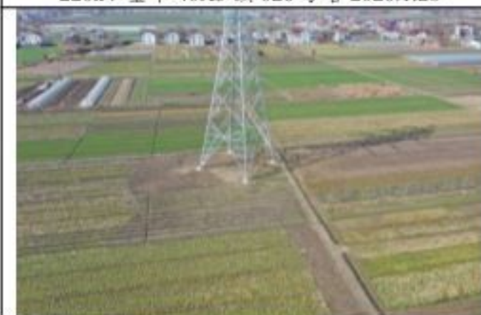
220kV 金牵 46X3 线 028 号塔 2020.1.28
