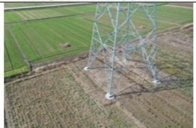
220kV 金牵 46X3 线 063 号塔 2020.1.28
