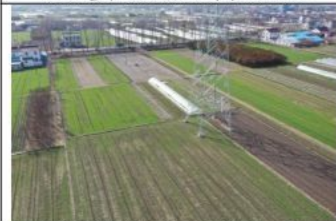
220kV 金牵 46X3 线 014 号塔 2020.1.28
