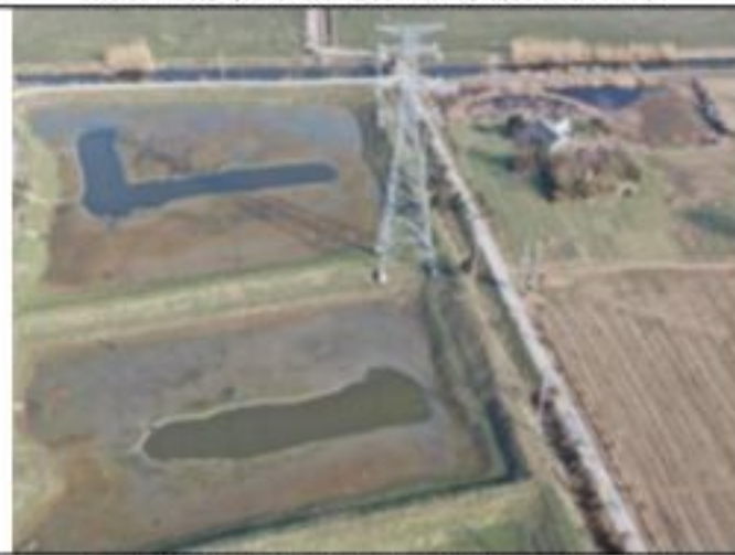
220kV 衡牵 46X4 线 063 号塔 2020.1.29
