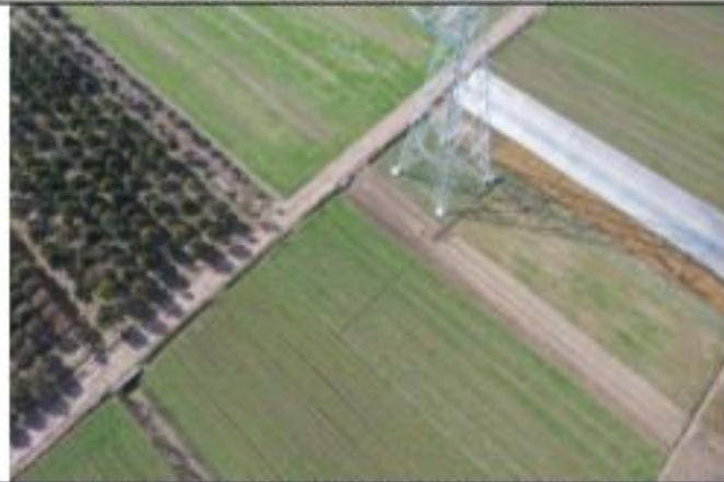
220kV 金牵 46X3 线 018 号塔 2020.1.28
