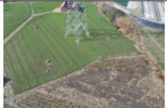
220kV 金牵 46X3 线 019 号塔 2020.1.28
