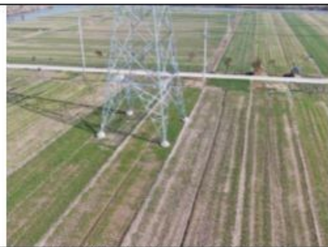
220kV 衡牵 46X4 线 017 号塔 2020.1.29
