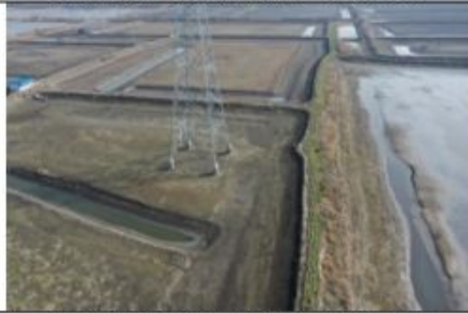
220kV 衡牵 46X4 线 003 号塔 2020.1.29
