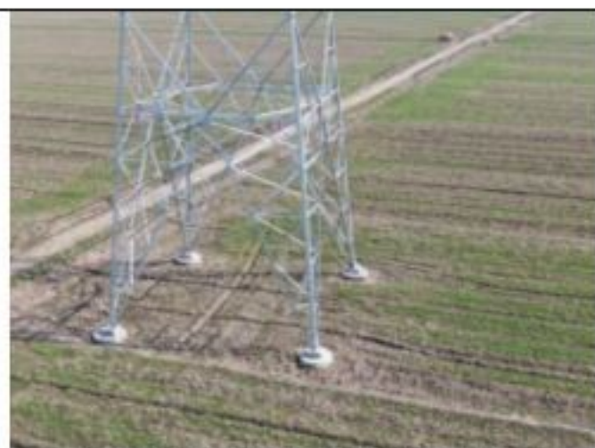
220kV 衡牵 46X4 线 026 号塔 2020.1.29
