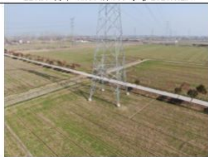
220kV 衡牵 46X4 线 019 号塔 2020.1.29
