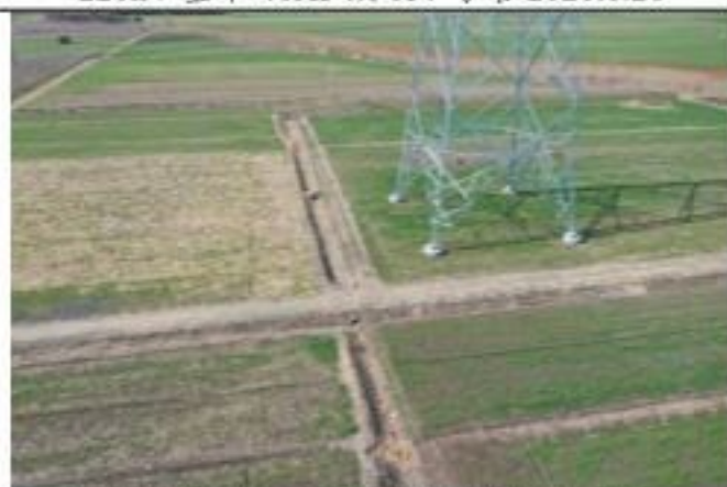
220kV 金牵 46X3 线 039 号塔 2020.1.28
