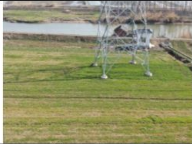
220kV 衡牵 46X4 线 011 号塔 2020.1.29
