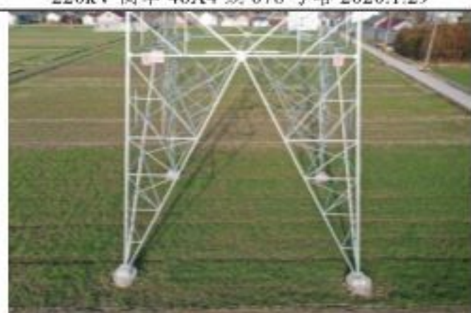
220kV 衡牵 46X4 线 080 号塔 2020.1.29
