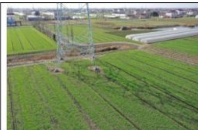
220kV 金牵 46X3 线 024 号塔 2020.1.28
