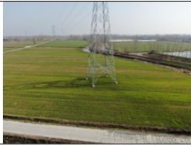
220kV 衡牵 46X4 线 009 号塔 2020.1.29
