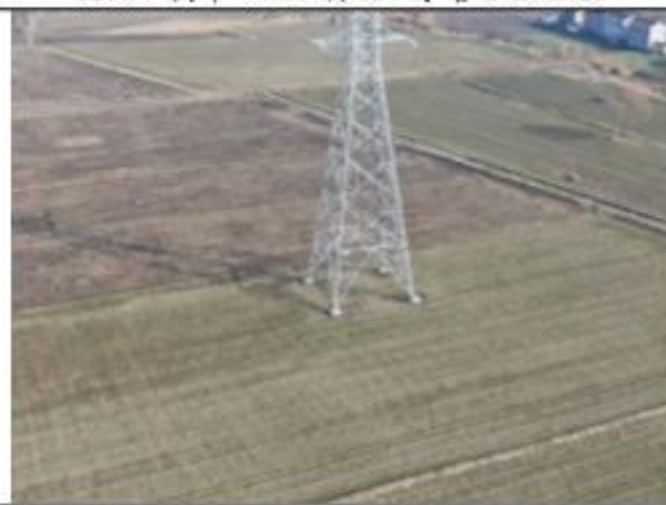
220kV 衡牵 46X4 线 061 号塔 2020.1.29
