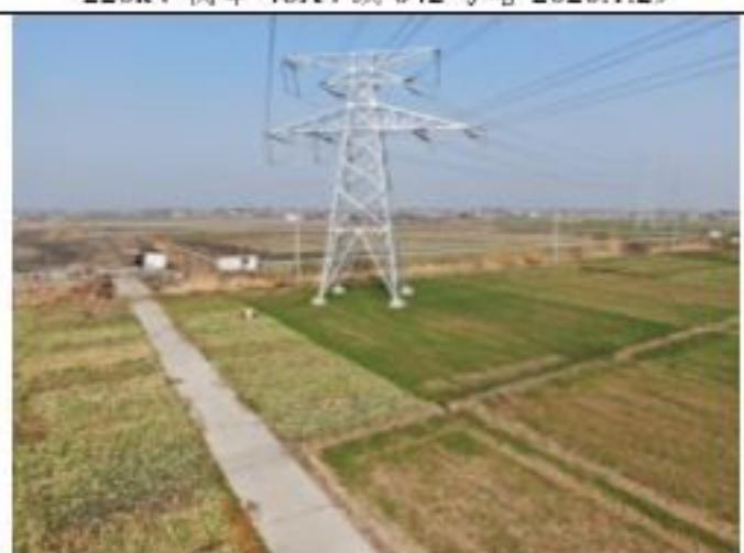
220kV 衡牵 46X4 线 044 号塔 2020.1.29
