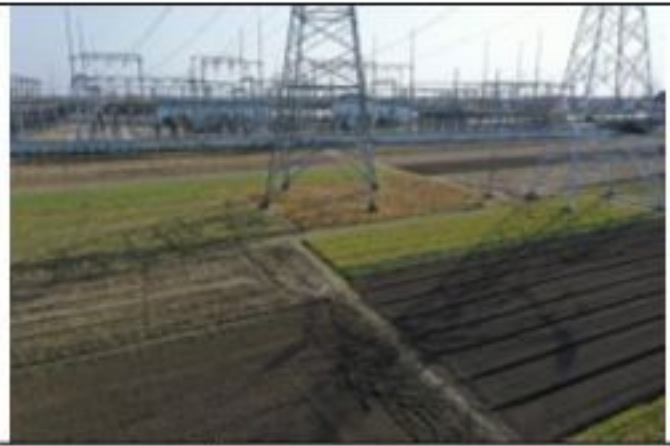
220kV 金牵 46X3 线 001 号塔 2020.1.28
