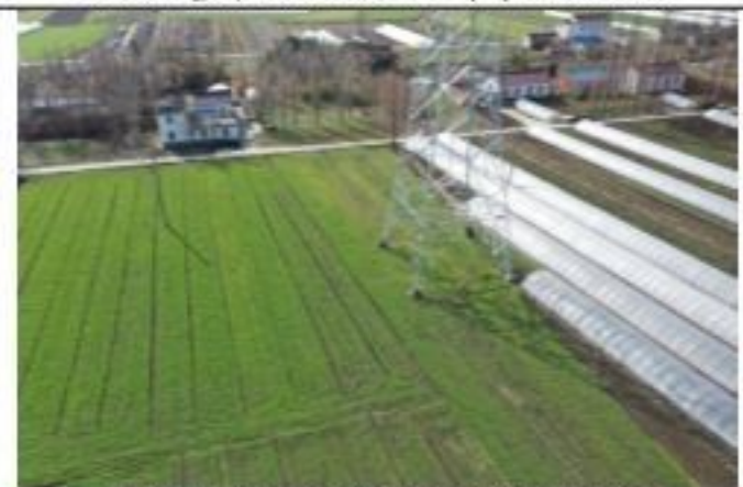
220kV 金牵 46X3 线 015 号塔 2020.1.28
