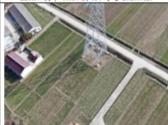
220kV 衡牵 46X4 线 039 号塔 2020.1.29
