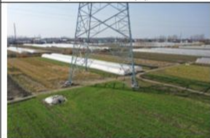
220kV 金牵 46X3 线 012 号塔 2020.1.28
