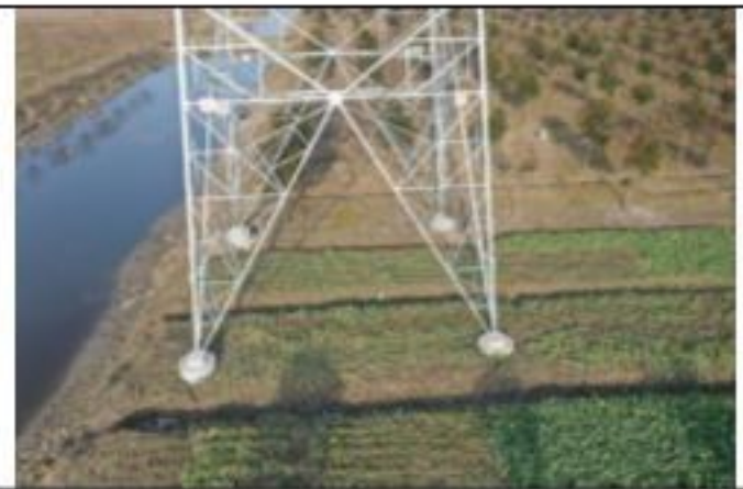
220kV 衡牵 46X4 线 082 号塔 2020.1.29
