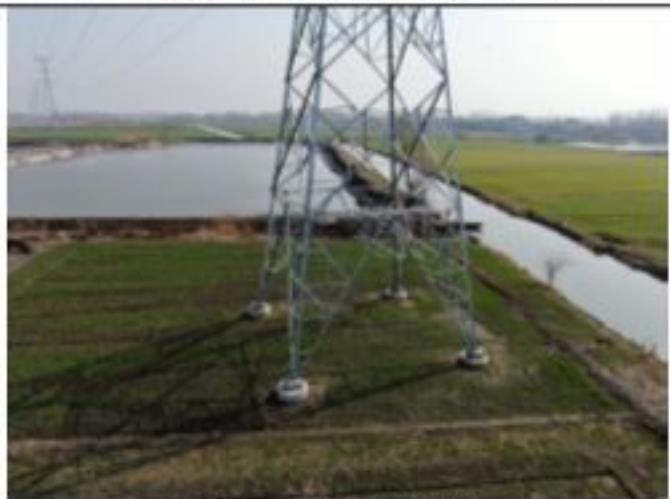
220kV 衡牵 46X4 线 006 号塔 2020.1.29
