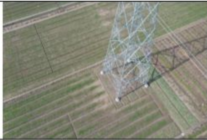
220kV 金牵 46X3 线 048 号塔 2020.1.28
