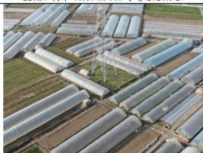
220kV 衡牵 46X4 线 070 号塔 2020.1.29
