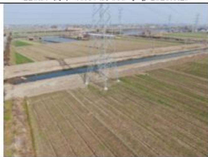
220kV 衡牵 46X4 线 020 号塔 2020.1.29
