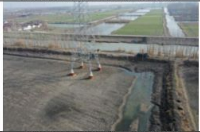
220kV 衡牵 46X4 线 004 号塔 2020.1.29
