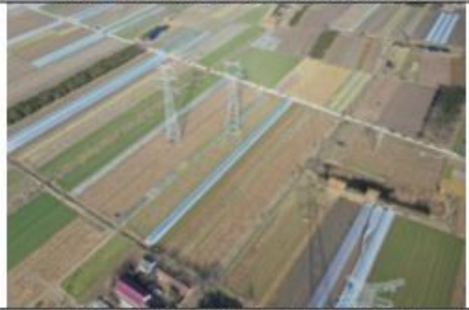
220kV 金牵 46X3 线 003 号塔 2020.1.28
