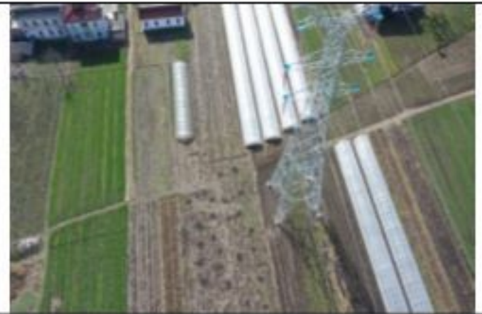
220kV 金牵 46X3 线 017 号塔 2020.1.28
