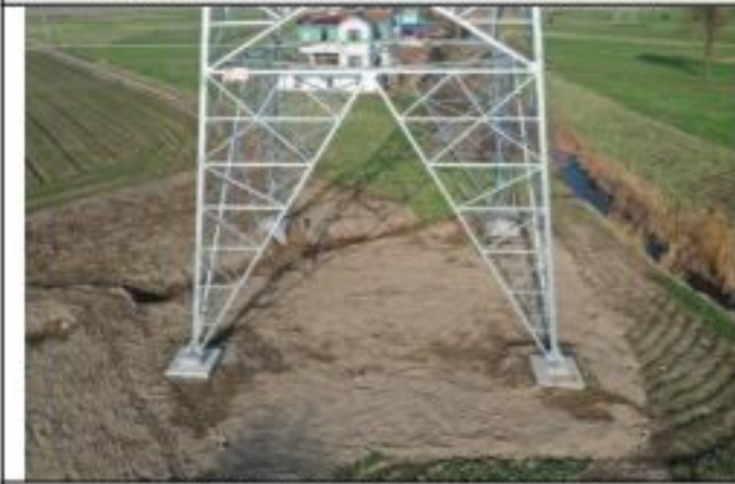
220kV 衡牵 46X4 线 087 号塔 2020.1.29
