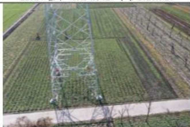
220kV 金牵 46X3 线 031 号塔 2020.1.28
