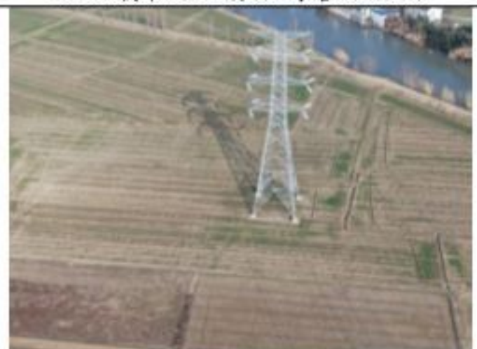
220kV 衡牵 46X4 线 056 号塔 2020.1.29
