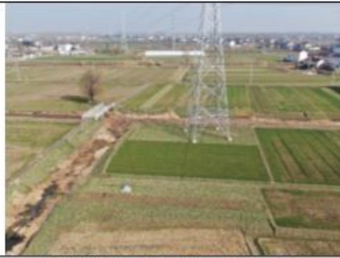
220kV 衡牵 46X4 线 049 号塔 2020.1.29
