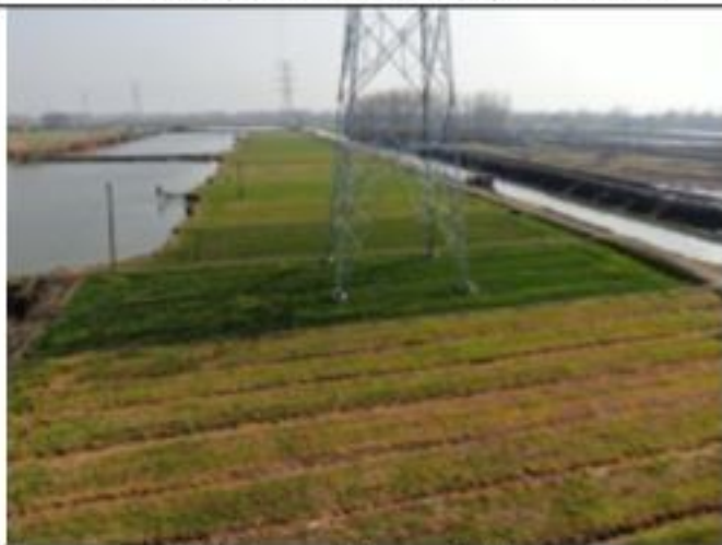
220kV 衡牵 46X4 线 005 号塔 2020.1.29
