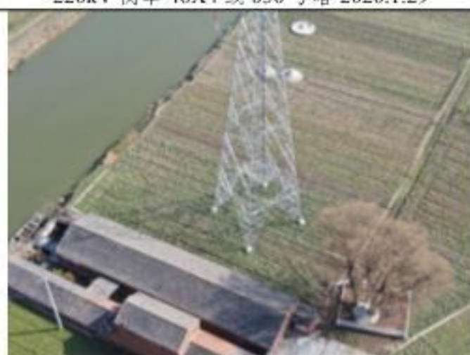
220kV 衡牵 46X4 线 032 号塔 2020.1.29
