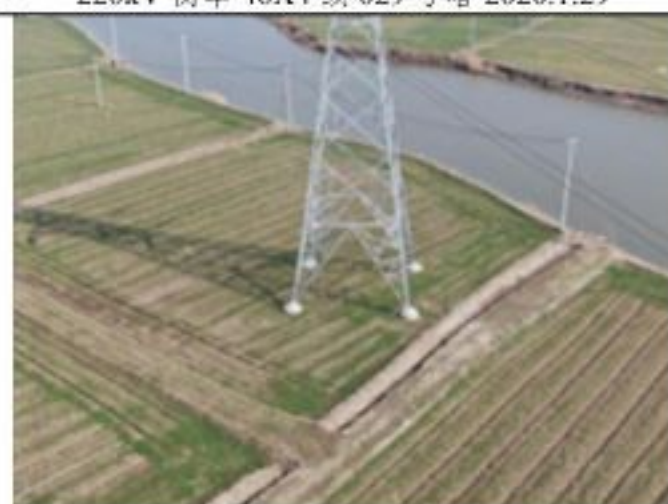
220kV 衡牵 46X4 线 031 号塔 2020.1.29
