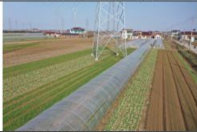
220kV 金牵 46X3 线 002 号塔 2020.1.28
