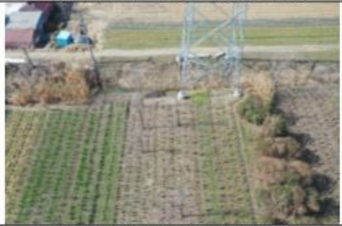
220kV 金牵 46X3 线 043 号塔 2020.1.28
