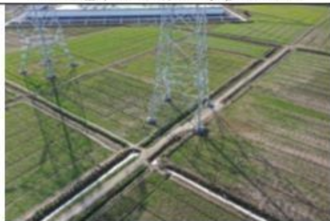
220kV 金牵 46X3 线 069 号塔 2020.1.28
