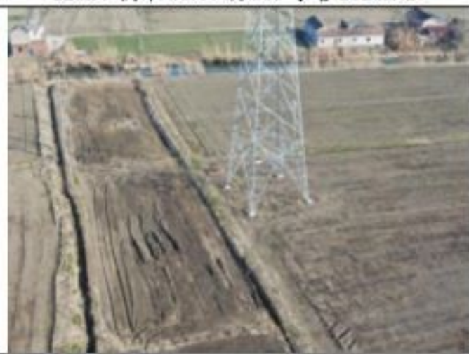
220kV 衡牵 46X4 线 062 号塔 2020.1.29
