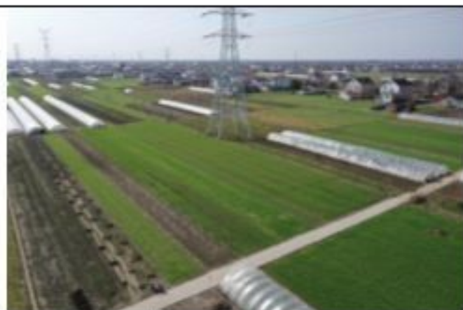
220kV 金牵 46X3 线 025 号塔 2020.1.28
