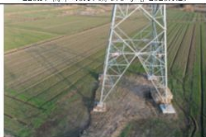
220kV 衡牵 46X4 线 078 号塔 2020.1.29
