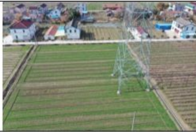
220kV 金牵 46X3 线 056 号塔 2020.1.28
