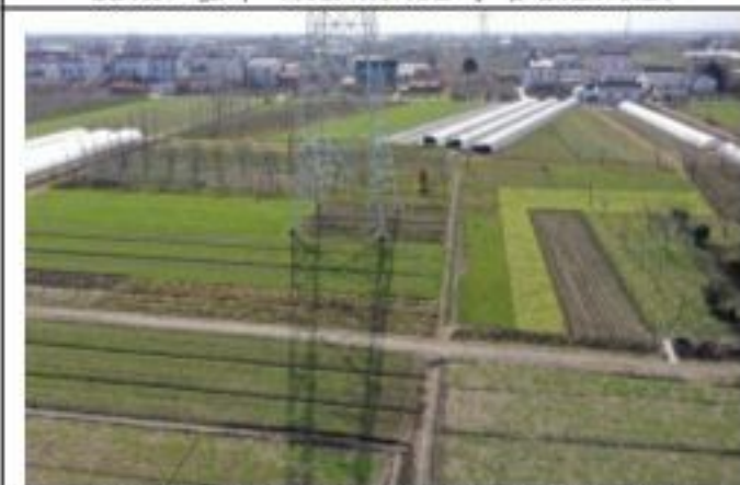
220kV 金牵 46X3 线 034 号塔 2020.1.28
