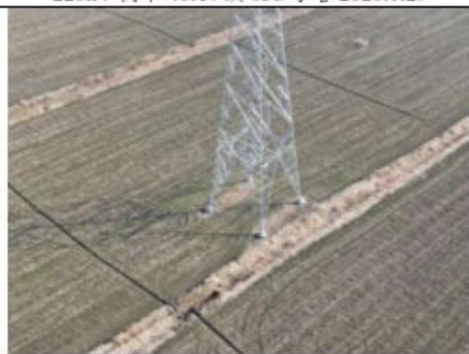
220kV 衡牵 46X4 线 060 号塔 2020.1.29
