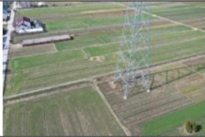
220kV 金牵 46X3 线 042 号塔 2020.1.28
