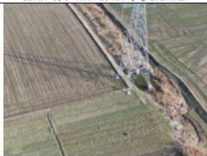
220kV 衡牵 46X4 线 059 号塔 2020.1.29
