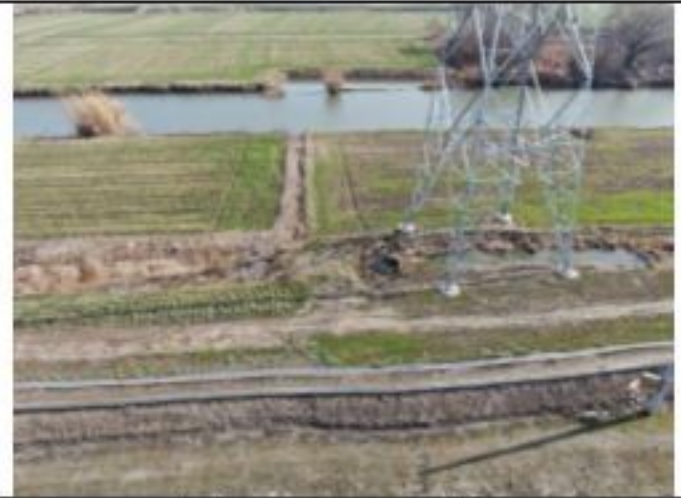
220kV 衡牵 46X4 线 012 号塔 2020.1.29
