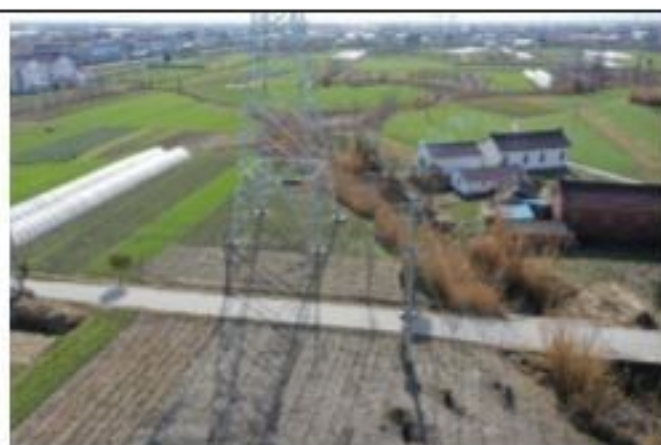
220kV 金牵 46X3 线 033 号塔 2020.1.28
