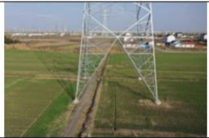
220kV 衡牵 46X4 线 086 号塔 2020.1.29
