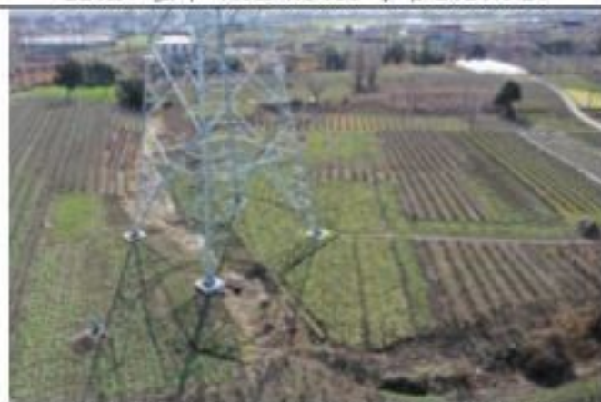
220kV 金牵 46X3 线 035 号塔 2020.1.28
