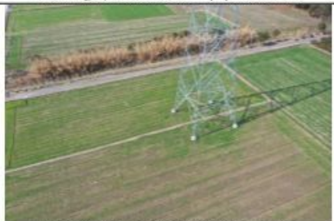
220kV 金牵 46X3 线 047 号塔 2020.1.28
