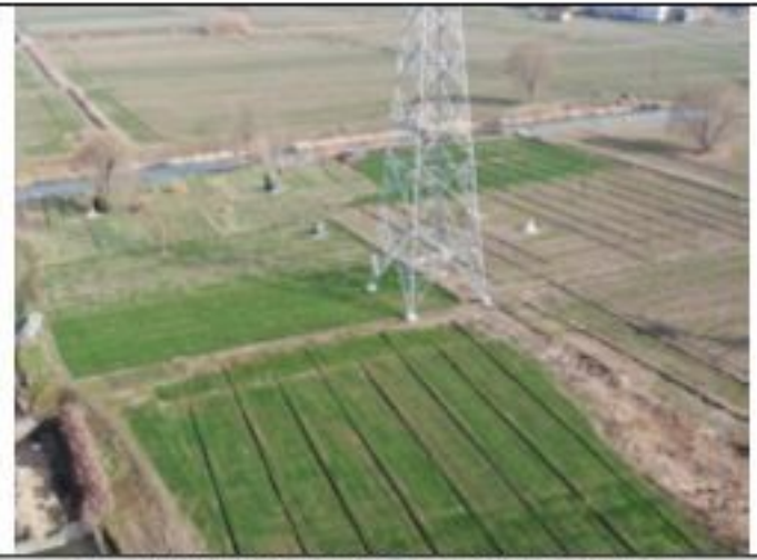
220kV 衡牵 46X4 线 050 号塔 2020.1.29
