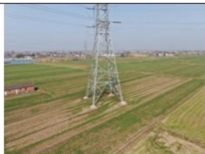
220kV 衡牵 46X4 线 025 号塔 2020.1.29
