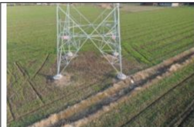
220kV 衡牵 46X4 线 073 号塔 2020.1.29
