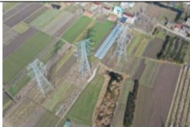
220kV 金牵 46X3 线 004 号塔 2020.1.28
