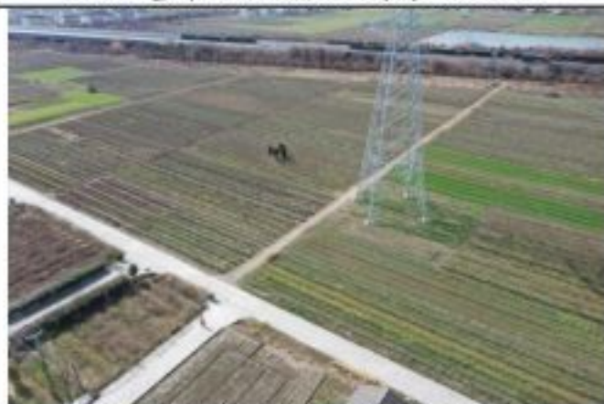
220kV 金牵 46X3 线 054 号塔 2020.1.28
