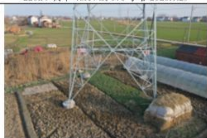
220kV 衡牵 46X4 线 072 号塔 2020.1.29
