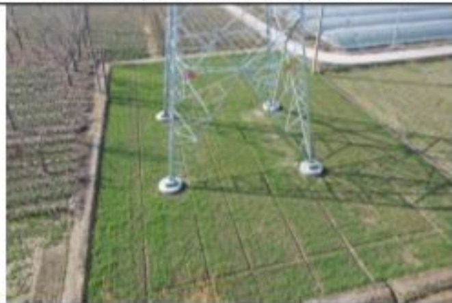
220kV 金牵 46X3 线 060 号塔 2020.1.28
