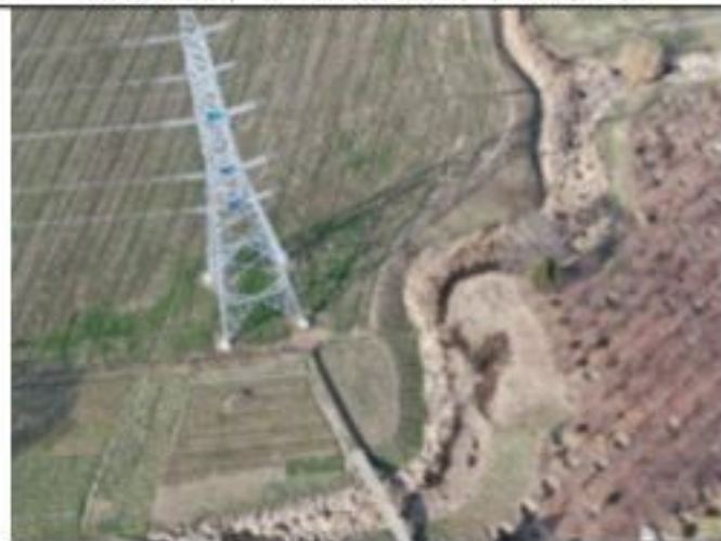
220kV 衡牵 46X4 线 053 号塔 2020.1.29
