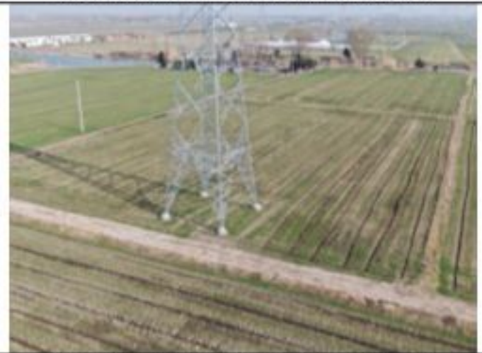
220kV 衡牵 46X4 线 016 号塔 2020.1.29
