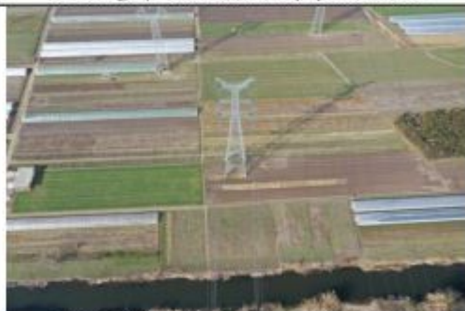
220kV 金牵 46X3 线 006 号塔 2020.1.28
