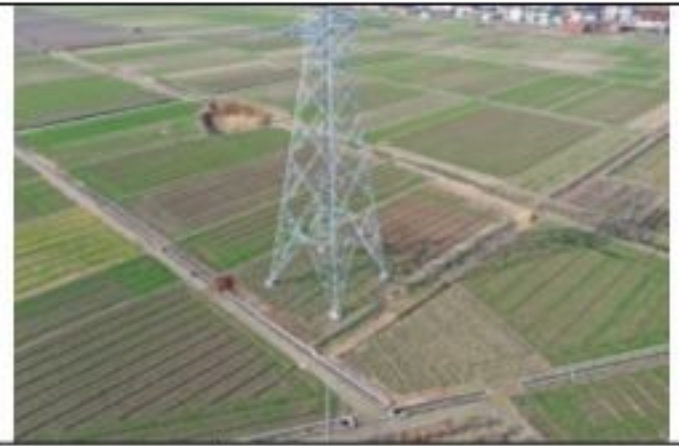
220kV 金牵 46X3 线 057 号塔 2020.1.28
