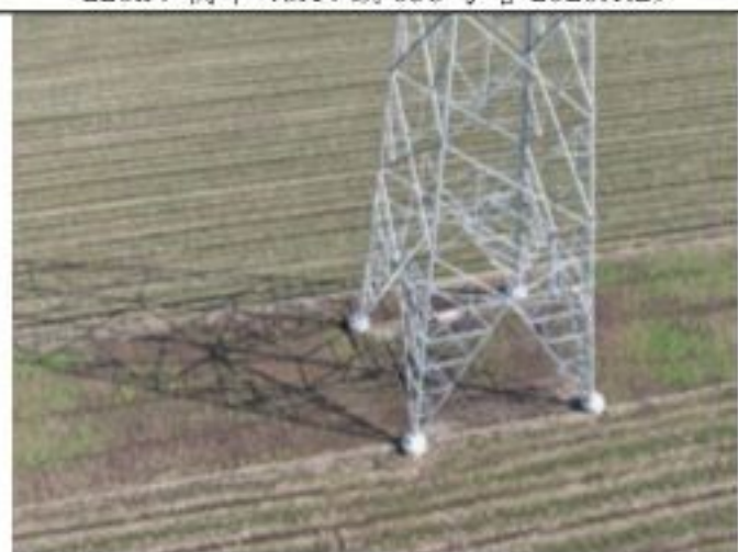
220kV 衡牵 46X4 线 040 号塔 2020.1.29
