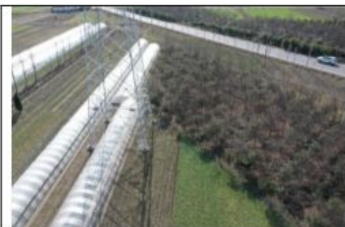
220kV 金牵 46X3 线 032 号塔 2020.1.28
