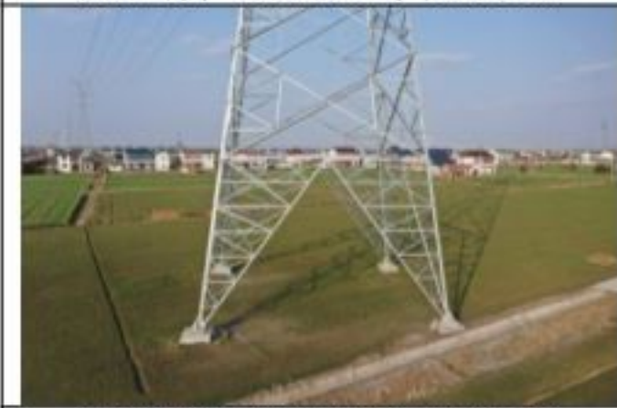
220kV 衡牵 46X4 线 083 号塔 2020.1.29
