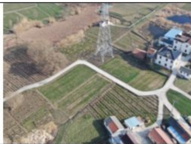
220kV 衡牵 46X4 线 058 号塔 2020.1.29
