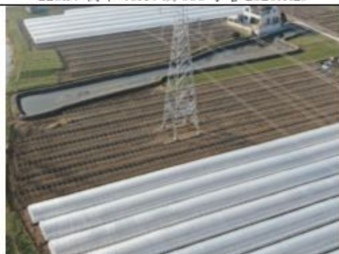
220kV 衡牵 46X4 线 068 号塔 2020.1.29
