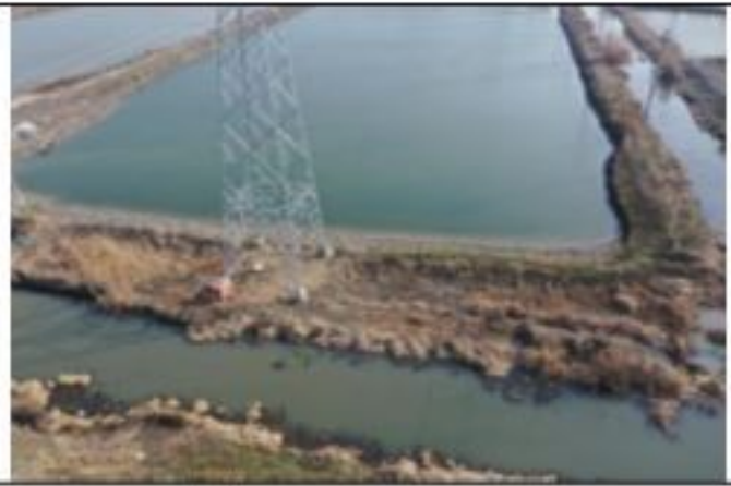
220kV 衡牵 46X4 线 002 号塔 2020.1.29
