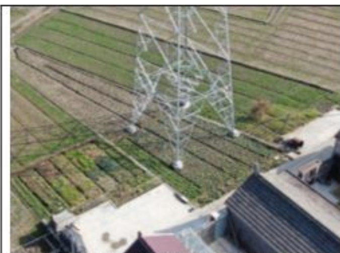
220kV 衡牵 46X4 线 041 号塔 2020.1.29
