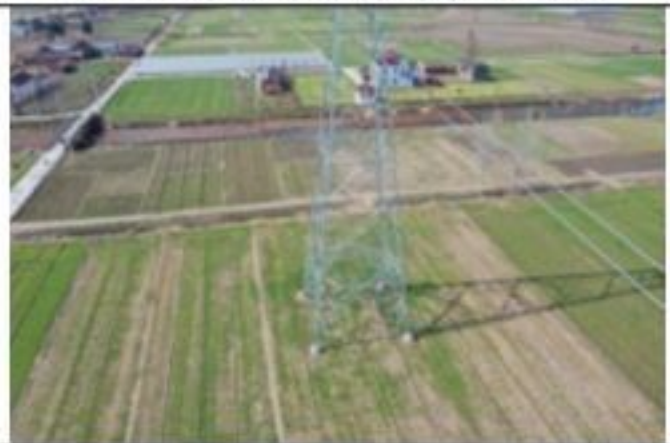
220kV 金牵 46X3 线 045 号塔 2020.1.28
