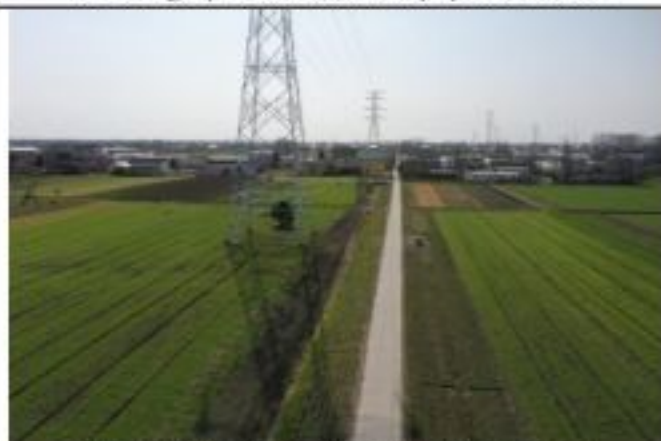
220kV 金牵 46X3 线 022 号塔 2020.1.28
