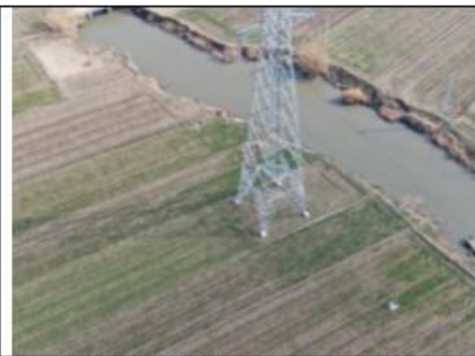
220kV 衡牵 46X4 线 033 号塔 2020.1.29
