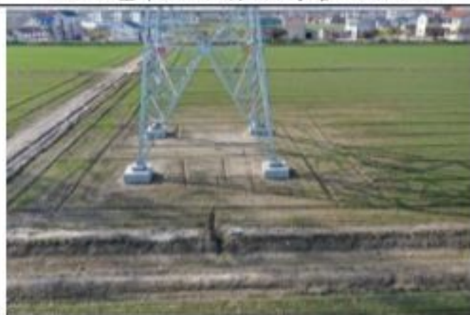
220kV 金牵 46X3 线 068 号塔 2020.1.28
