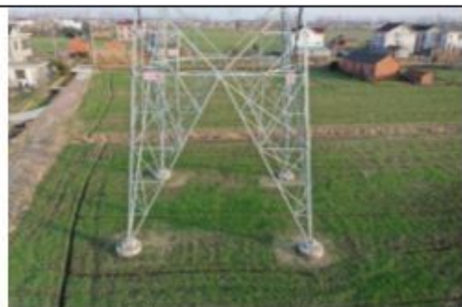
220kV 衡牵 46X4 线 074 号塔 2020.1.29
