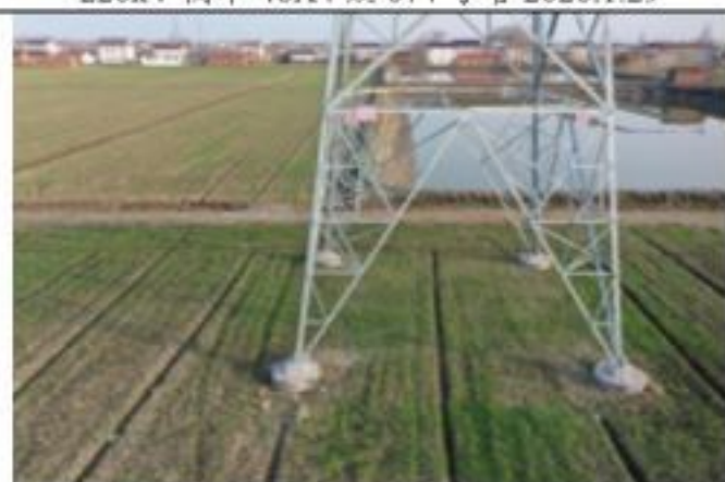
220kV 衡牵 46X4 线 076 号塔 2020.1.29
