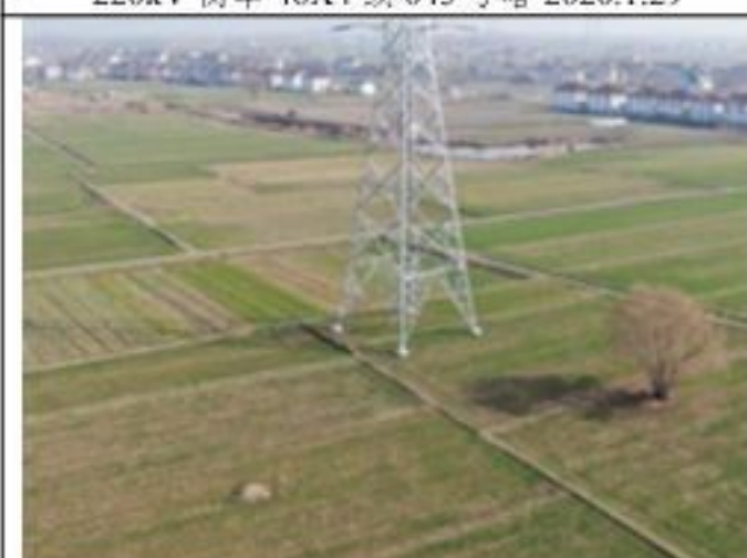
220kV 衡牵 46X4 线 047 号塔 2020.1.29
