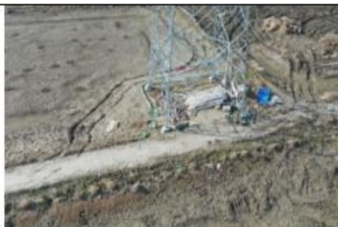
220kV 金牵 46X3 线 064 号塔 2020.1.28
