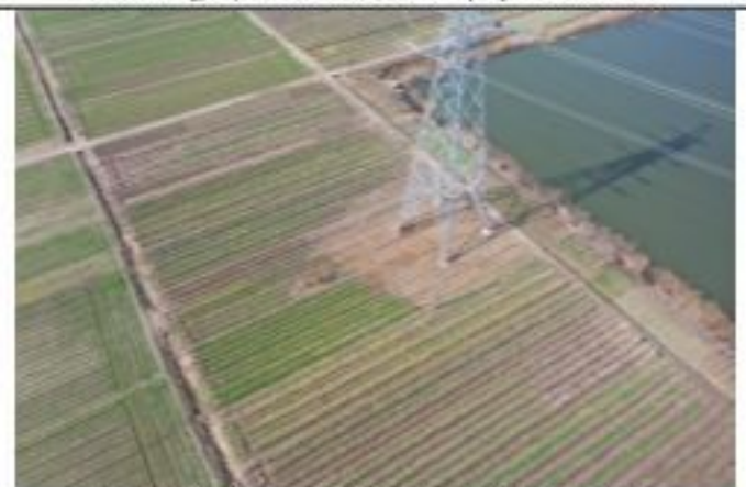
220kV 金牵 46X3 线 055 号塔 2020.1.28
