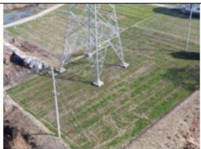
220kV 衡牵 46X4 线 042 号塔 2020.1.29
