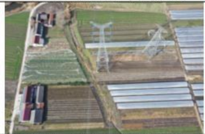
220kV 金牵 46X3 线 011 号塔 2020.1.28
