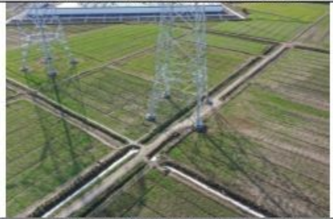
220kV 衡牵 46X4 线 092 号塔 2020.1.29
