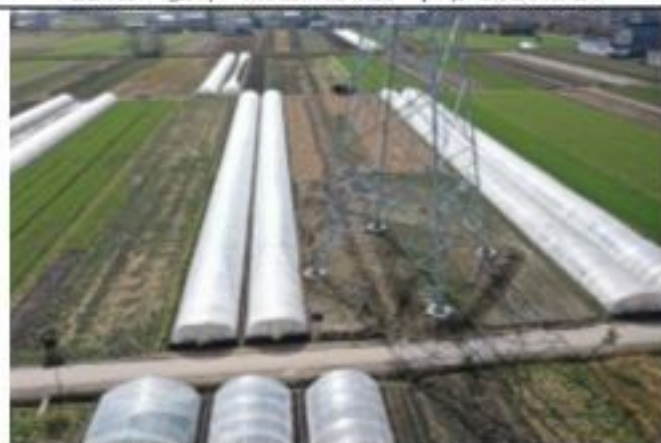
220kV 金牵 46X3 线 027 号塔 2020.1.28
