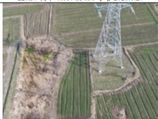
220kV 衡牵 46X4 线 038 号塔 2020.1.29
