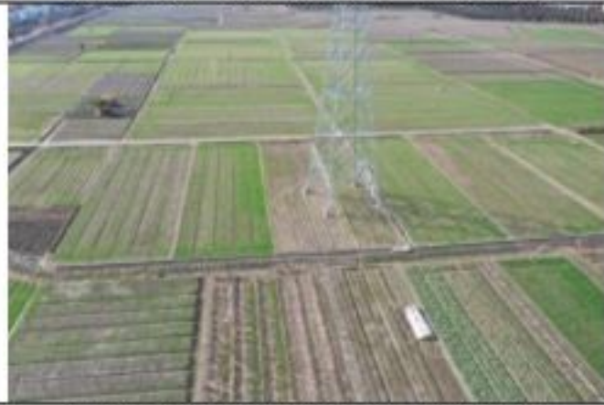
220kV 金牵 46X3 线 058 号塔 2020.1.28
