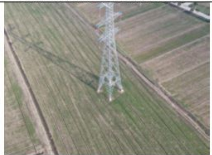
220kV 衡牵 46X4 线 054 号塔 2020.1.29
