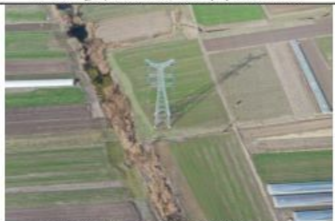
220kV 金牵 46X3 线 007 号塔 2020.1.28
