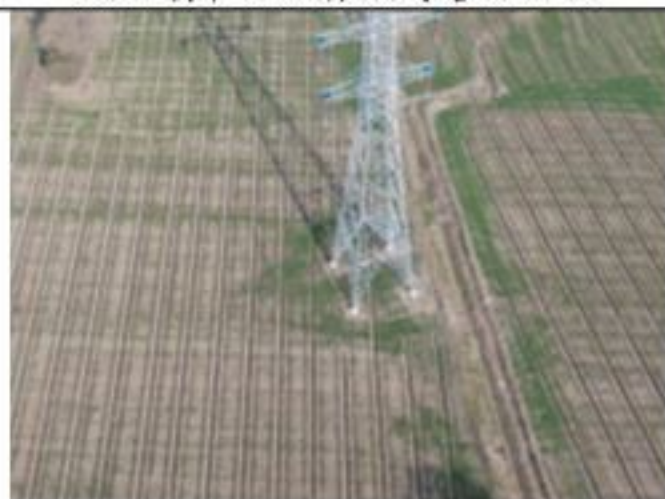
220kV 衡牵 46X4 线 055 号塔 2020.1.29
