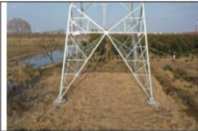
220kV 衡牵 46X4 线 081 号塔 2020.1.29
