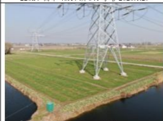
220kV 衡牵 46X4 线 043 号塔 2020.1.29
