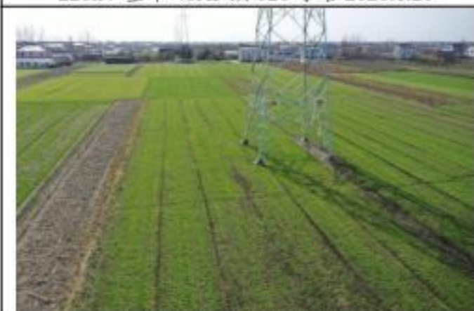
220kV 金牵 46X3 线 030 号塔 2020.1.28
