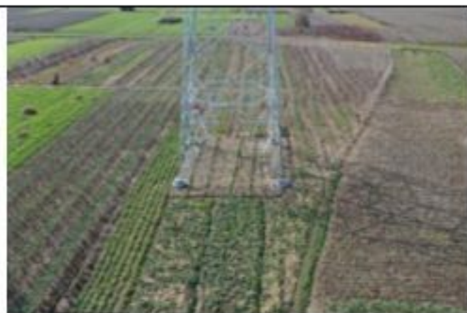
220kV 金牵 46X3 线 065 号塔 2020.1.28
