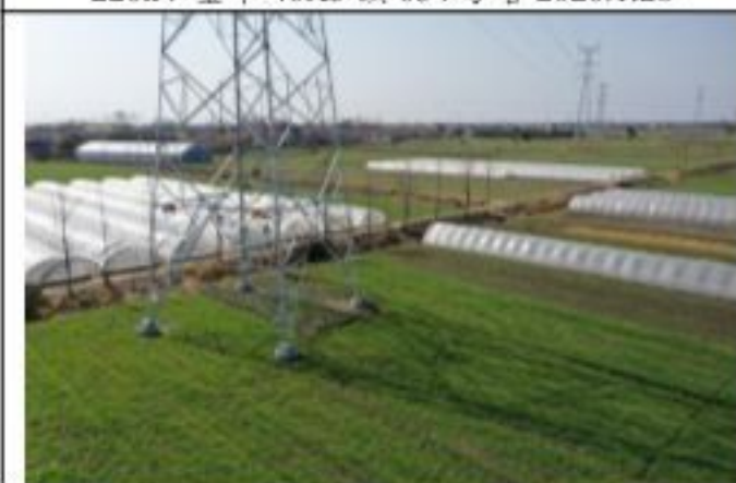
220kV 金牵 46X3 线 036 号塔 2020.1.28
