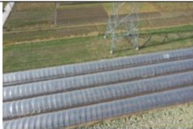
220kV 金牵 46X3 线 044 号塔 2020.1.28
