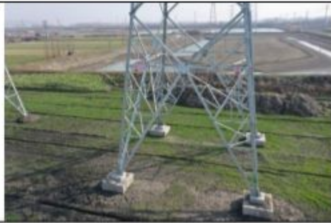
220kV 衡牵 46X4 线 001 号塔 2020.1.29
