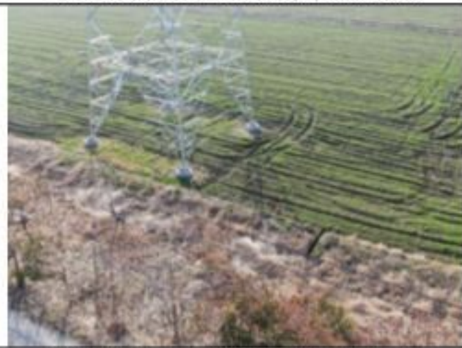
220kV 衡牵 46X4 线 064 号塔 2020.1.29
