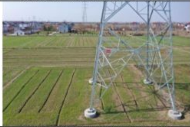
220kV 金牵 46X3 线 050 号塔 2020.1.28
