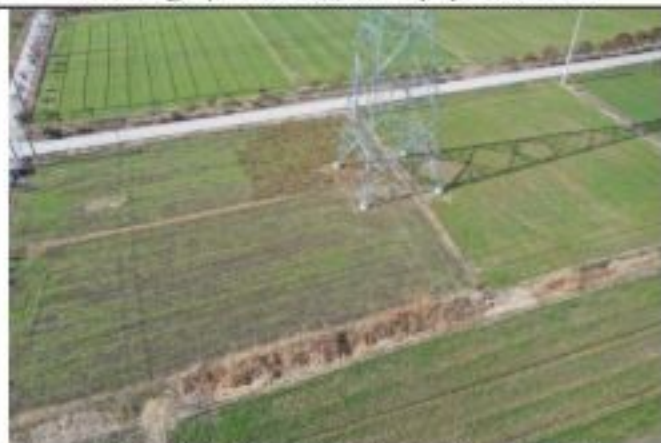
220kV 金牵 46X3 线 046 号塔 2020.1.28
