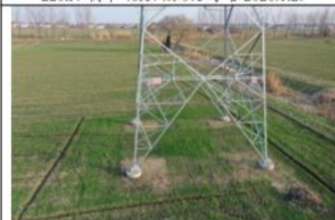
220kV 衡牵 46X4 线 075 号塔 2020.1.29
