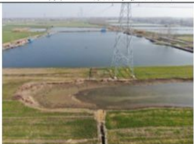
220kV 衡牵 46X4 线 008 号塔 2020.1.29
