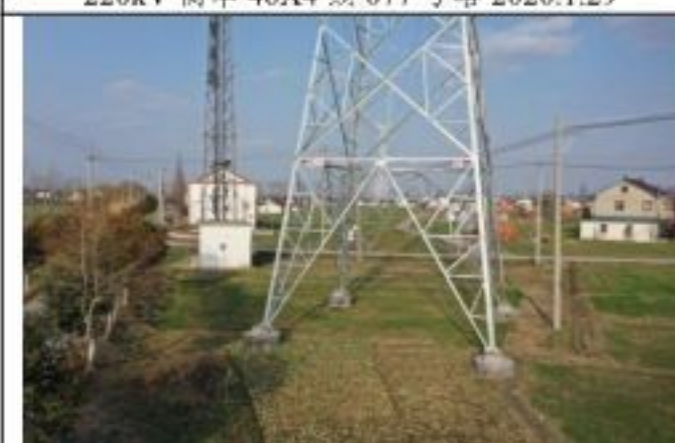
220kV 衡牵 46X4 线 079 号塔 2020.1.29
