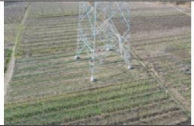
220kV 金牵 46X3 线 059 号塔 2020.1.28
