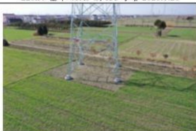
220kV 金牵 46X3 线 037 号塔 2020.1.28
