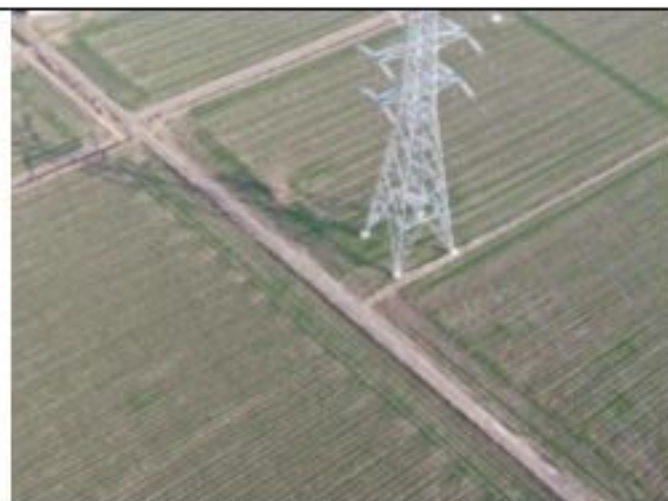
220kV 衡牵 46X4 线 066 号塔 2020.1.29
