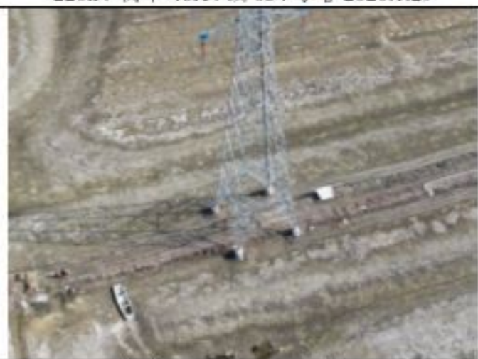
220kV 衡牵 46X4 线 036 号塔 2020.1.29
