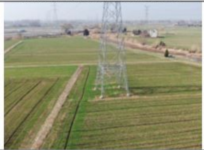
220kV 衡牵 46X4 线 014 号塔 2020.1.29
