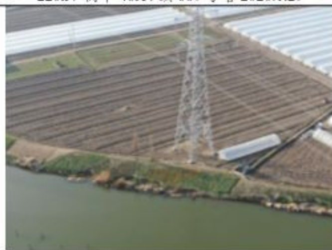
220kV 衡牵 46X4 线 069 号塔 2020.1.29
