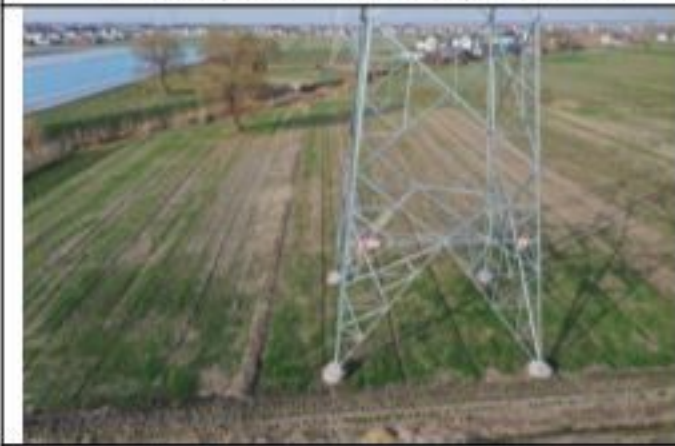
220kV 衡牵 46X4 线 085 号塔 2020.1.29
