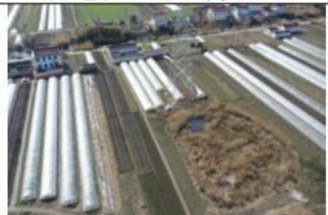
220kV 金牵 46X3 线 013 号塔 2020.1.28
