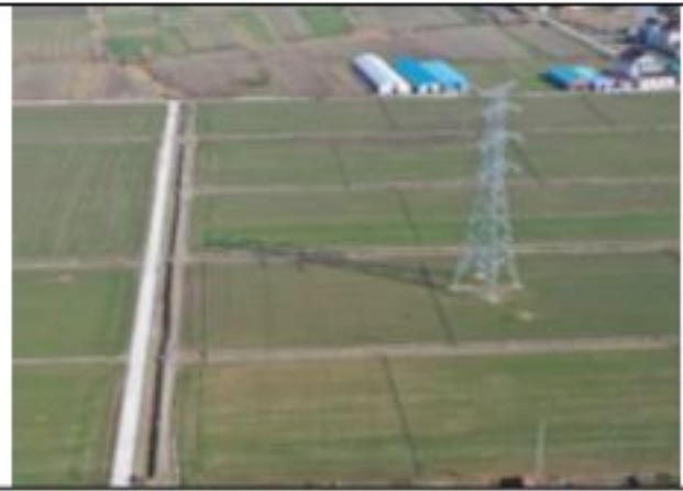
220kV 衡牵 46X4 线 090 号塔 2020.1.29
