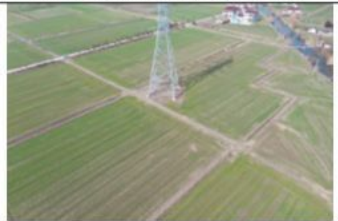
220kV 金牵 46X3 线 053 号塔 2020.1.28
