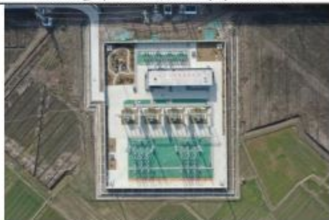
220kV 安丰牵引站 2020.1.28
