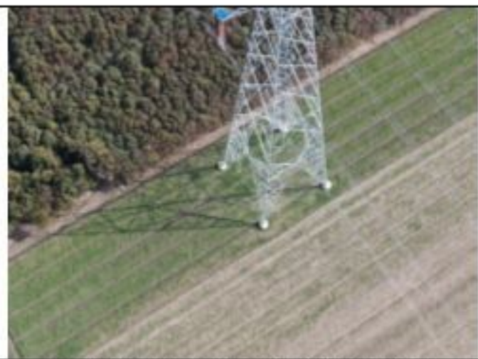
220kV 衡牵 46X4 线 034 号塔 2020.1.29
