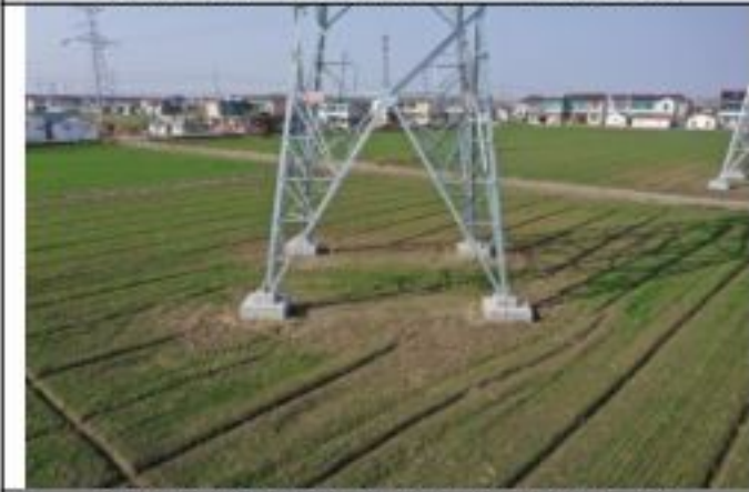
220kV 衡牵 46X4 线 091 号塔 2020.1.29
