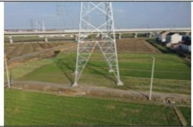
220kV 衡牵 46X4 线 088 号塔 2020.1.29
