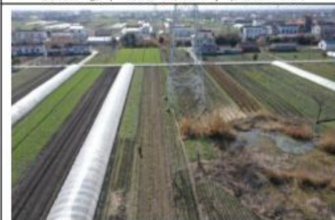
220kV 金牵 46X3 线 026 号塔 2020.1.28
