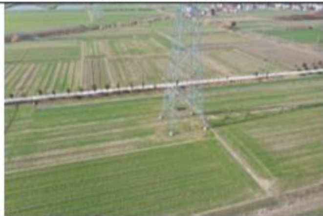
220kV 金牵 46X3 线 052 号塔 2020.1.28
