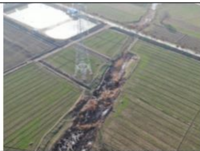
220kV 衡牵 46X4 线 057 号塔 2020.1.29
