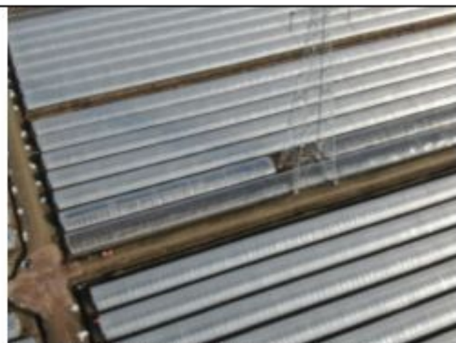
220kV 衡牵 46X4 线 065 号塔 2020.1.29
