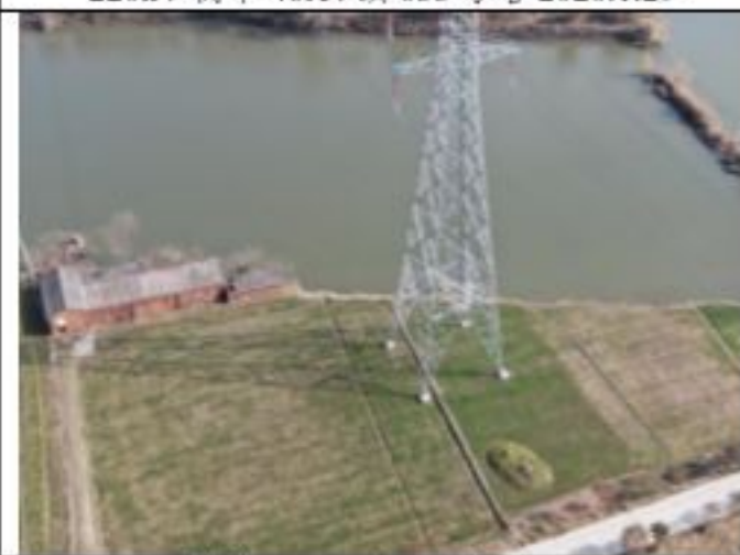
220kV 衡牵 46X4 线 035 号塔 2020.1.29
