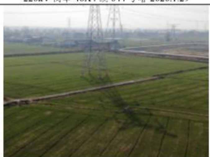
220kV 衡牵 46X4 线 046 号塔 2020.1.29
