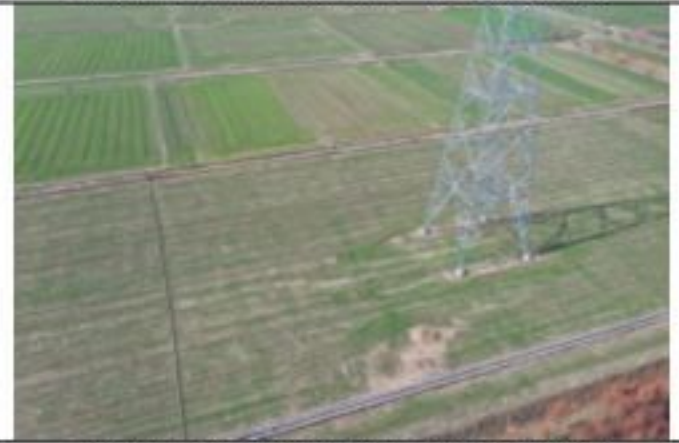
220kV 金牵 46X3 线 051 号塔 2020.1.28
