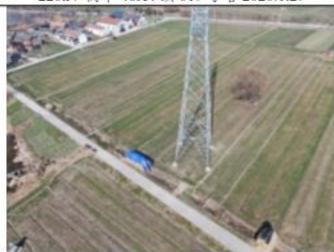
220kV 衡牵 46X4 线 021 号塔 2020.1.29
