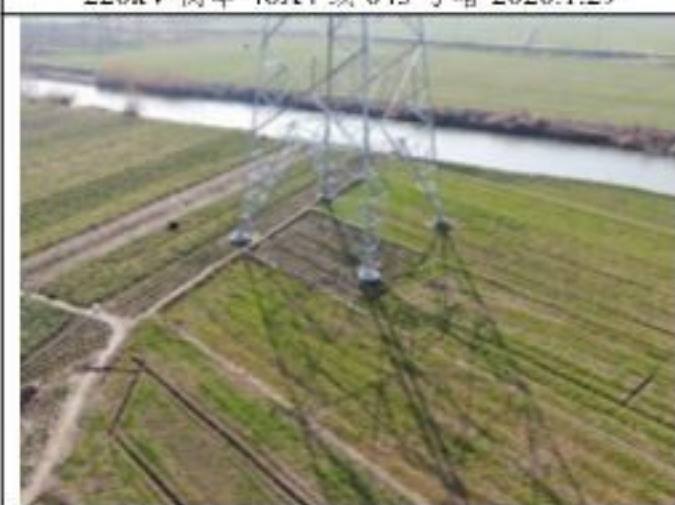
220kV 衡牵 46X4 线 045 号塔 2020.1.29
