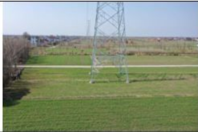
220kV 金牵 46X3 线 040 号塔 2020.1.28
