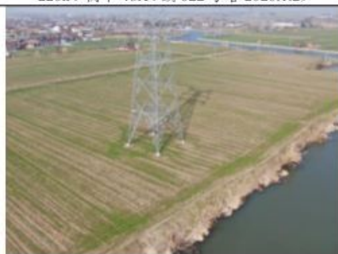
220kV 衡牵 46X4 线 024 号塔 2020.1.29
