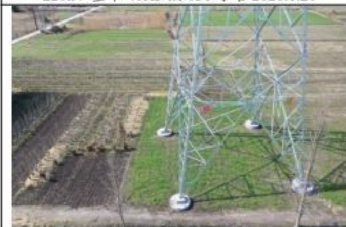
220kV 金牵 46X3 线 038 号塔 2020.1.28
