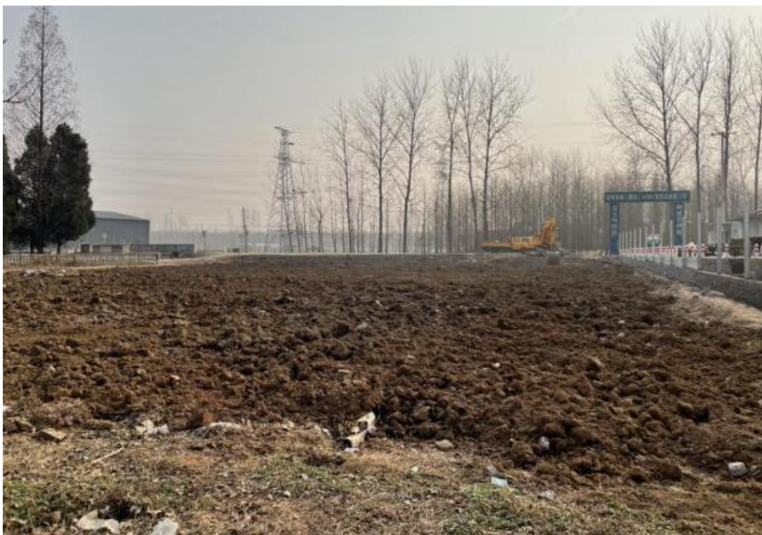
土地整治，变电站区（项目部），2020 年 12 月
