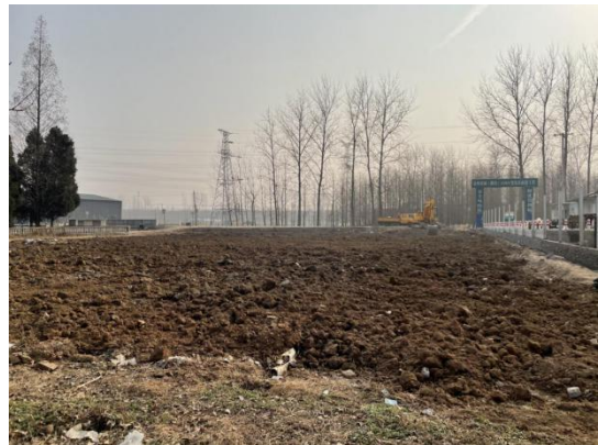
4-1 (c) 项目部拆除后土地整治
