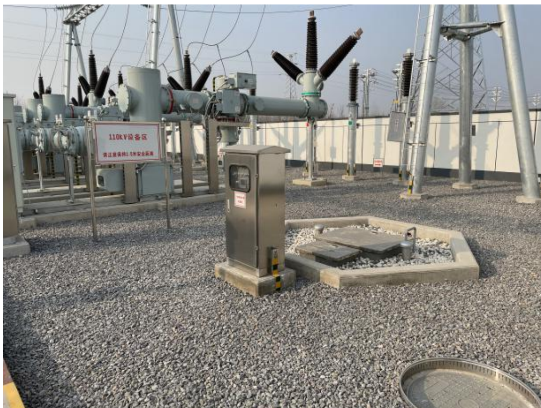
碎石铺垫，变电站区，2020 年 12 月
