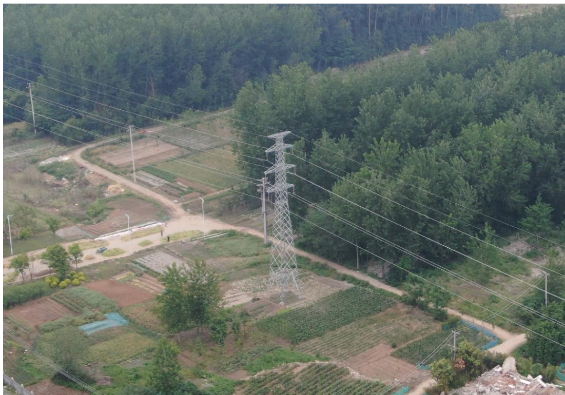
土地整治，塔基区 G7，2021 年 3 月
