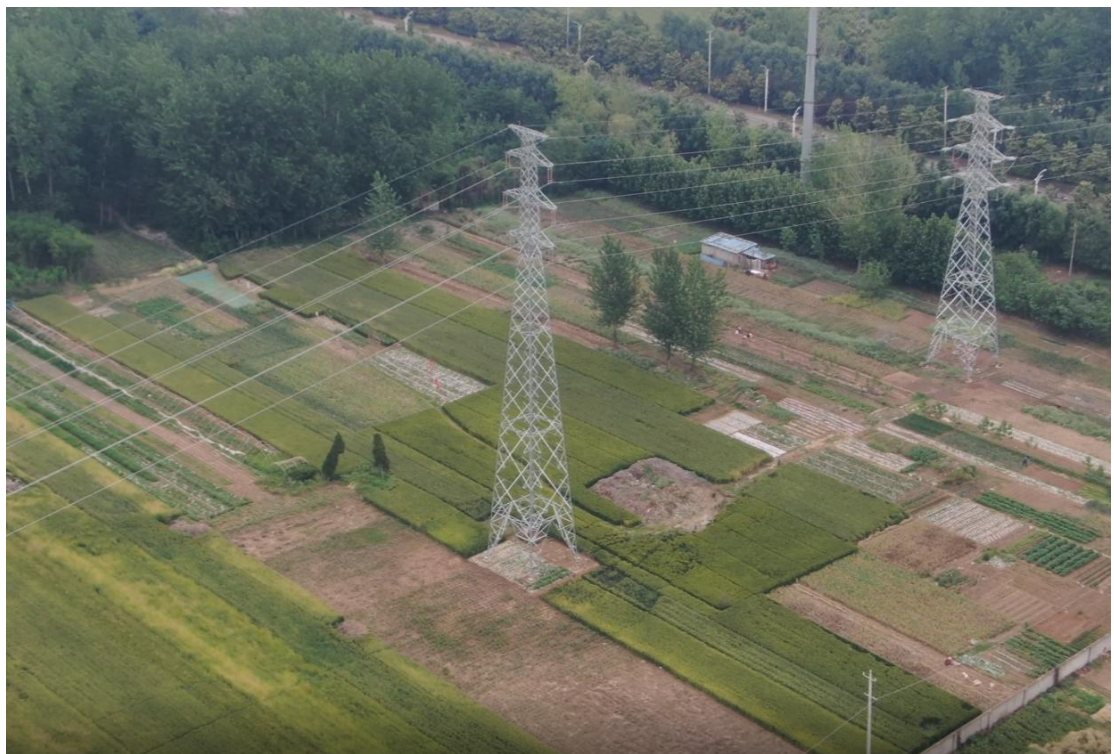
土地整治，塔基区 G6，2021 年 3 月
