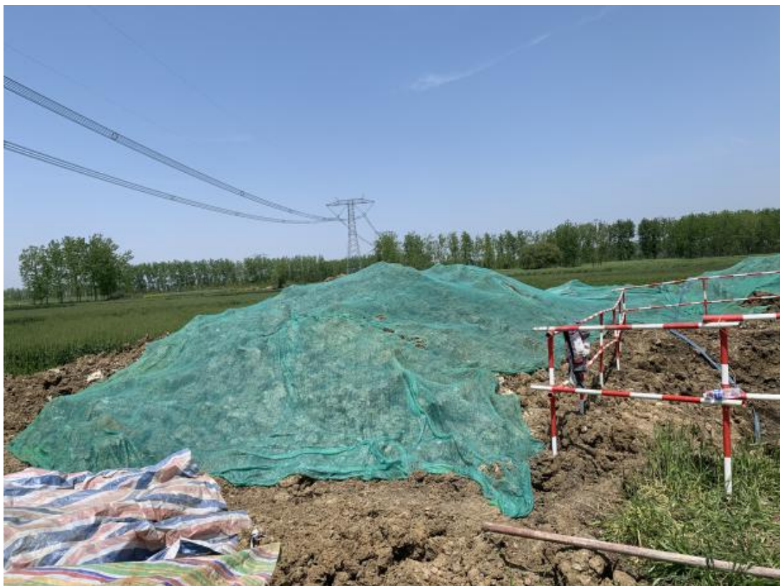
临时苫盖，塔基区，2020 年 7 月
