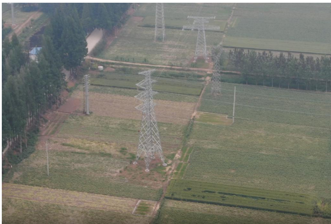
土地整治，塔基区 G15，2021 年 3 月
