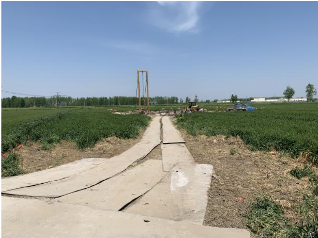
铺设钢板，临时施工道路区，2020 年 7 月
