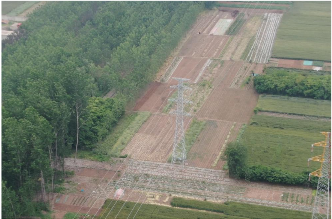
土地整治，塔基区 G4，2021 年 3 月
