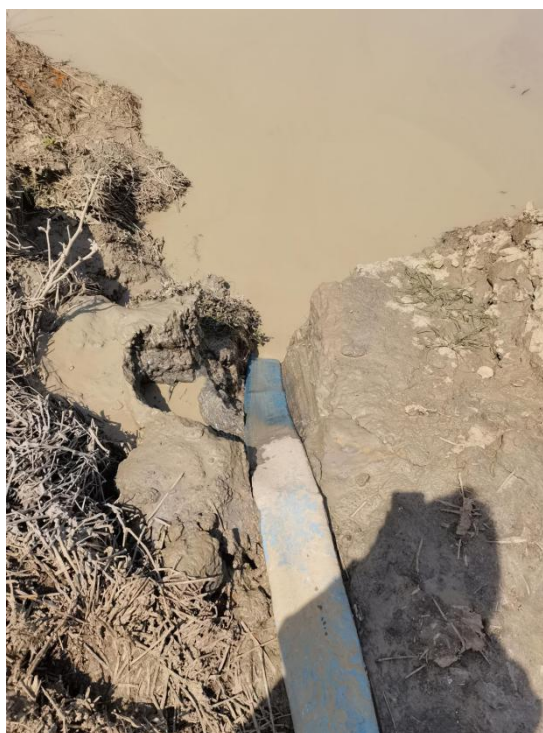
4-3 (a) 塔基区泥浆沉淀池
