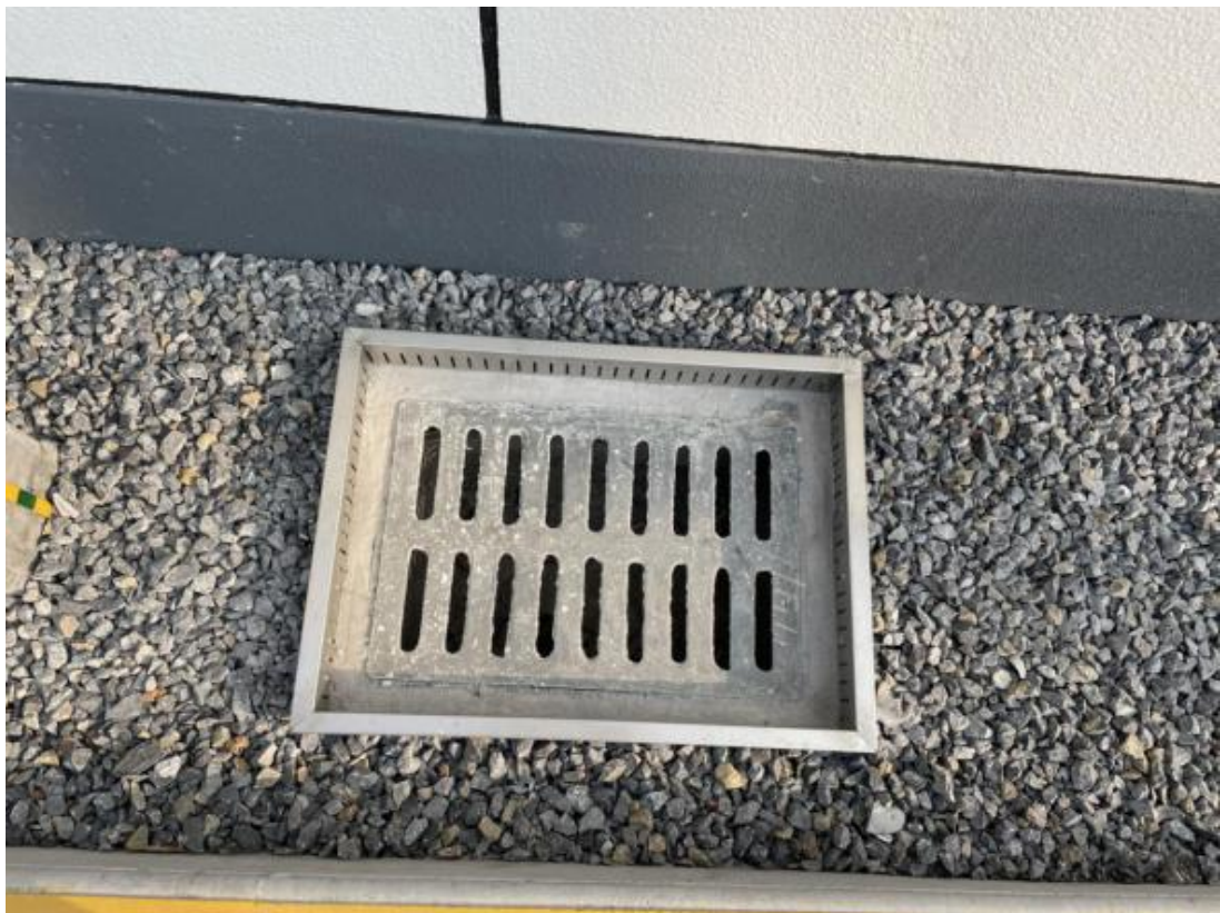
雨水口，变电站区，2020 年 12 月
