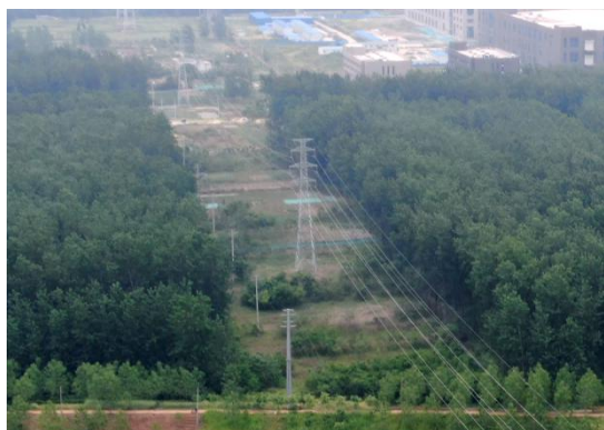
4-2 (a) 塔基区撒播草籽
