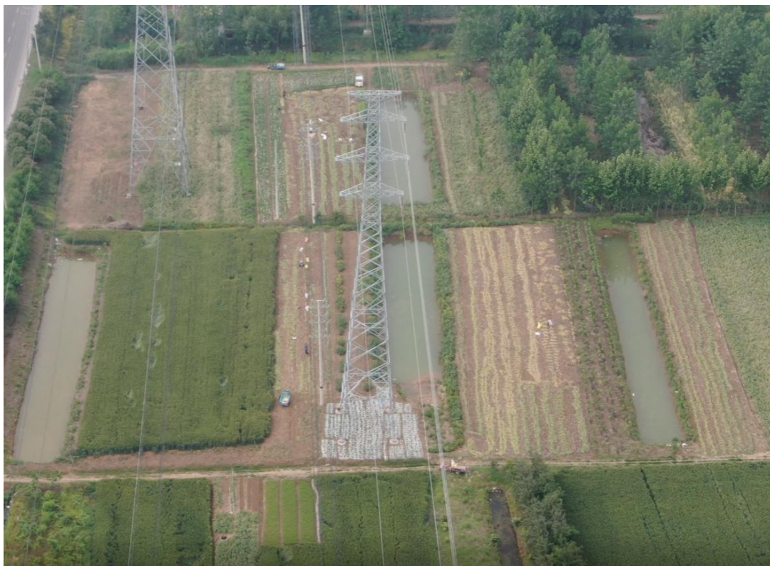
土地整治，塔基区 G24，2021 年 3 月
