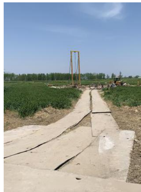
4-3 (b) 临时施工道路区铺设钢板
