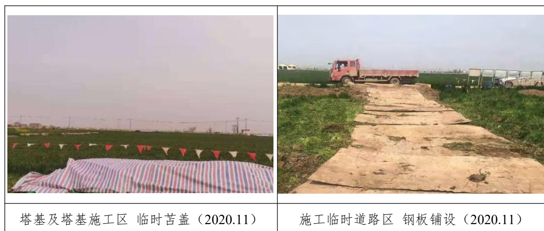
图 4-3 临时措施实施情况
