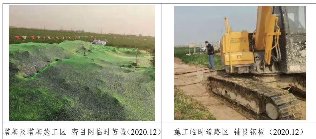
图 4-3 临时措施实施情况
