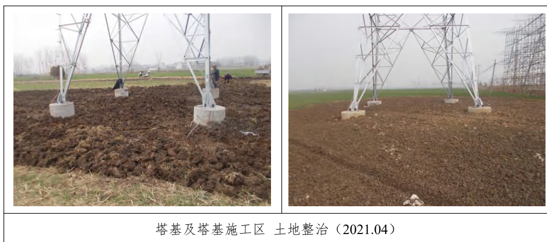
图 4-1 工程措施实施情况
