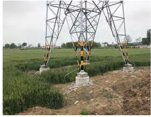
厉穆线 28 号 撒播草籽 (2021.05)
