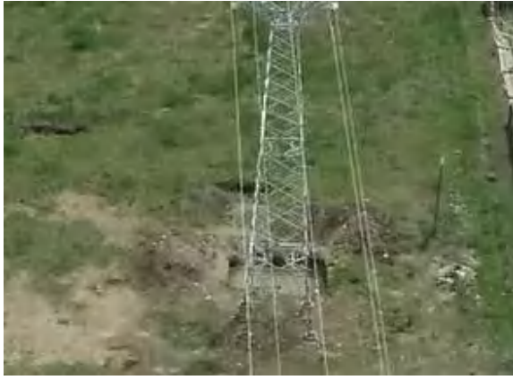
厉穆线 25 号 撒播草籽 (2021.05)
