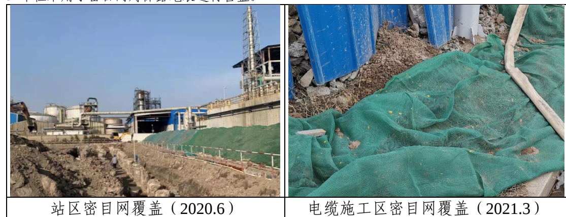
图 4-2 临时措施实施情况
