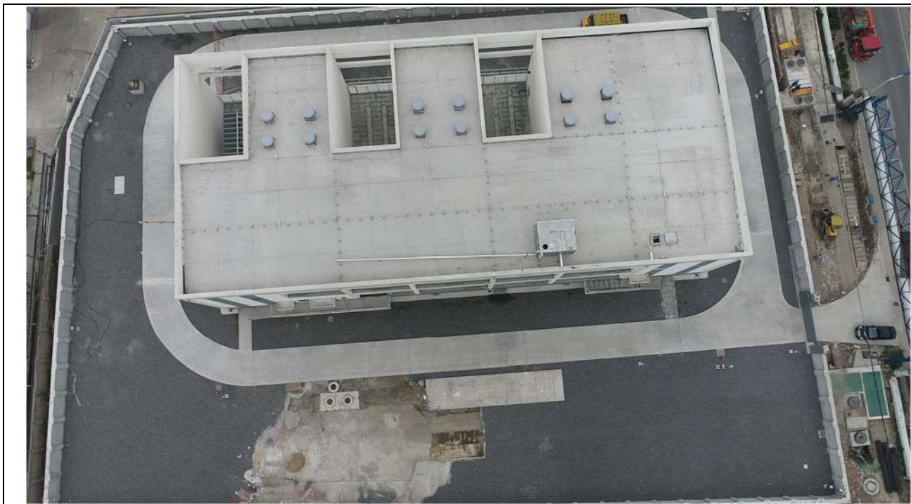
站区 碎石铺垫（2021.05）
