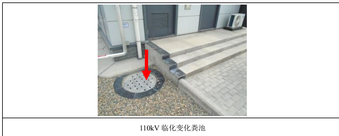
图 8-2 本工程 110kV 临化变化粪池照片
