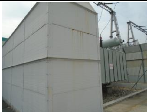
图6-1 变电站主变位置处的声屏障
