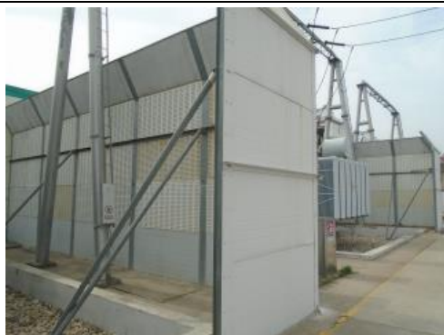
图6-1 变电站主变位置处的声屏障
