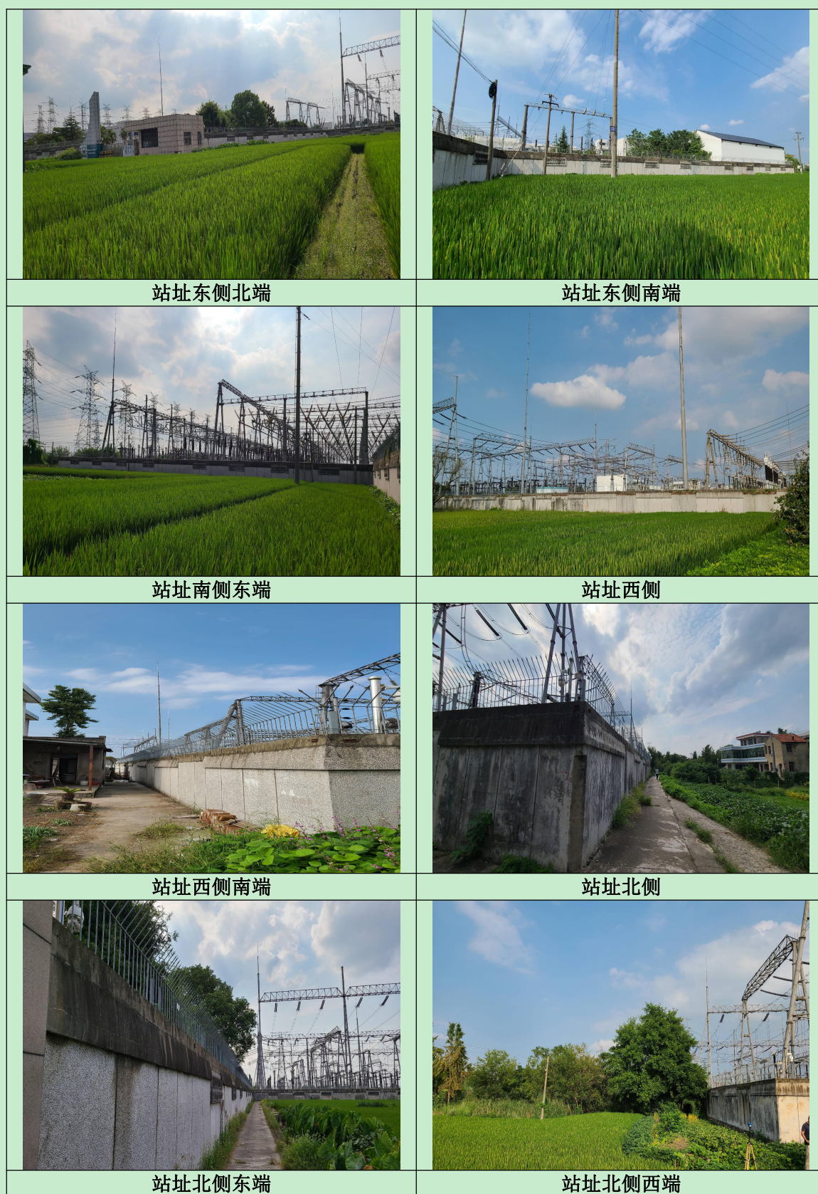
图 3.2 变电站周围情况
