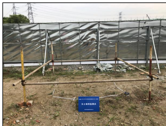
换流站进展道路区
