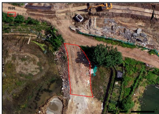
N8064 施工道路区扰动面积解译图-6月
