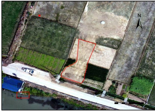
N19 施工道路区扰动面积解译图-4 月
