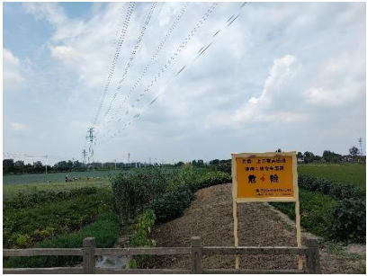
架空线路下方警示标示
