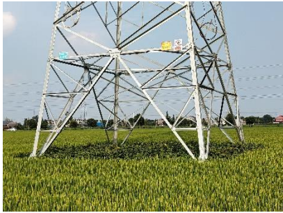
110kV 新蒋 948/新运 949 线#58 塔基恢复生态
