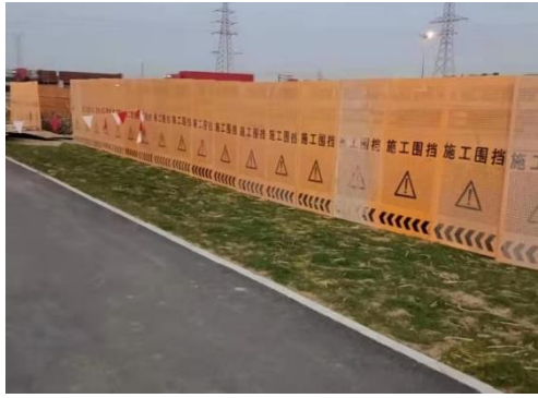
图 8-1 本工程施工期设置围挡照片
