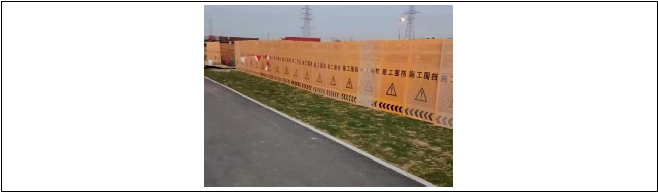
图 6-1 本工程施工期设置围挡照片
