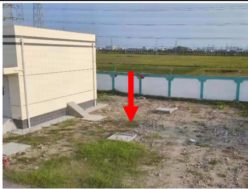
220kV邓庄变本期新建事故油池
