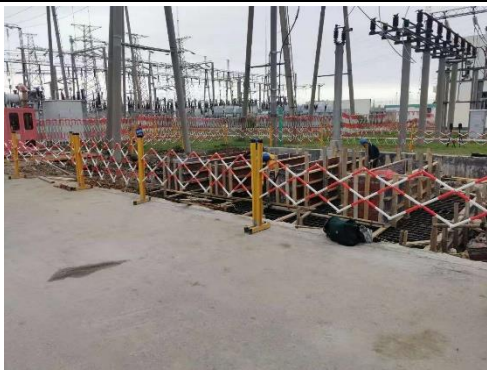
图6-2 220kV邓庄变事故油池照片
