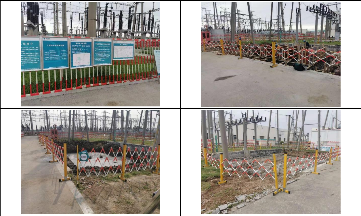
图 8-1 施工期设置围挡照片
