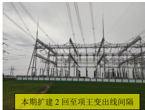
图 3-10 旗杰 500kV 变电站间隔扩建工程
