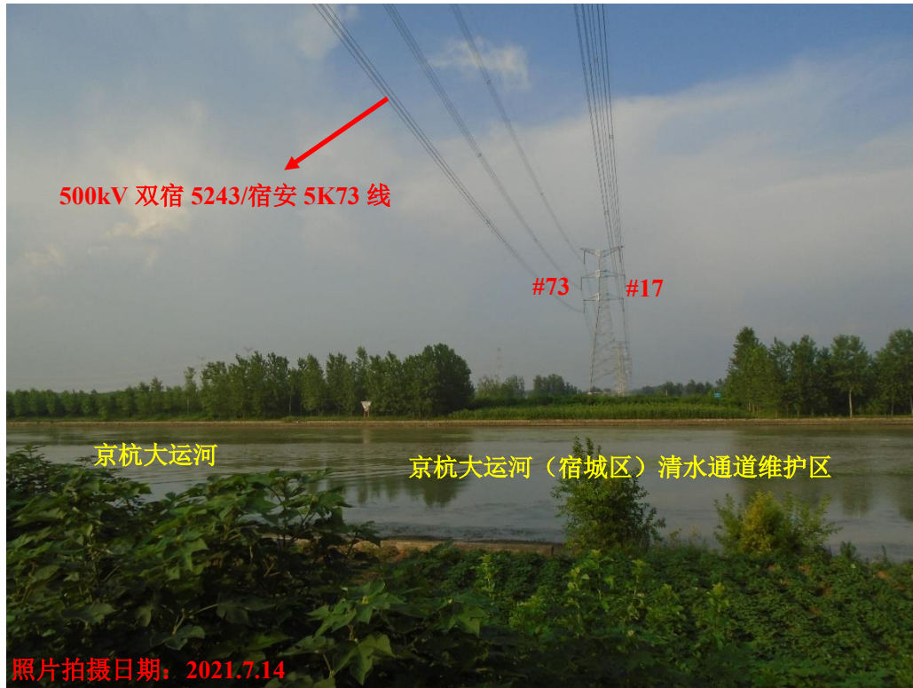
图 6-1-4-2 本工程线路跨越京杭大运河（宿城区）清水通道维护区照片
