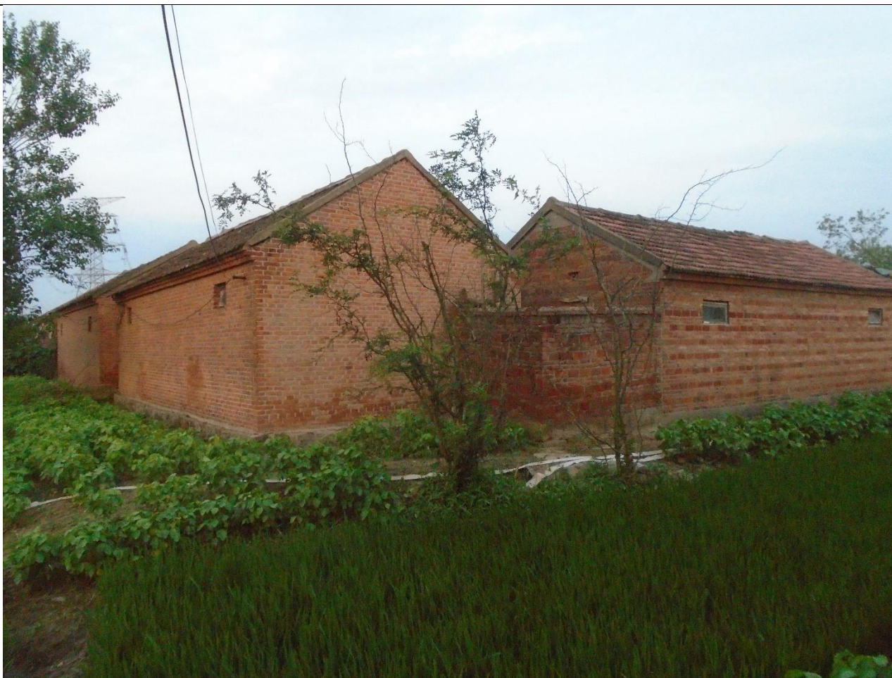
宿迁市仰化镇卜圩村七组民房 变电站南侧，最近 145m
