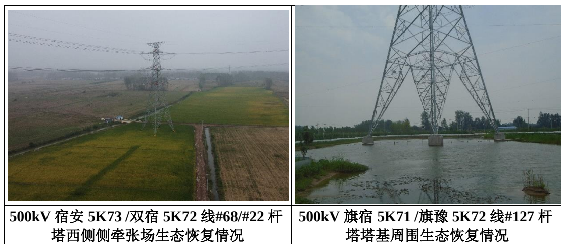
图 6-2 工程占地生态恢复示例（b）
