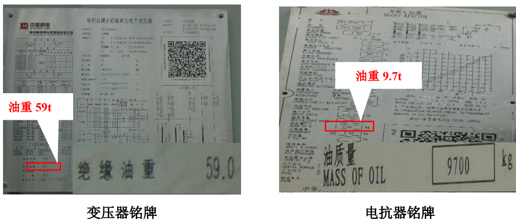
图 3-5 宿豫 500kV 变电站主变压器及电抗器铭牌照片
