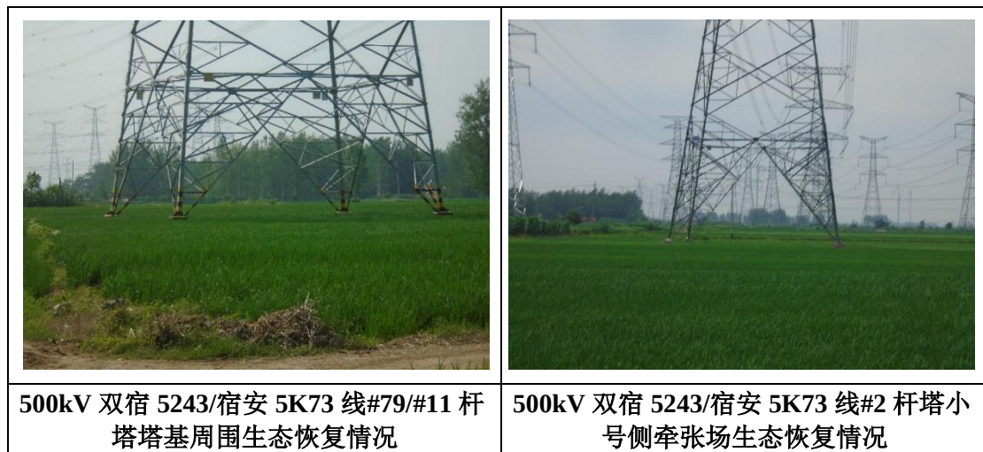
图 6-2 工程占地生态恢复示例（a）
