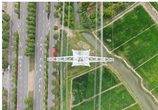
T251 号杆塔建成后低空照片 (2021.8)
