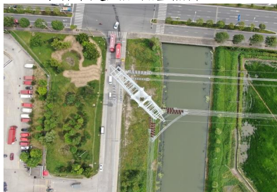
T249 号杆塔建成后低空照片 (2021.8)
