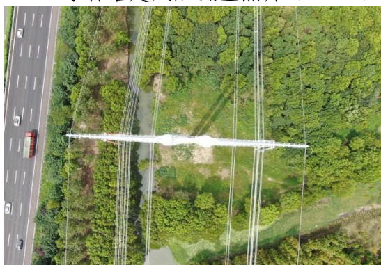
T230 号杆塔建成后低空照片 (2021.8)
