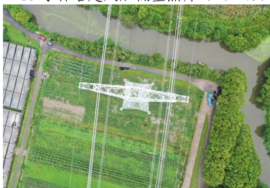
T263 号杆塔建成后低空照片 (2021.8)
