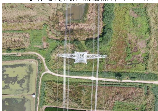
T149 号杆塔建成后低空照片 (2021.8)
