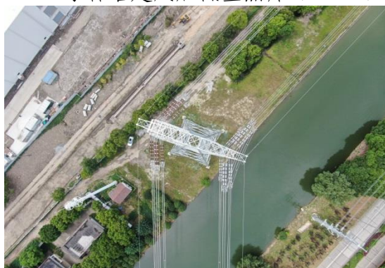
T215 号杆塔建成后低空照片 (2021.8)
