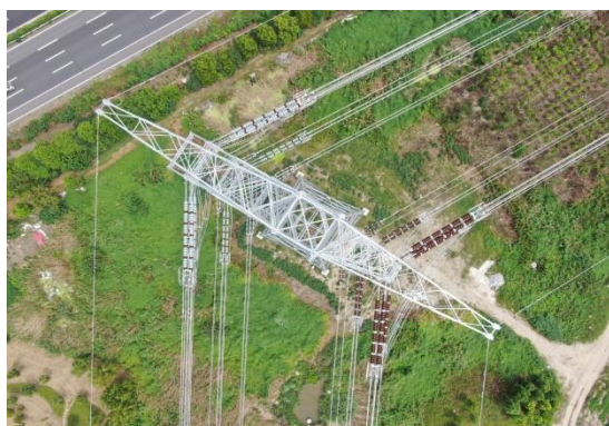
T225 号杆塔建成后低空照片 (2021.8)
