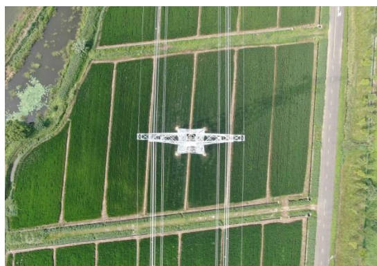
T141 号杆塔建成后低空照片 (2021.8)
