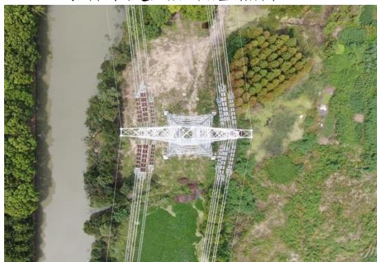
T232 号杆塔建成后低空照片 (2021.8)
