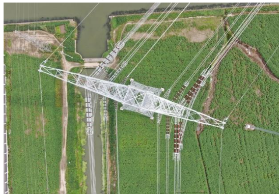
T254 号杆塔建成后低空照片 (2021.8)
