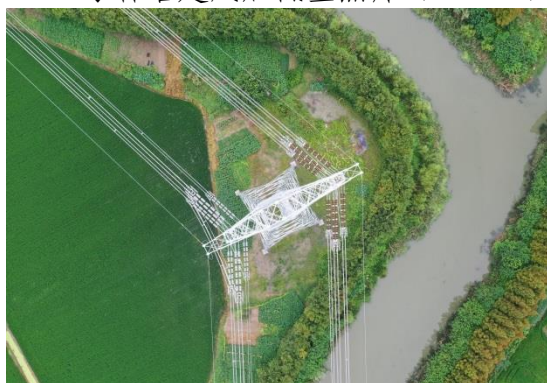
T258 号杆塔建成后低空照片 (2021.8)
