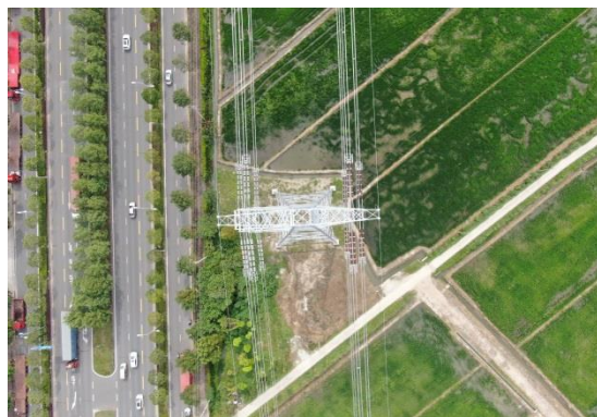
T250 号杆塔建成后低空照片 (2021.8)
