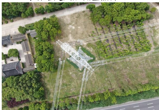
T228 号杆塔建成后低空照片 (2021.8)
