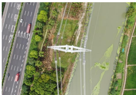
T239 号杆塔建成后低空照片 (2021.8)
