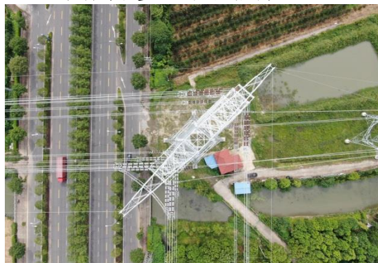
T252 号杆塔建成后低空照片 (2021.8)
