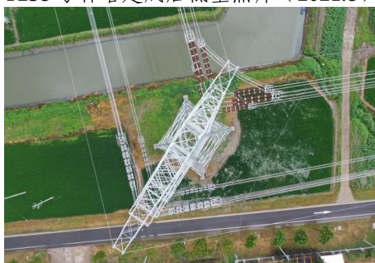
T259 号杆塔建成后低空照片 (2021.8)
