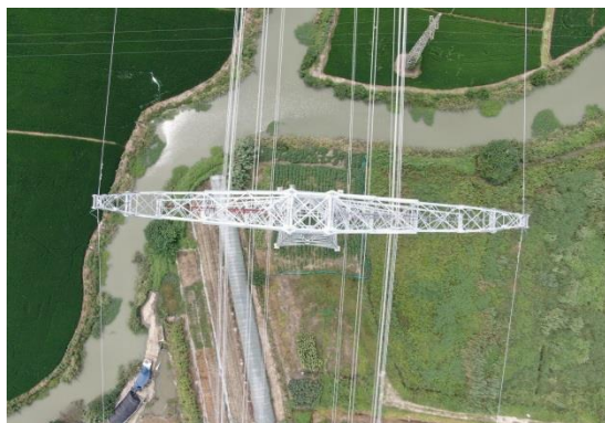
T205 号杆塔建成后低空照片 (2021.8)
