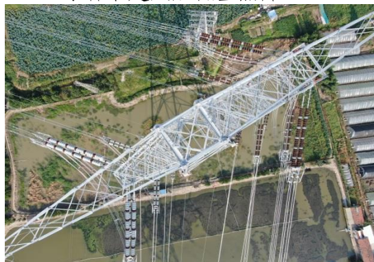
T203 号杆塔建成后低空照片 (2021.8)
