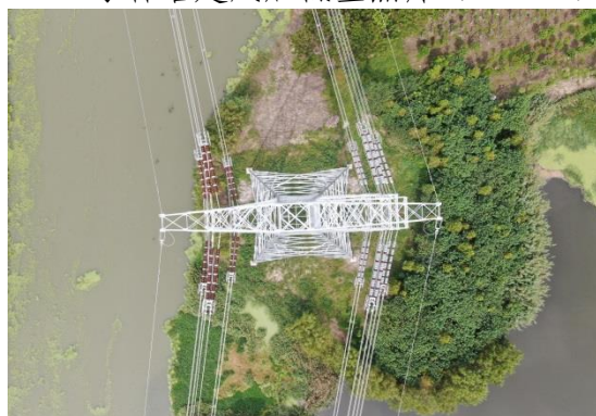
T240 号杆塔建成后低空照片 (2021.8)
