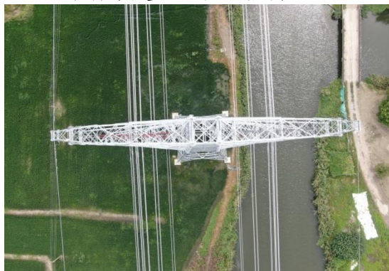
T207 号杆塔建成后低空照片 (2021.8)
