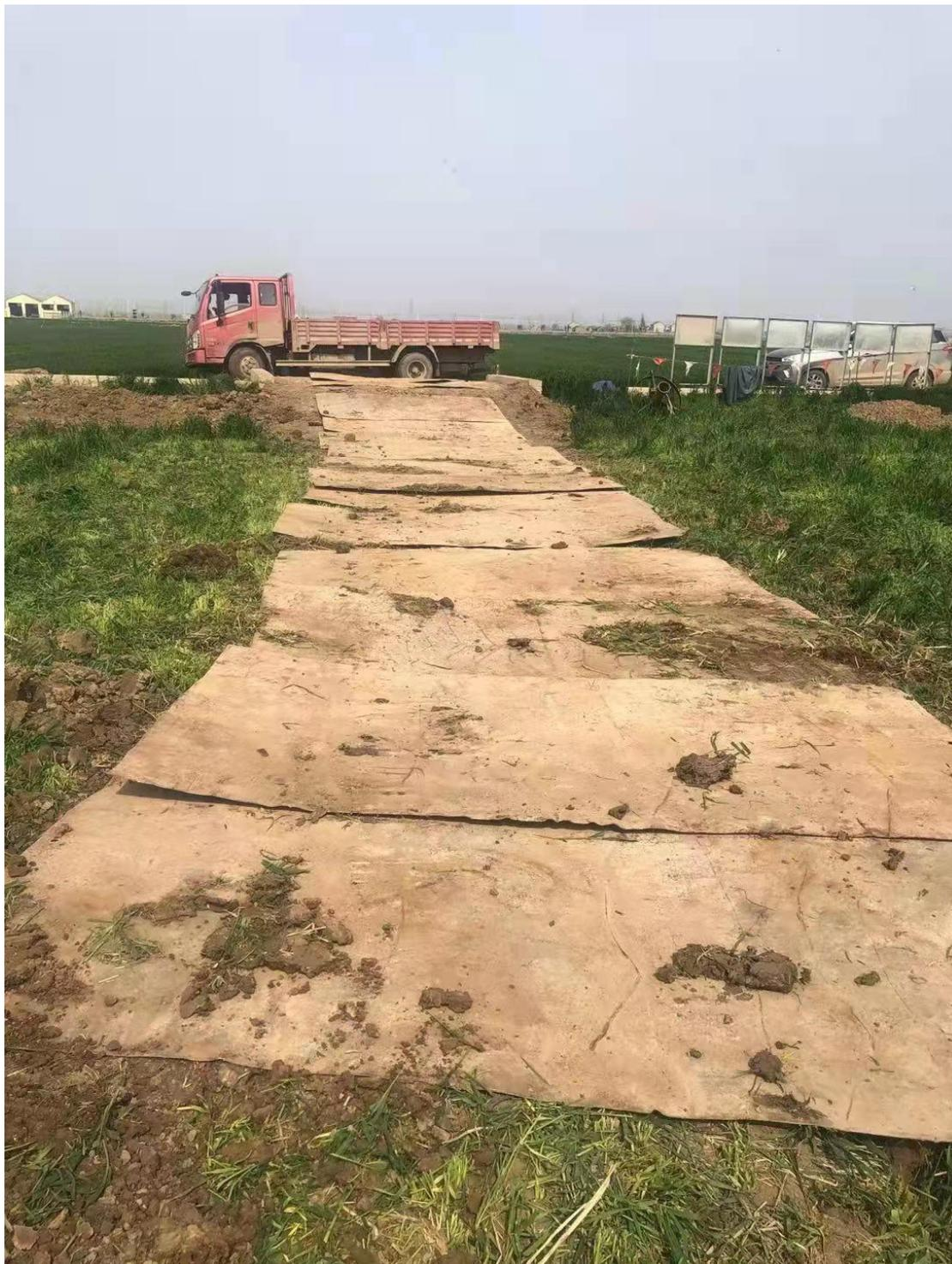
照片 1 施工现场钢板铺设
