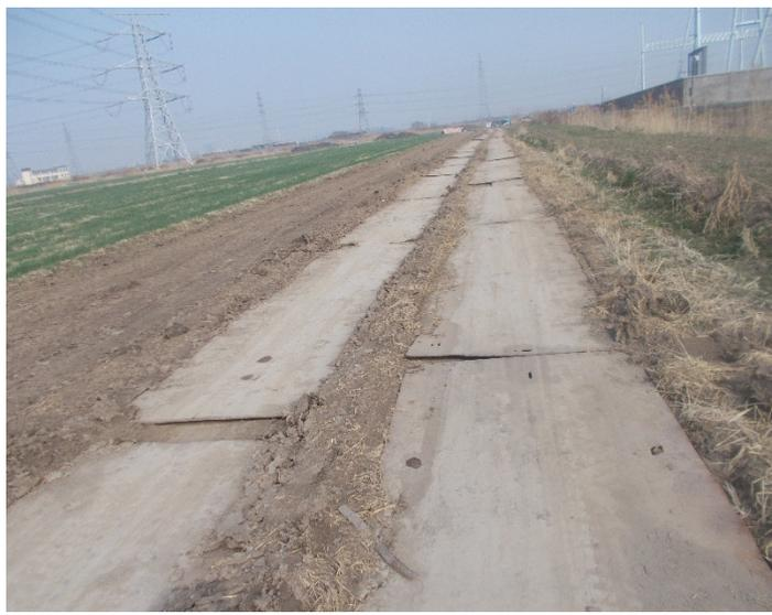
电缆施工施工临时道路区 铺设钢板 (2021年3月)
