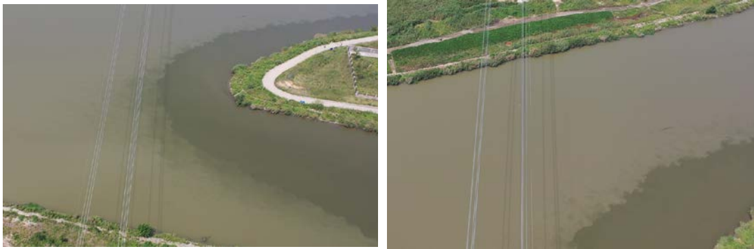
跨越大浦河河道两侧现场图
