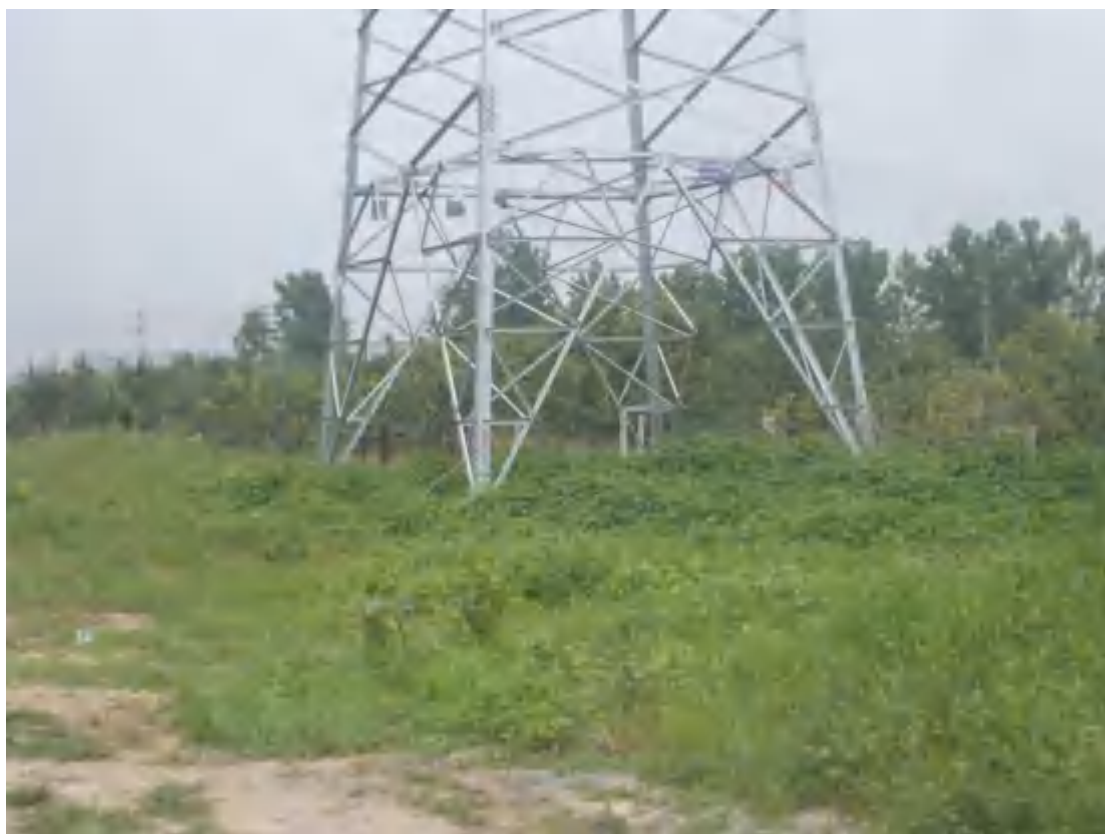
2021.7.16 3#塔 塔基区撒播草籽+复耕
