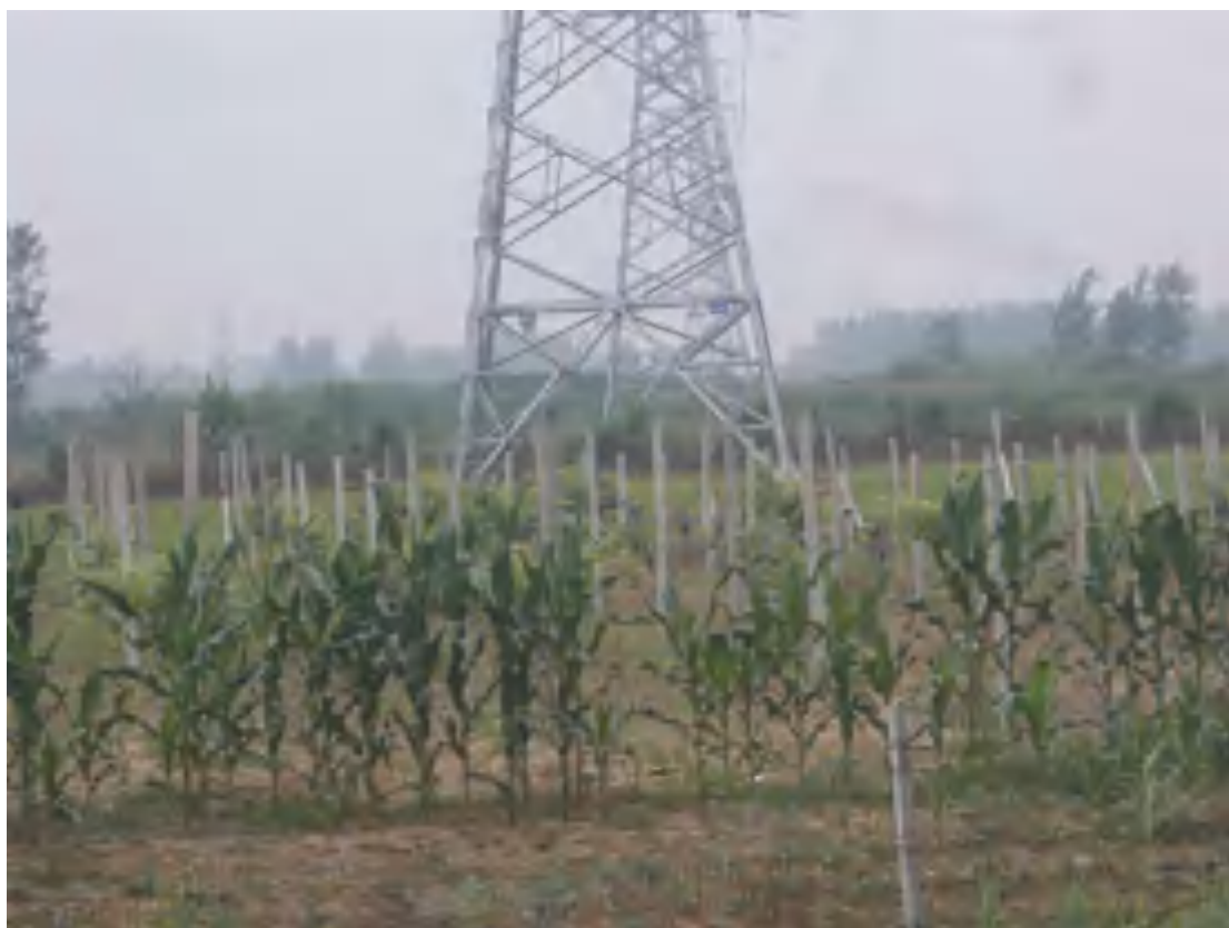
2021.7.16 1#塔 塔基区土地整治（复耕）
