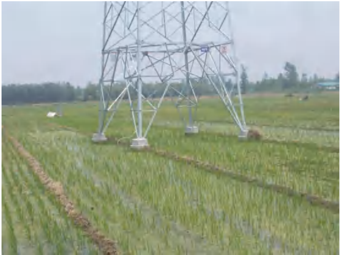
2021.7.16 16#塔 塔基区土地整治（复耕）
