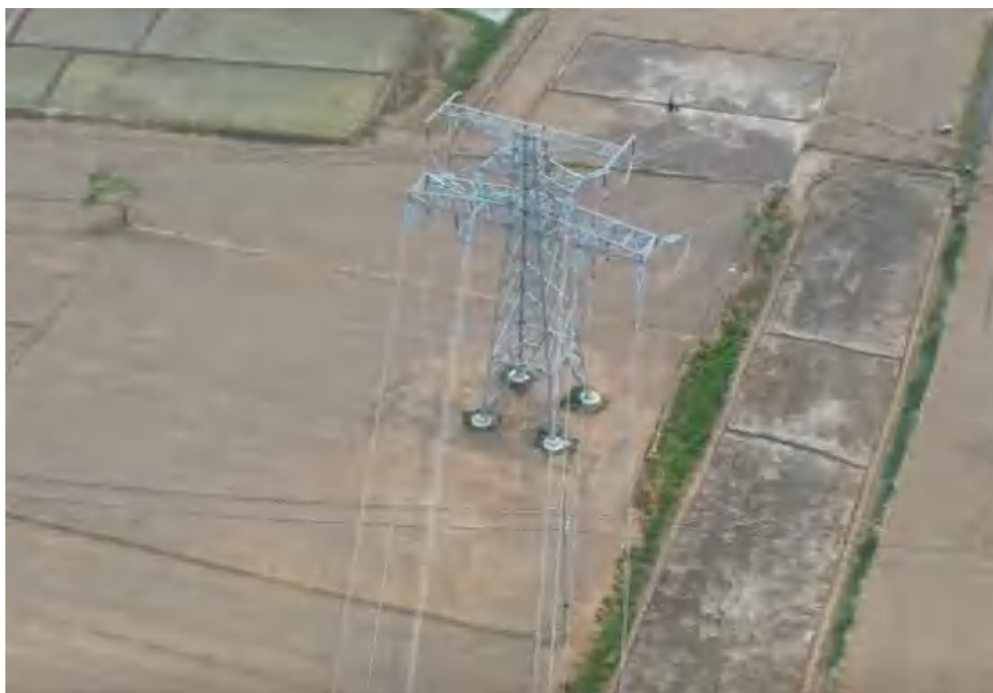
2021.7.16 7#塔 塔基区土地整治（复耕）
