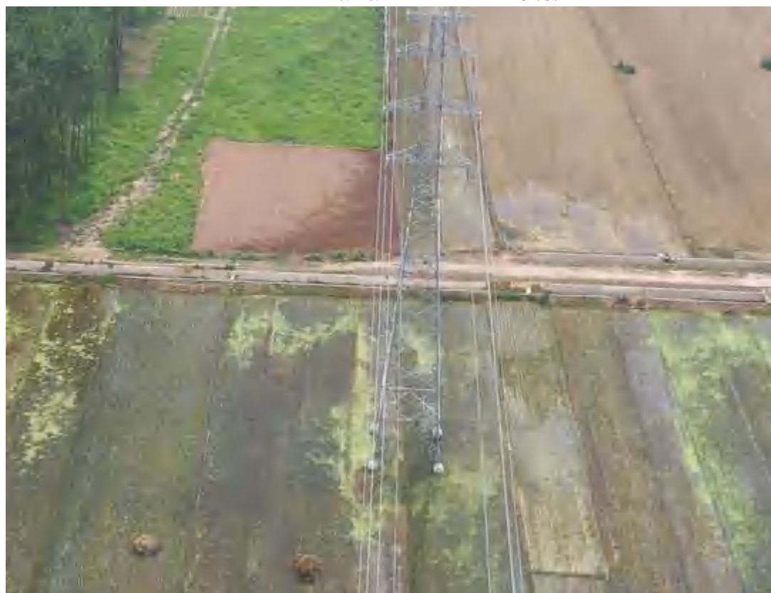
2021.7.16 26#塔 塔基区土地整治（复耕）
