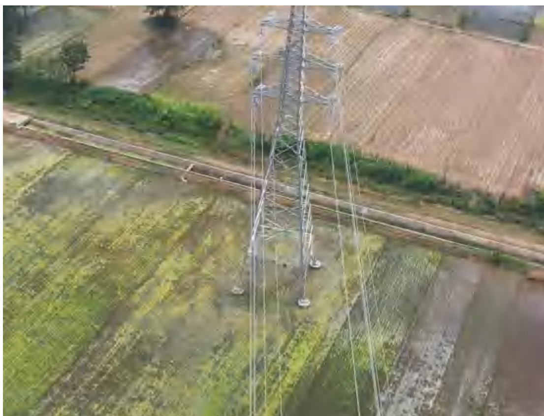
2021.7.16 25#塔 塔基区土地整治（复耕）
