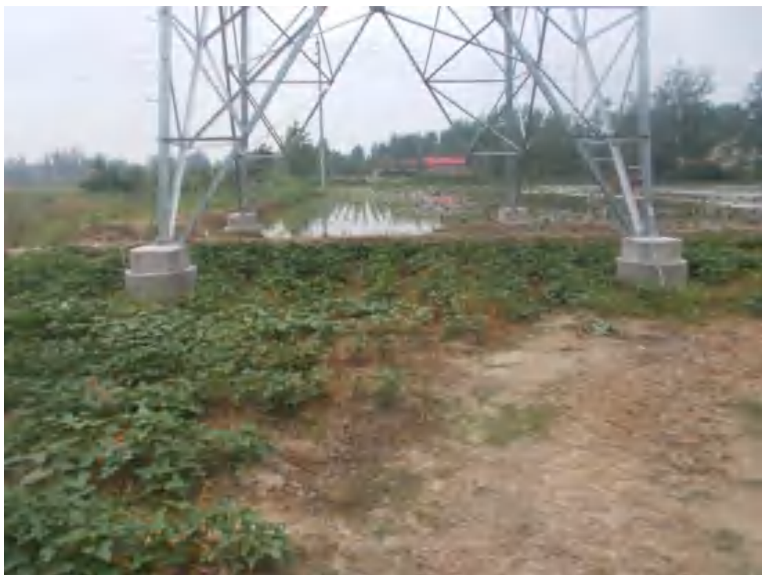
2021.7.16 11#塔 塔基区土地整治（复耕）
