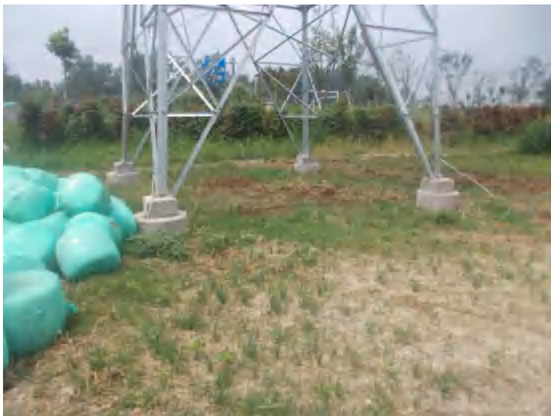
2021.7.16 4#塔 塔基区撒播草籽
