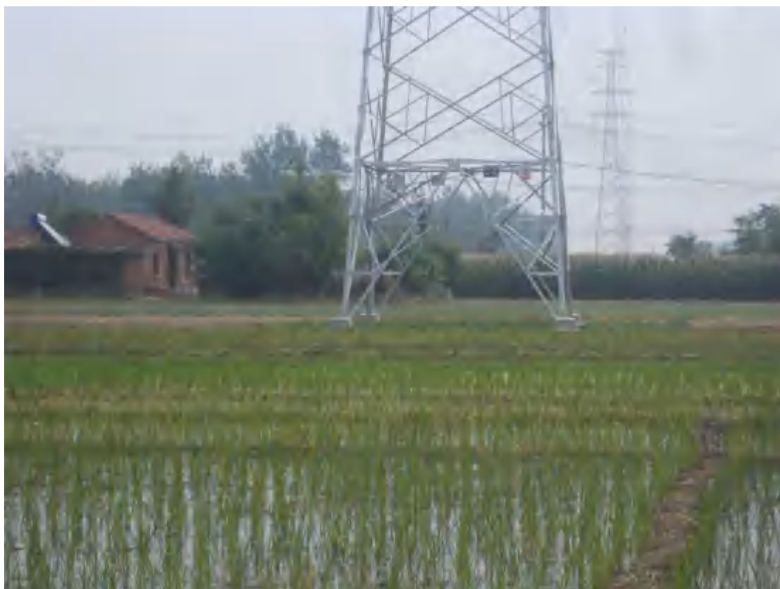
2021.7.16 9#塔 塔基区土地整治（复耕）
