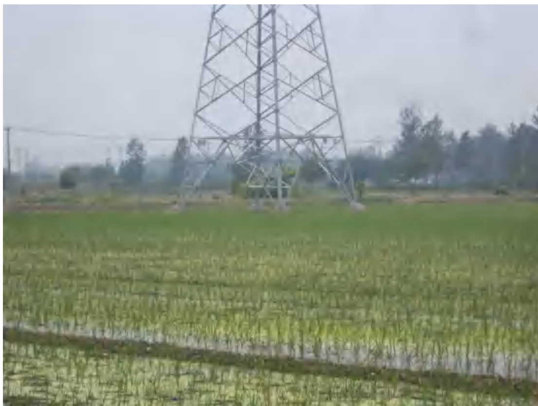
2021.7.16 25#塔 塔基区土地整治（复耕）
