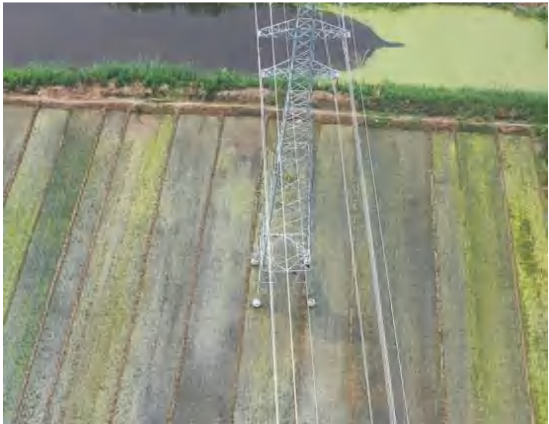
2021.7.16 16#塔 塔基区土地整治（复耕）
