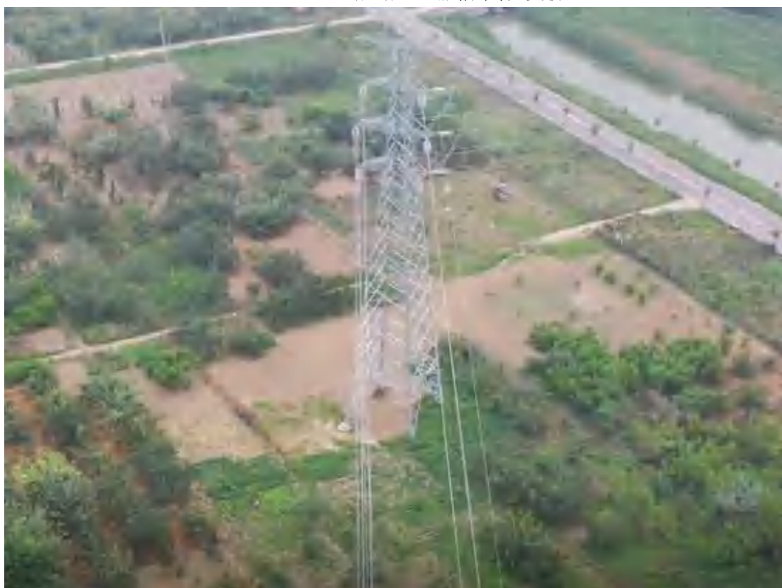
2021.7.16 2#塔 塔基区撒播草籽+复耕
