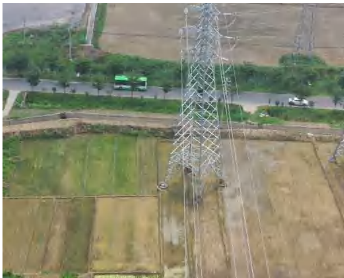
2021.7.16 27#塔 塔基区土地整治（复耕）
