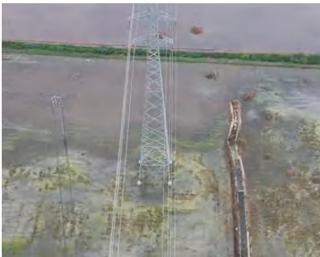
2021.7.16 12#塔 塔基区土地整治（复耕）
