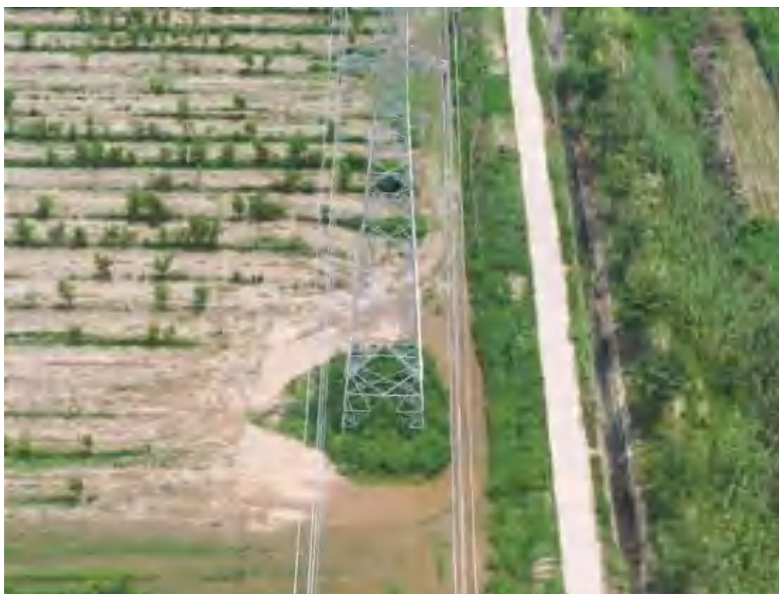
2021.7.16 22#塔 塔基区撒播草籽
