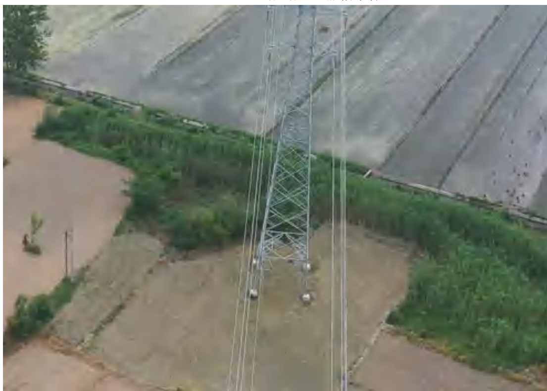
2021.7.16 24#塔 塔基区撒播草籽
