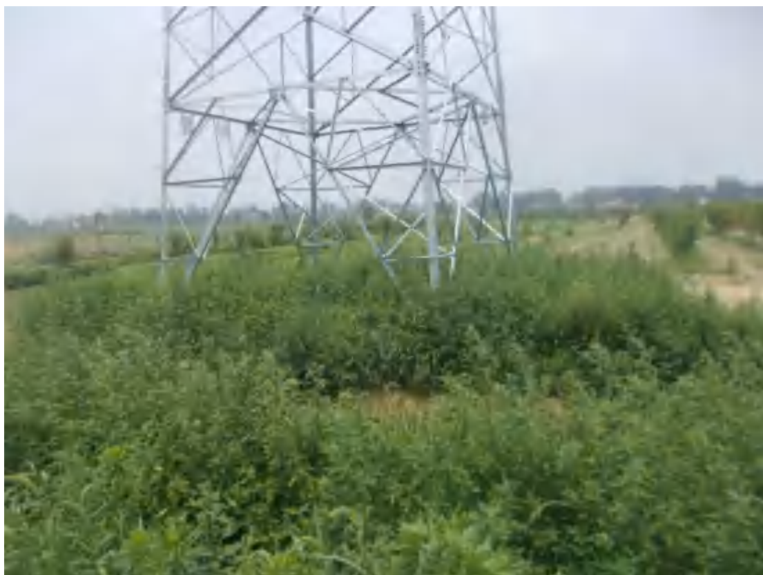
2021.7.16 22#塔 塔基区撒播草籽
