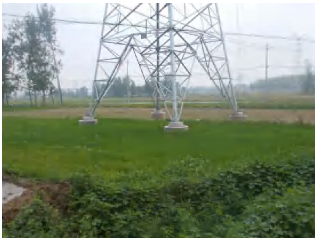
2021.7.16 6#塔 塔基区土地整治（复耕）
