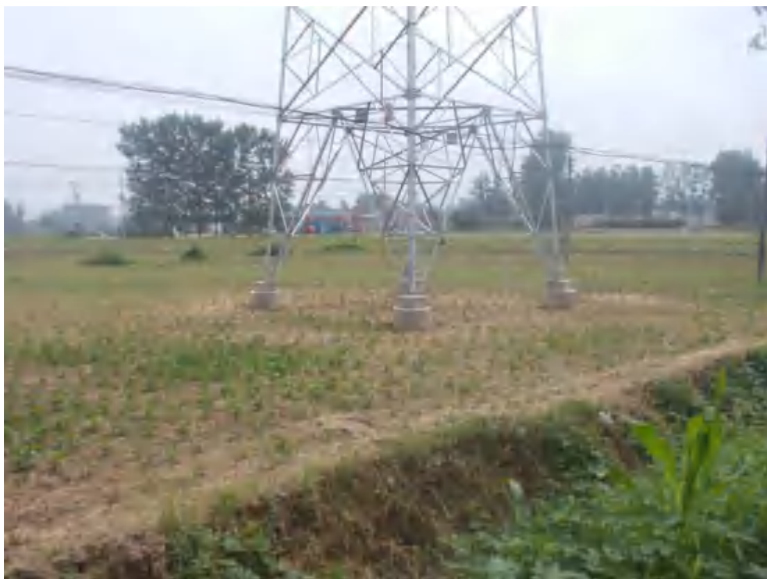
2021.7.16 5#塔 塔基区土地整治（复耕）
