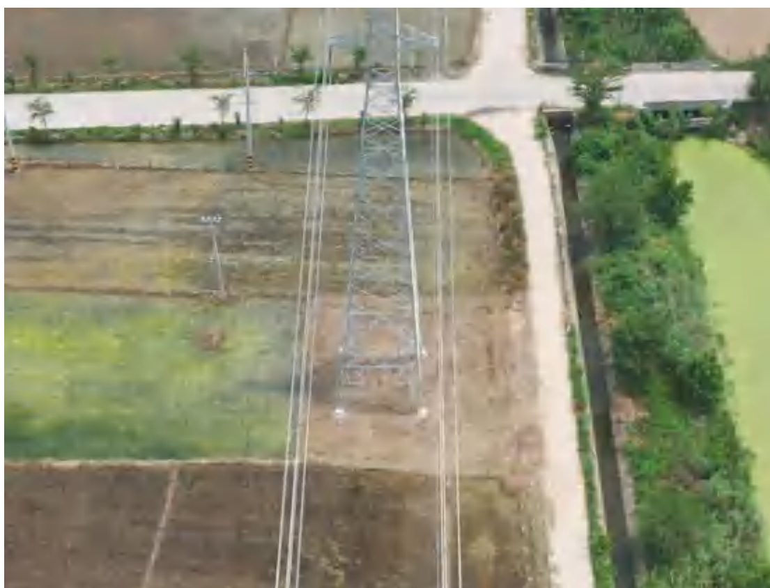
2021.7.16 21#塔 塔基区土地整治（复耕）
