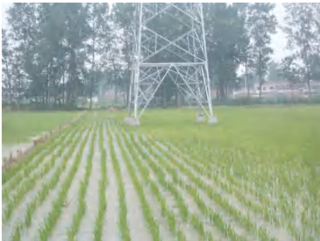
2021.7.16 13#塔 塔基区土地整治（复耕）
