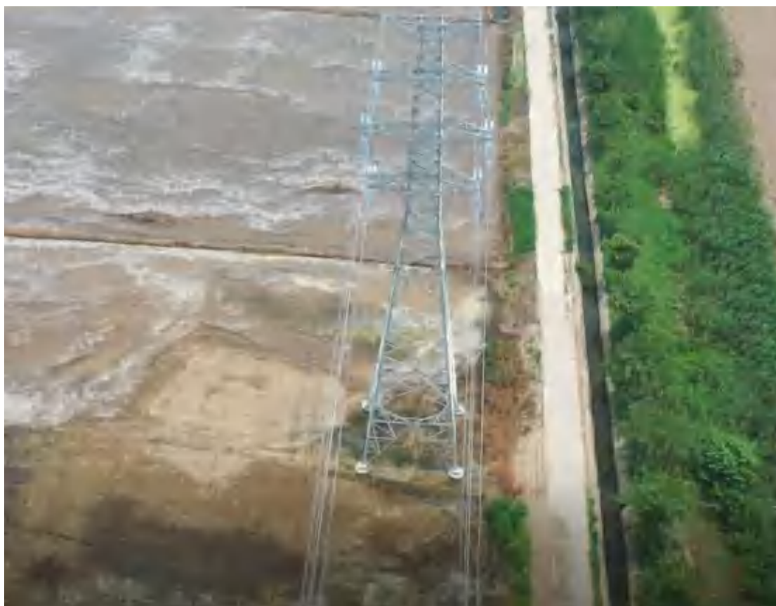
2021.7.16 20#塔 塔基区撒播草籽+复耕
