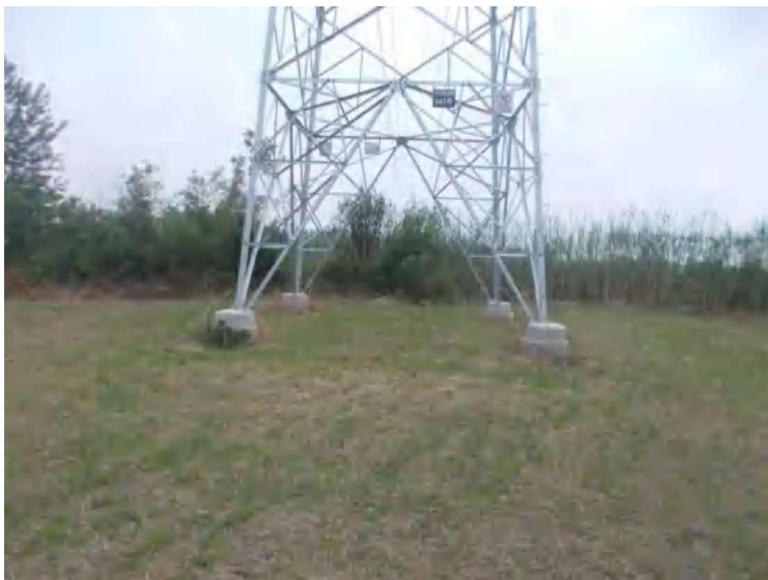
2021.7.16 24#塔 塔基区撒播草籽
