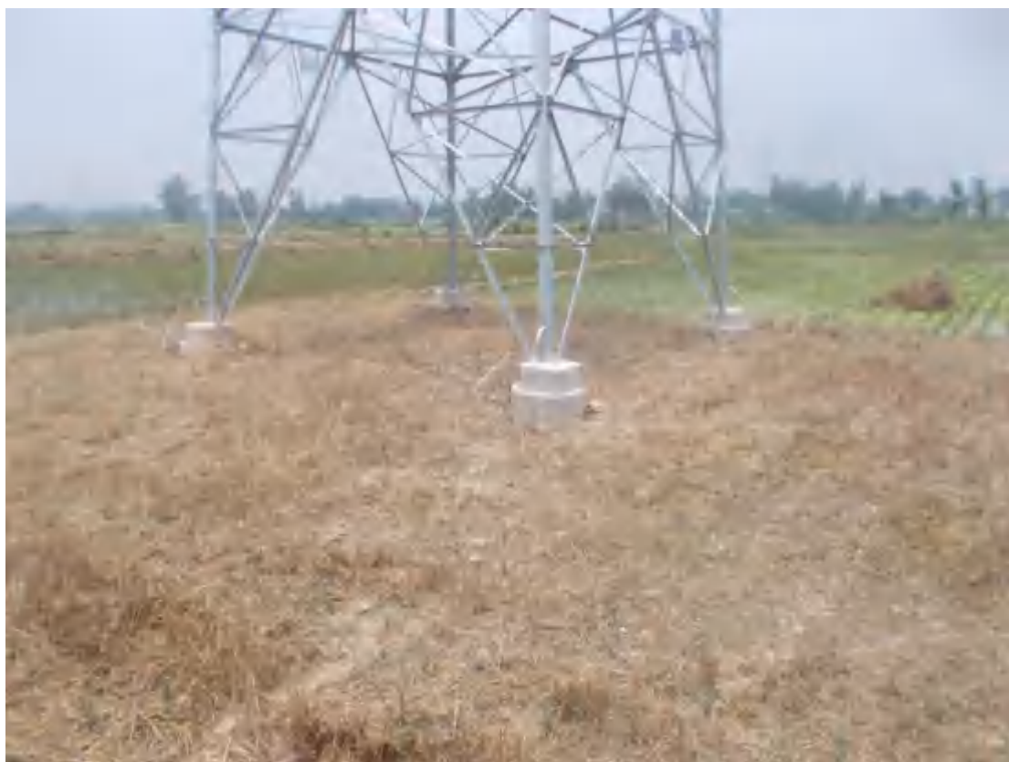
2021.7.16 21#塔 塔基区土地整治（复耕）
