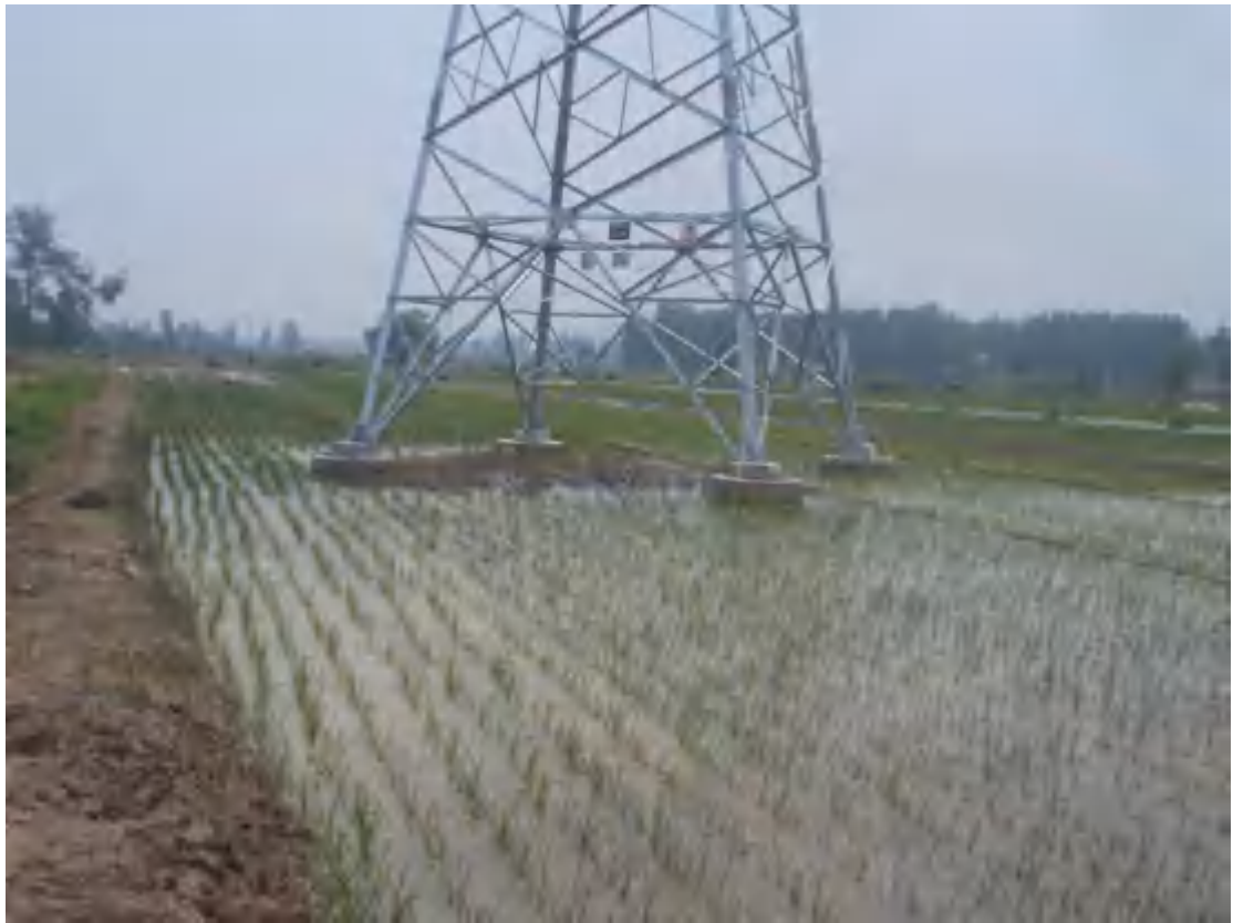
2021.7.16 15#塔 塔基区土地整治（复耕）
