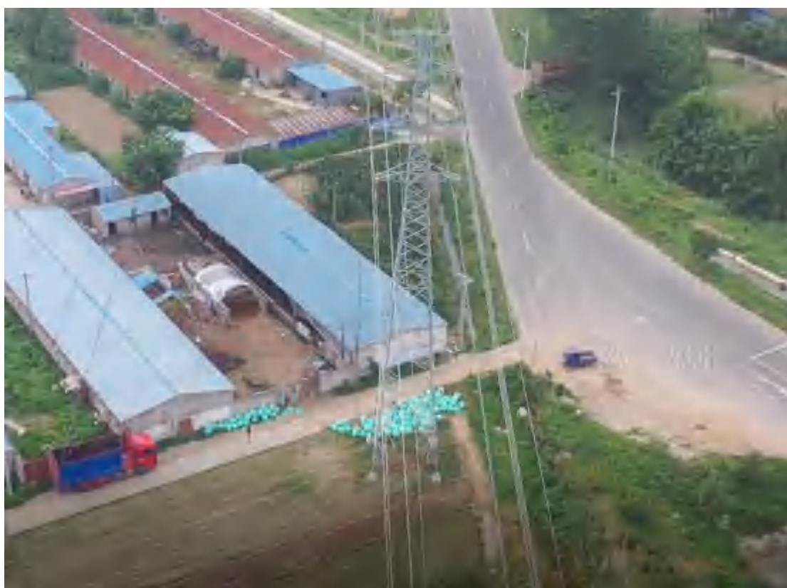
2021.7.16 4#塔 塔基区撒播草籽
