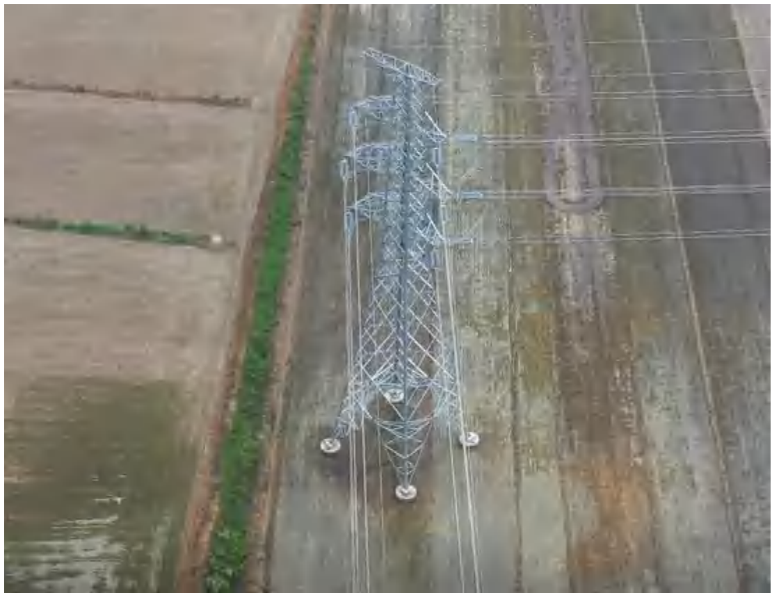
2021.7.16 15#塔 塔基区土地整治（复耕）
