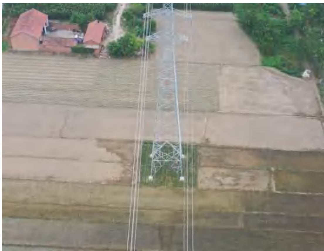
2021.7.16 9#塔 塔基区撒播草籽
