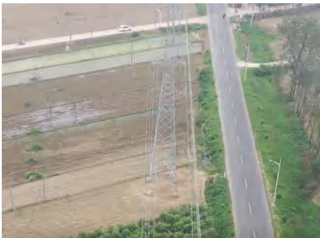
2021.7.16 5#塔 塔基区土地整治（复耕）
