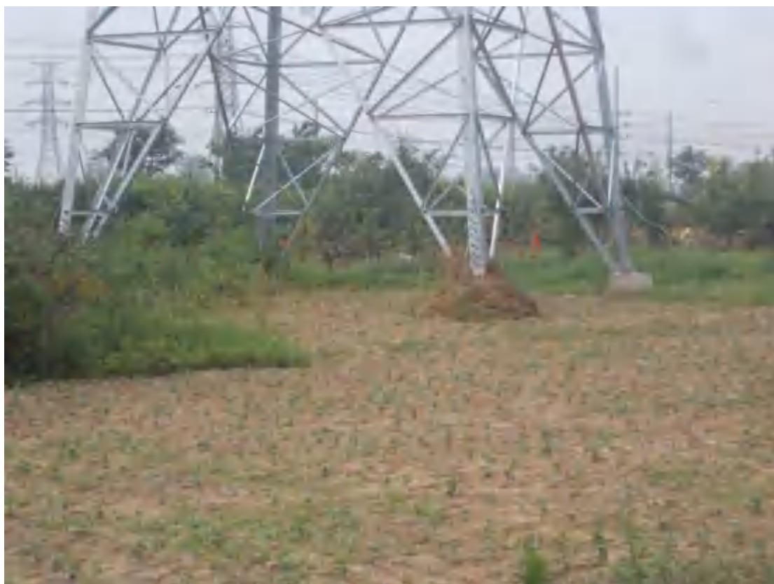
2021.7.16 2#塔 塔基区撒播草籽+复耕
