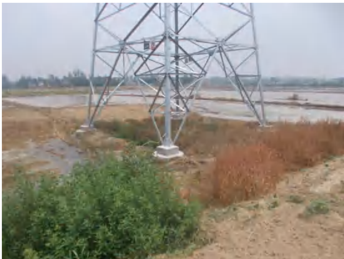
2021.7.16 20#塔 塔基区撒播草籽+复耕
