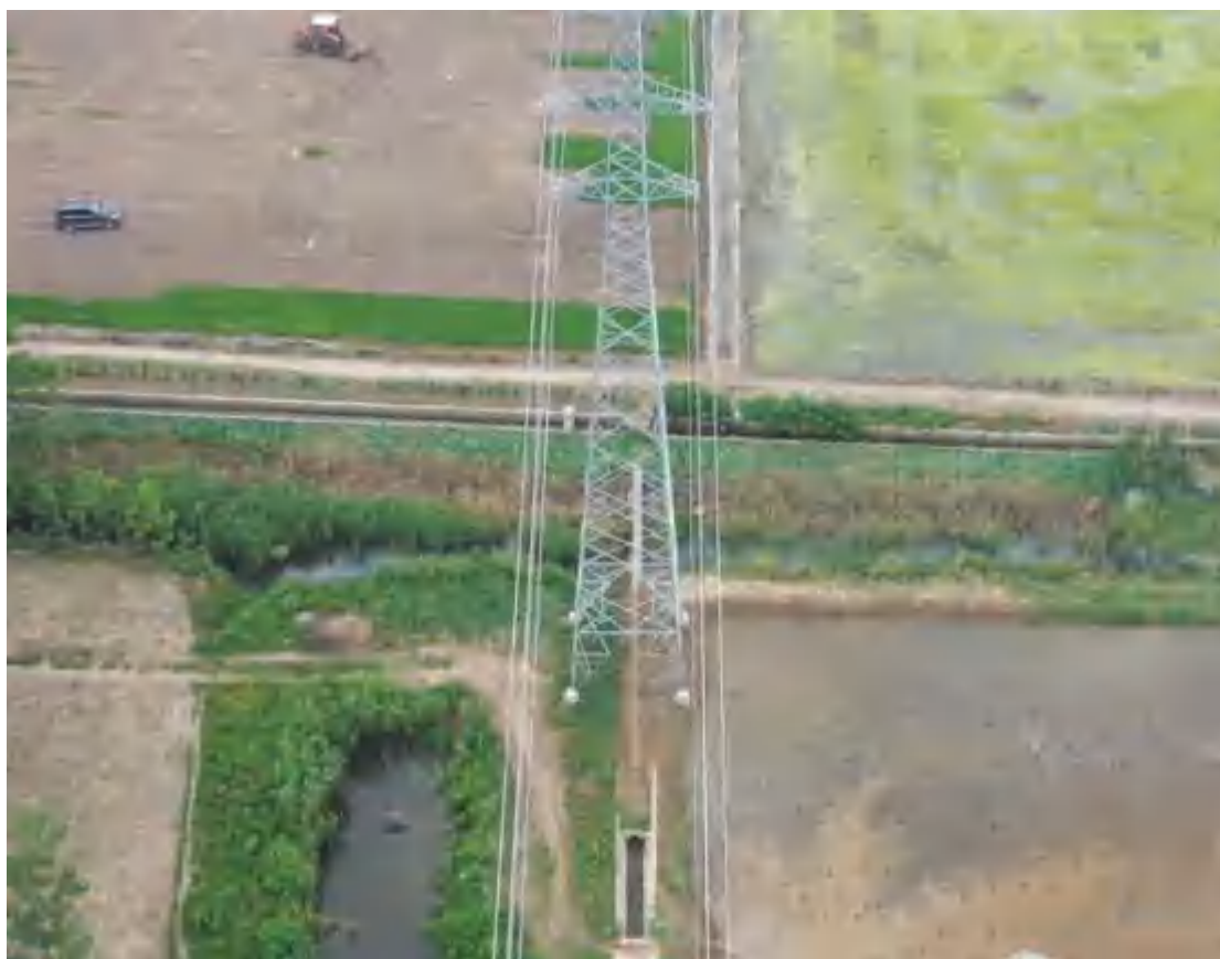
2021.7.16 11#塔 塔基区土地整治（复耕）
