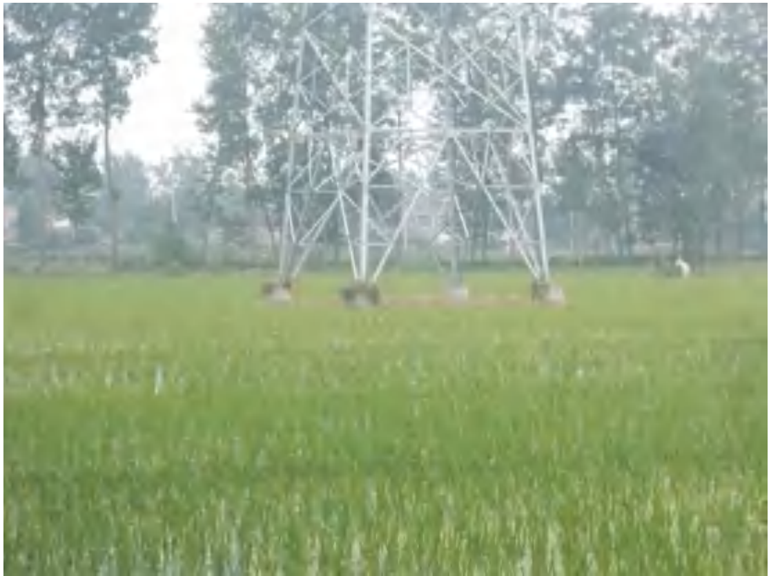
2021.7.16 14#塔 塔基区土地整治（复耕）
