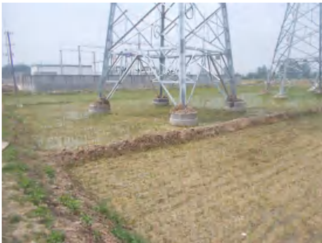
2021.7.16 27#塔 塔基区土地整治（复耕）
