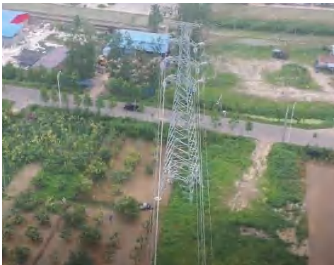
2021.7.16 3#塔 塔基区撒播草籽+复耕
