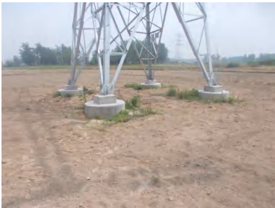
2021.7.16 7#塔 塔基区土地整治（复耕）
