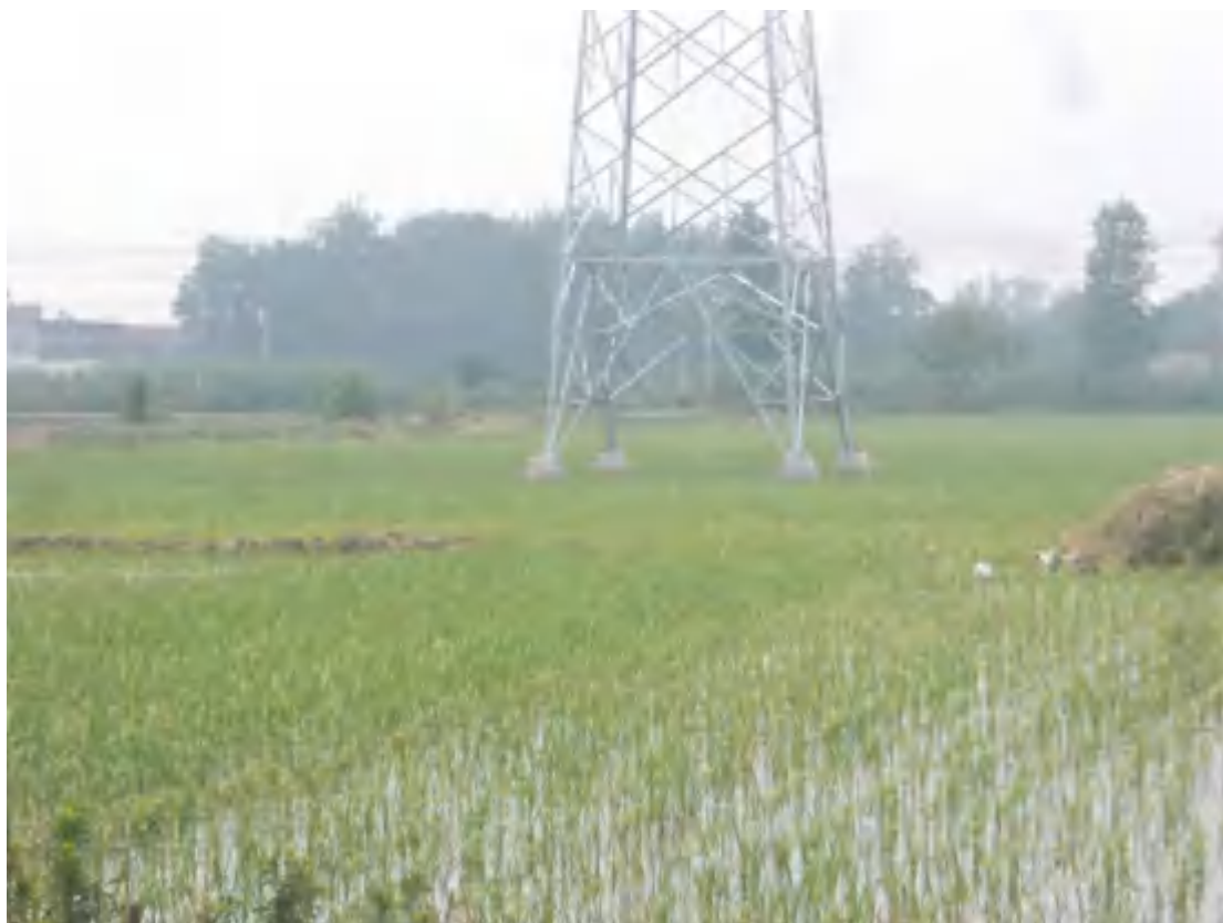
2021.7.16 26#塔 塔基区土地整治（复耕）
