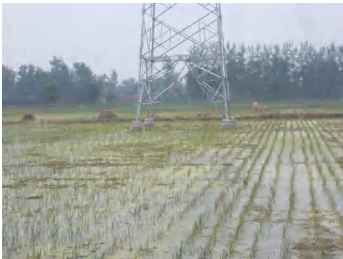
2021.7.16 12#塔 塔基区土地整治（复耕）
