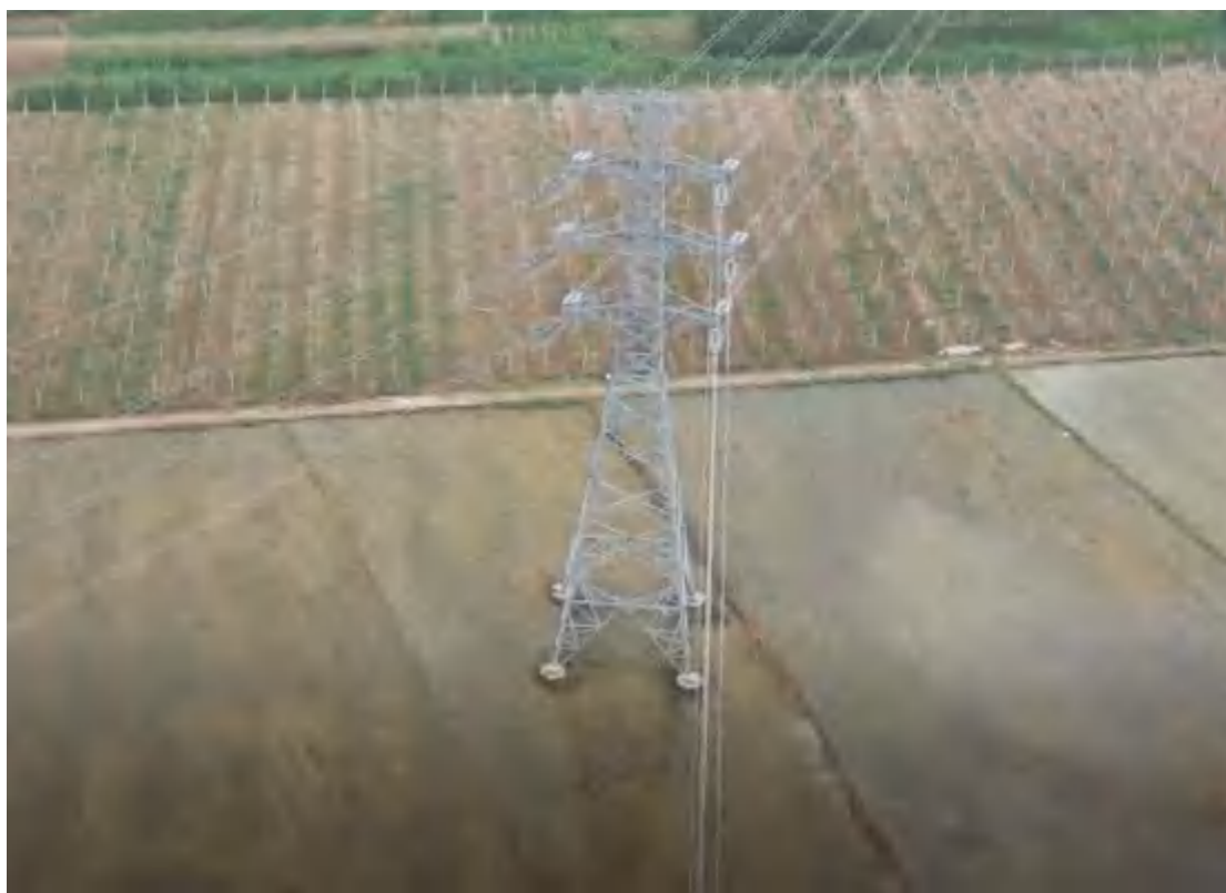
2021.7.16 1#塔 塔基区土地整治（复耕）
