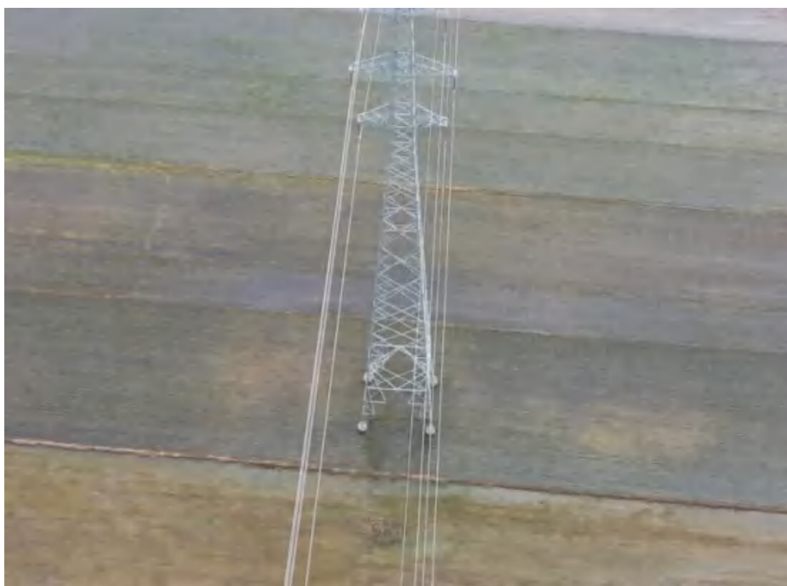
2021.7.16 13#塔 塔基区土地整治（复耕）
