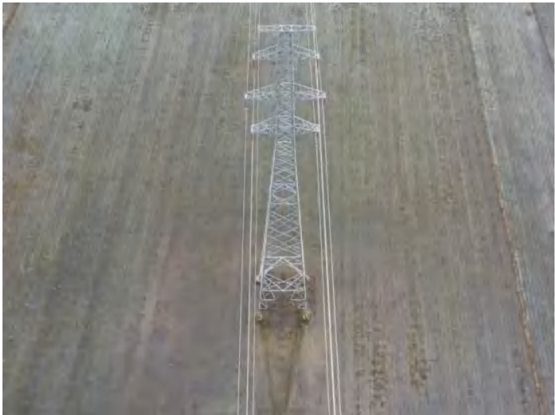
2021.7.16 14#塔 塔基区土地整治（复耕）
