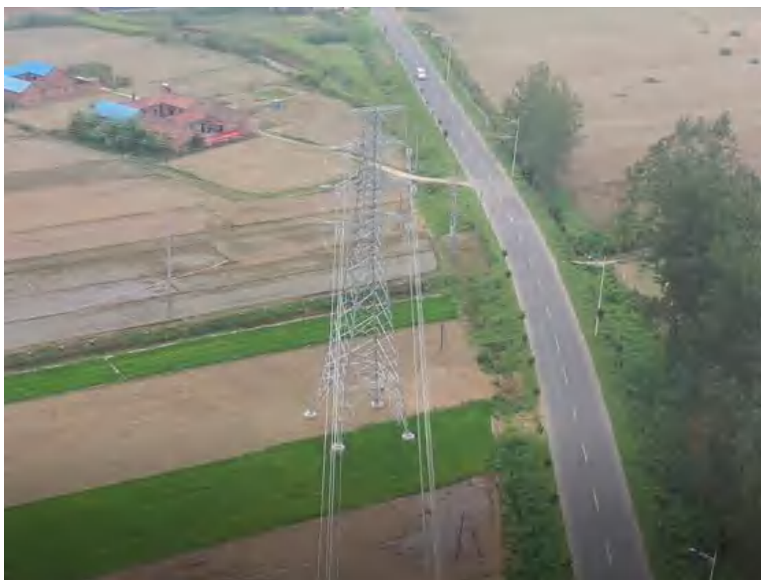
2021.7.16 6#塔 塔基区土地整治（复耕）
