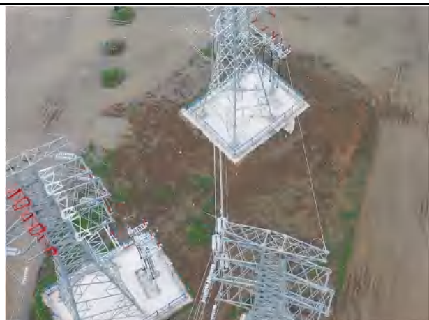
电缆施工区 复耕 (2021.07)
