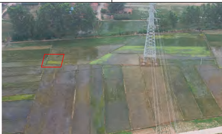
拆除线路区 复耕 (2021.07)
