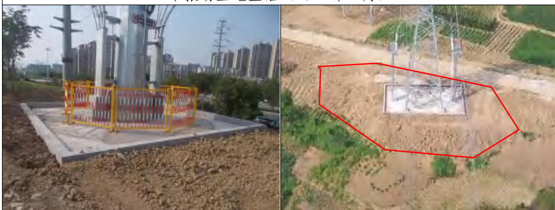
电缆施工区土地整治（2021 年 5 月）
