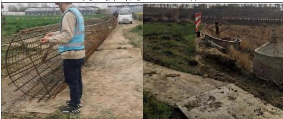
施工临时道路区铺设钢板（2021 年 3 月）
