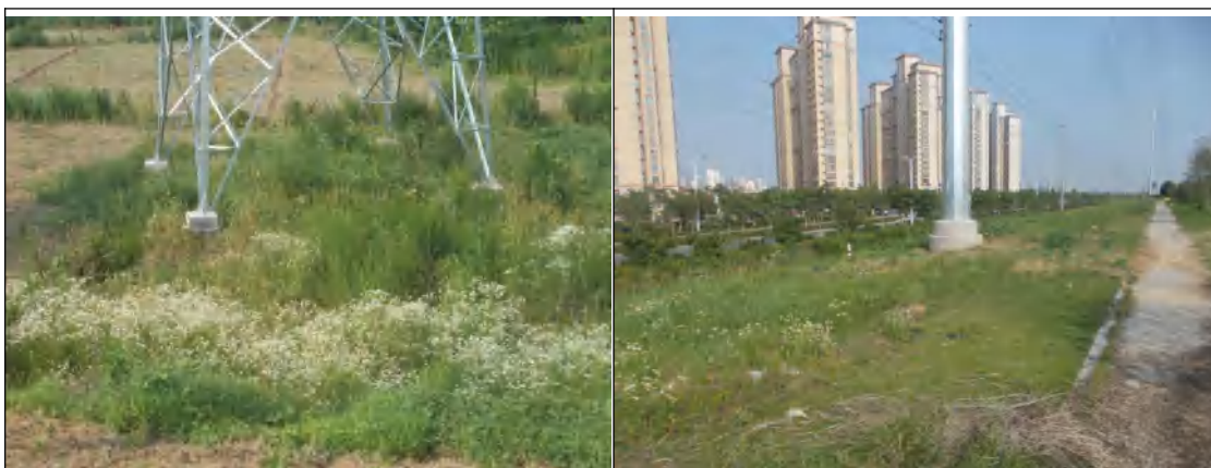
塔基区撒播狗牙根草籽（2021年6月）
