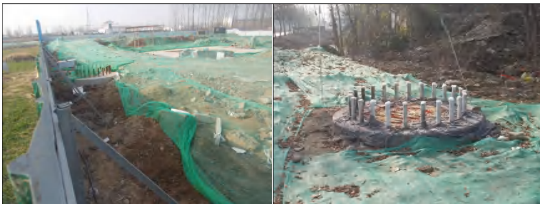
塔基区密目网苫盖（2020 年 11 月）
