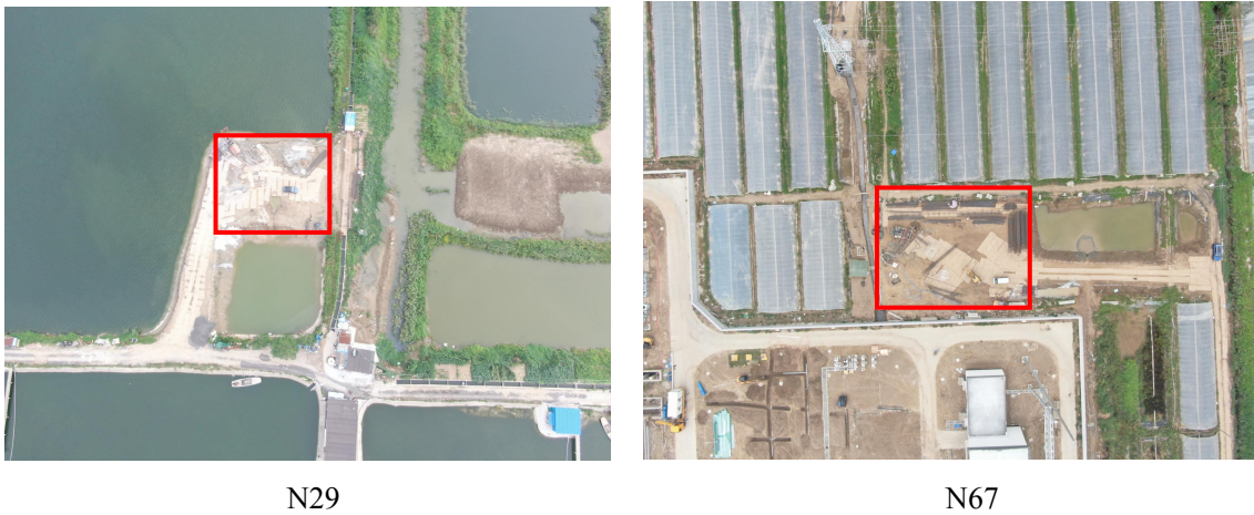
图 3-1 塔基区扰动面积现状图
