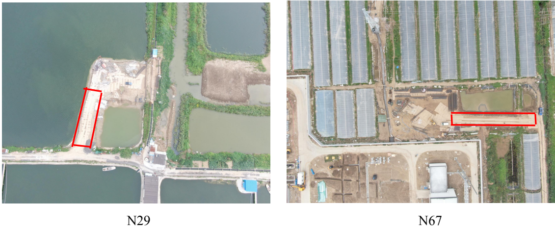
图 3-2 施工道路区扰动面积现状图
