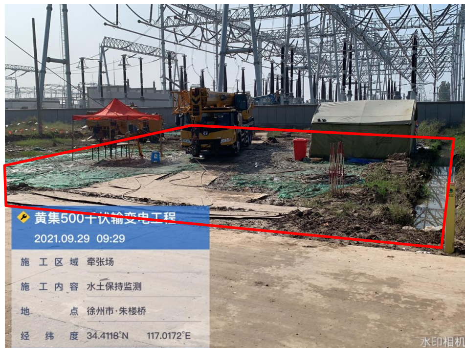
变电站北侧牵张场扰动面积解译图-9月
