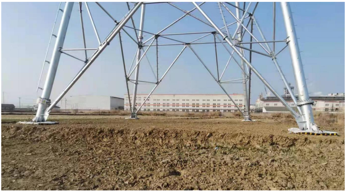
塔基及塔基施工区扰动面积图-12月
