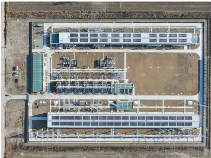
变电站区扰动面积解译图-12 月
