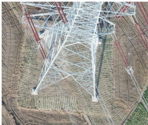
塔基及塔基施工区耕地恢复
