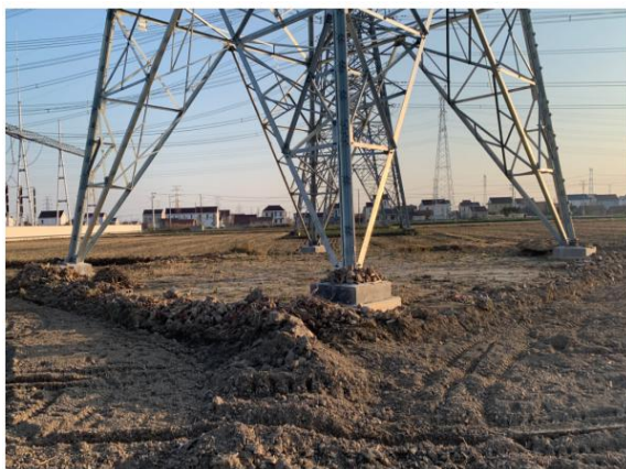
塔基及塔基施工区土地整治
