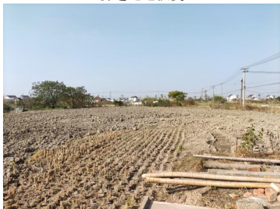
拆迁迹地恢复
