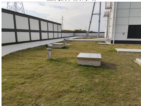
主变事故油池
