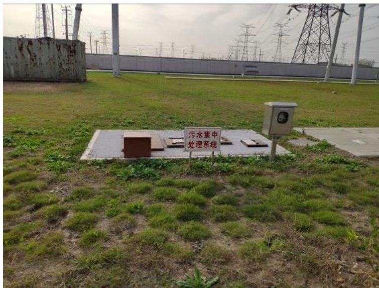
图 9.2-1 扶海变电站地埋式污水处理设施
