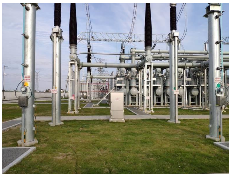
图 3.1-5 扶海 500kV 变电站本期扩建间隔场地
