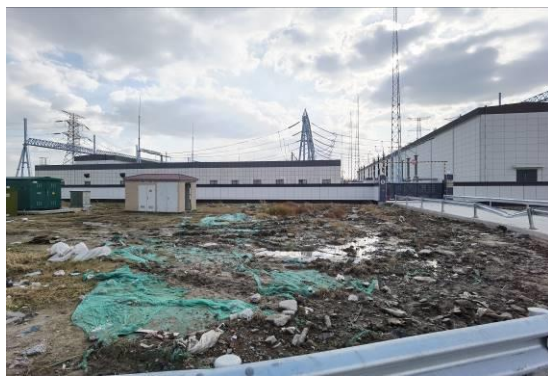
施工期防尘网苫盖
