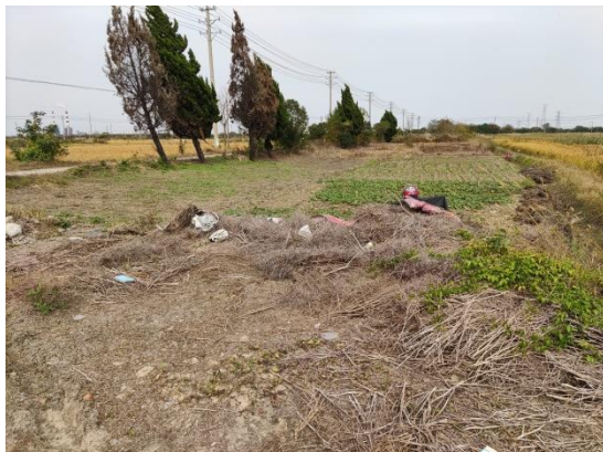
拆迁迹地恢复
