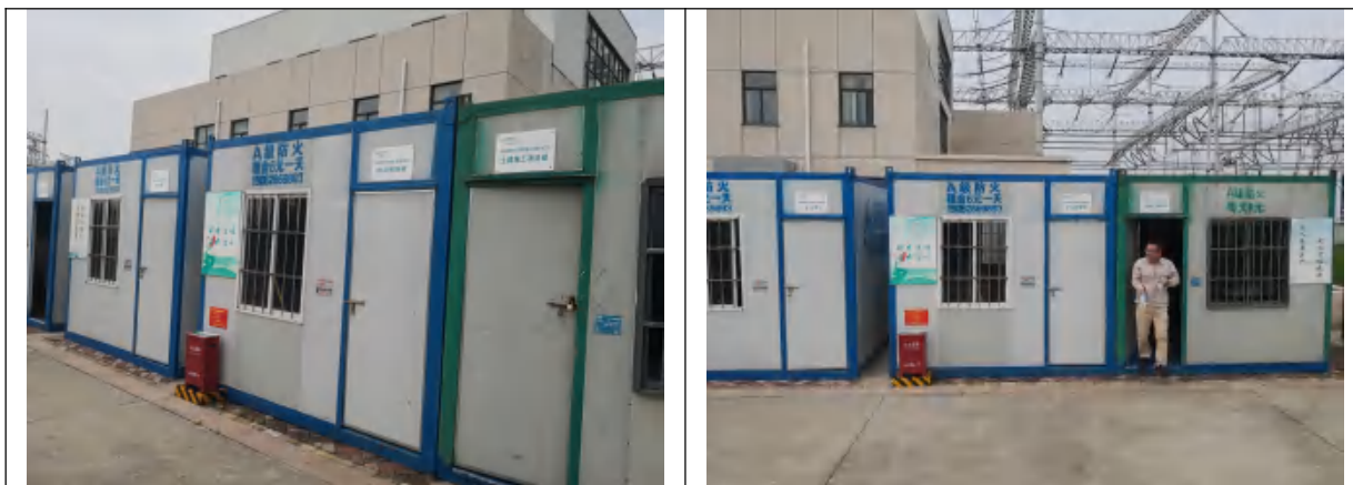
租用变电站进站大门右侧硬化场地，用集装箱设置临时办公场所
