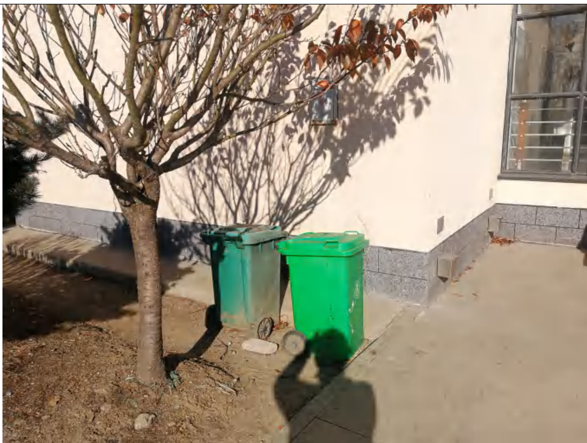
图 10.2 高邮 500kV 变电站站内设置垃圾收集桶
