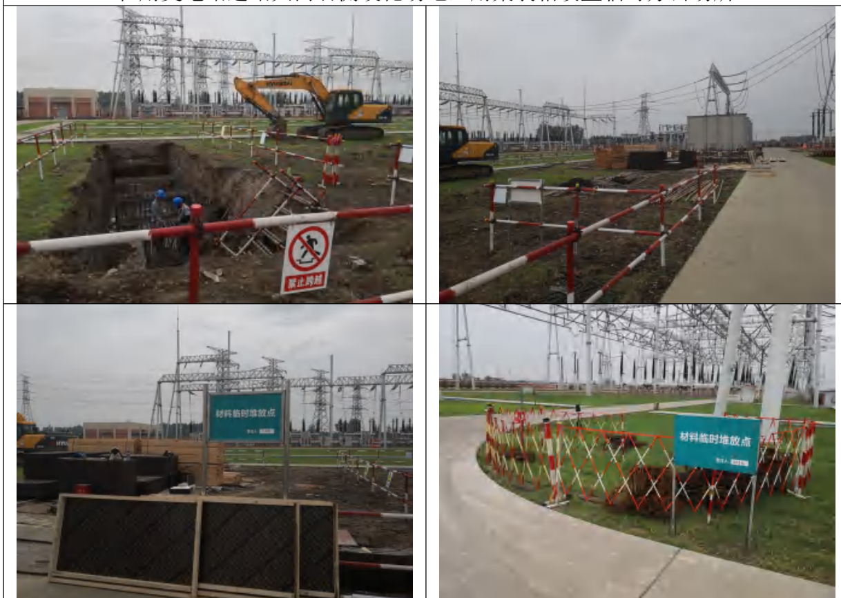
变电站站内设置材料临时堆放点
