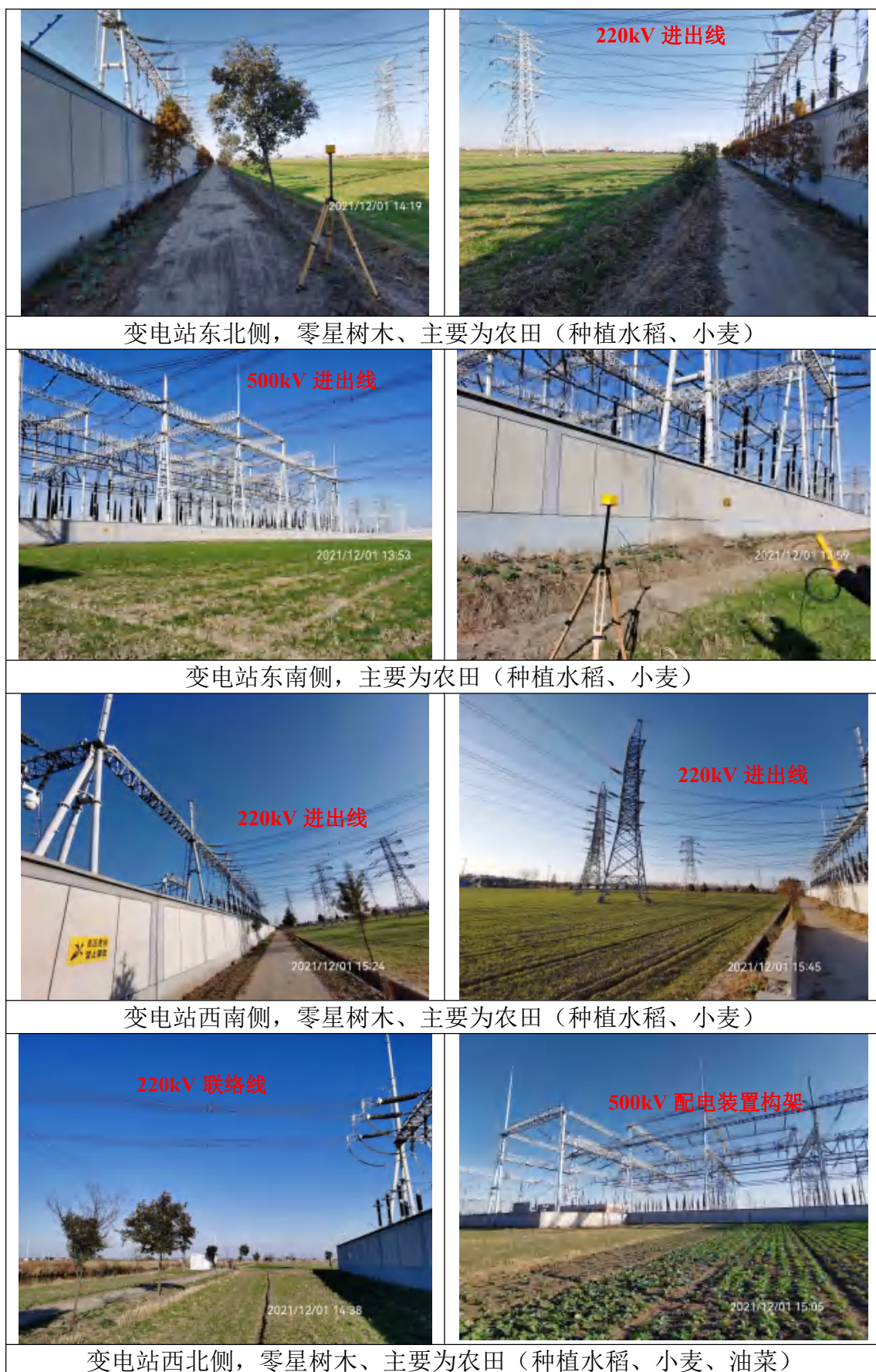
图3.2 (b) 高邮（扬州北）500kV变电站围墙外四周情况
