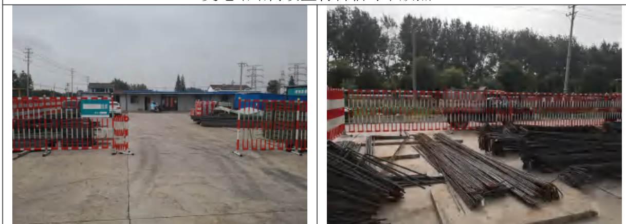
变电站西南侧租用三垛镇柘垛村硬化场地作为材料堆放场地、加工区
