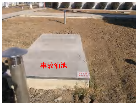
新建1座事故油池（有效容积85m 3 ）
