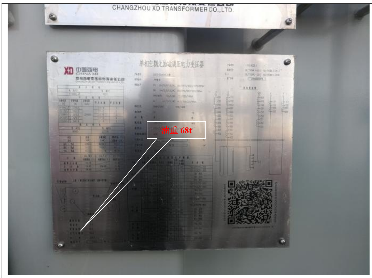
图 10.4 本期扬州高邮（扬州北）500kV 变电站第三台主变单相变压器油量
