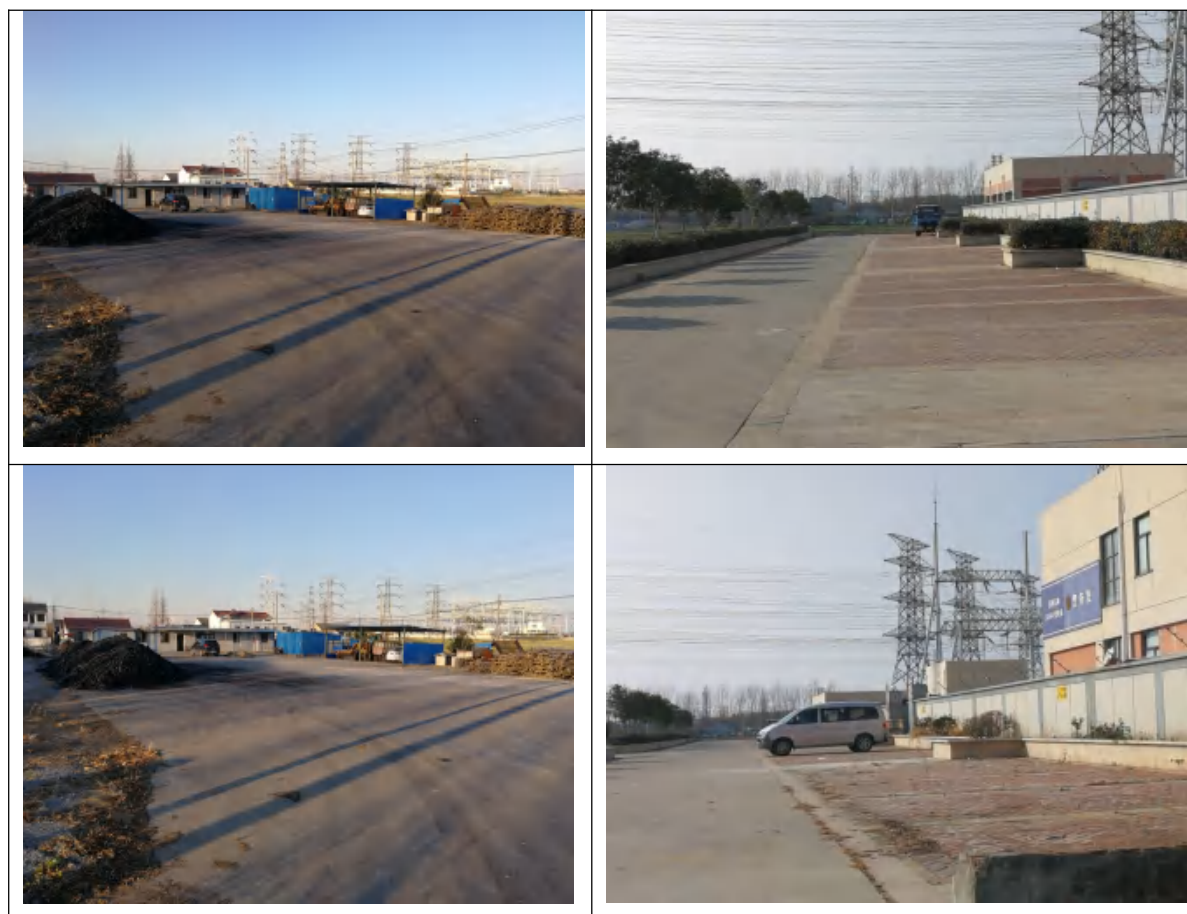
图 6.2 本期变电站主变扩建项目租用临时占地恢复情况
