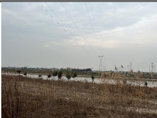
220kV 孙陆 26F9 线#65~#66 一档跨越新通扬运河（姜堰区）清水通道维护区照片
